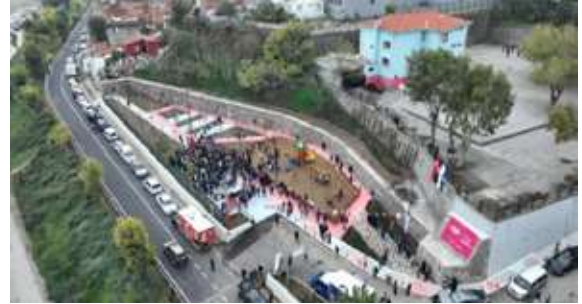
Konak İlçesi Akarcı Mahallesi 1039 Sokak Park Yapımı
