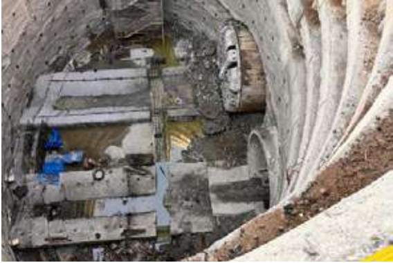
Üçyol Şaft Yapısı
