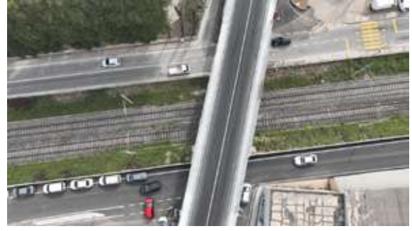
Gaziemir Hava Eğitim Yolu Taşıt Üst Geçidi
