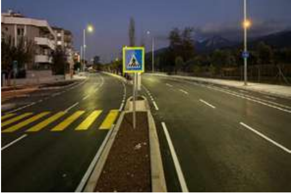
Güzelbahçe İlçesi 75. Yıl Bulvarı Asfalt Serim ve Düzenleme Çalışması
