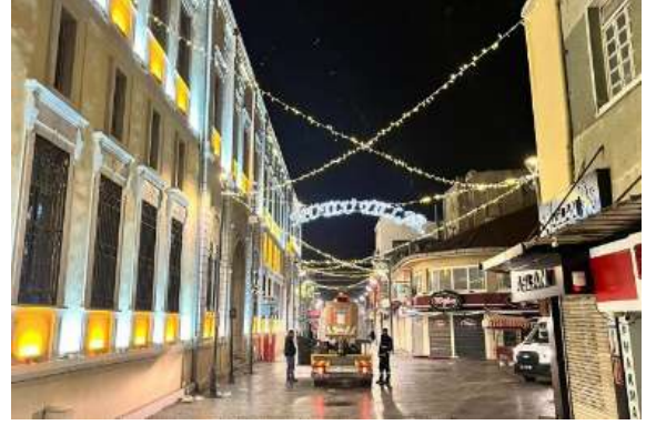
Kemeraltı Giriş Aydınlatma Süsleme Çalışmaları
