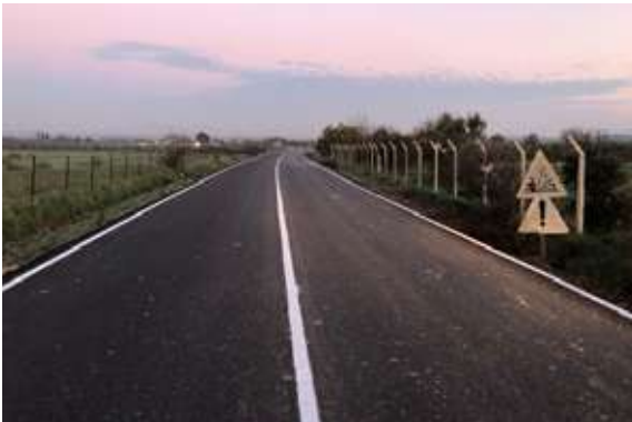
Aliğa İlçesi Çıtak Mahallesi Vatan Caddesi Ana Ulaşım Yolu Asfalt Serim Çalışması
