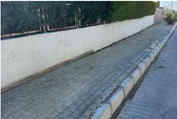
Çeşme İlçesi Celal Bayar Mahallesi 5220 Sokak Kaldırım Yenileme Çalışması
