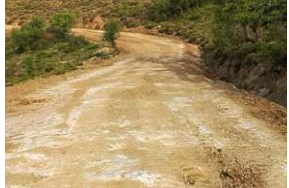
Seferihisar İlçesi Gölcük Mahallesi Üretim Yolları İş Makinesi ile Yol Tesviyesi Çalışması
