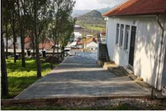
Bergama İlçesi Eğrigöl Mahallesi Hayır Alanı Beton Dökme Çalışması
