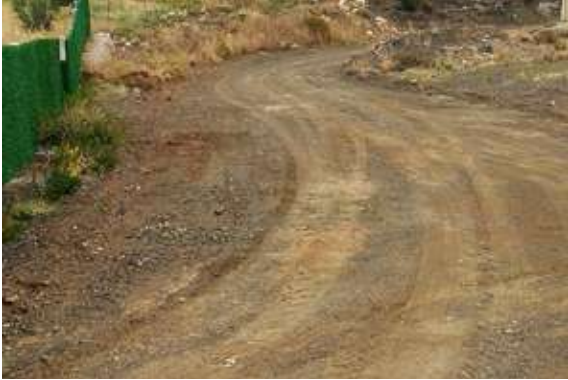
Karaburun İlçesi Hasseki Mahallesi Üretim Yolları İş Makinesi ile Yol Tesviyesi Çalışmaları
