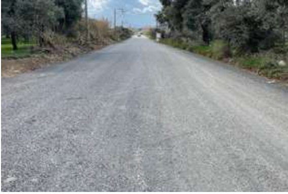
Kiraz İlçesi Ceritler Mahallesi Koca Ceritler Kümesi Asfalt Serim Çalışması
