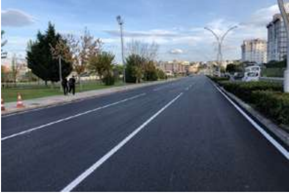
Aliğa İlçesi Atatürk Mahallesi İnönü Bulvarı Asfalt Serim Çalışması
