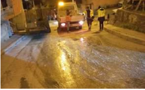
Bayraklı İlçesi Çay Mahallesi 2140 Sokak Tuzlama Çalışması
