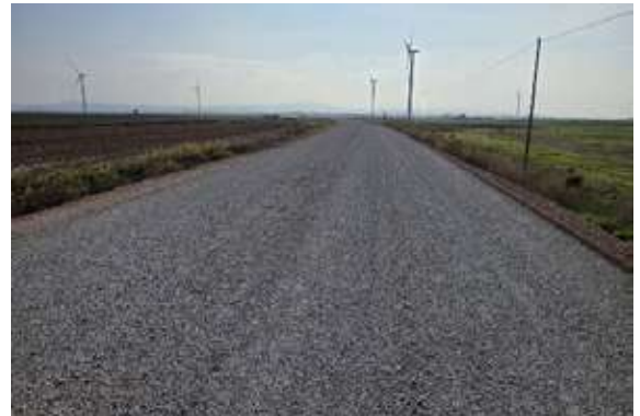
Bergama İlçesi Aşağıkırklar Mahallesi Basbaş Ulaşım Yolu Sathi Kaplama Çalışması
