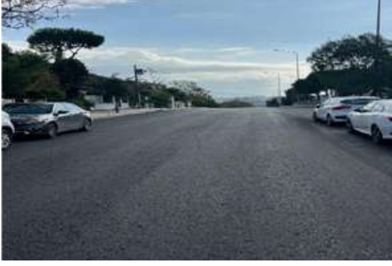
Buca İlçesi Murathan Mahallesi Kazakistan Caddesi Asfalt Serim Çalışması
