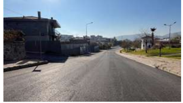
Güzelbahçe İlçesi Yelki Mahallesi Mareşal Fevzi Çakmak Caddesi Asfalt Serim Çalışması
