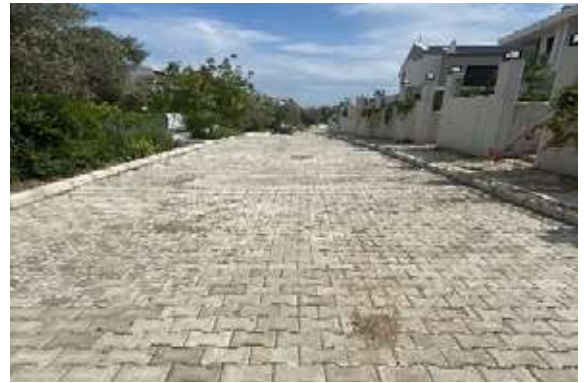
Urla İlçesi Güvendik Mahallesi 218 Sokak Parke Kaplama Çalışması
