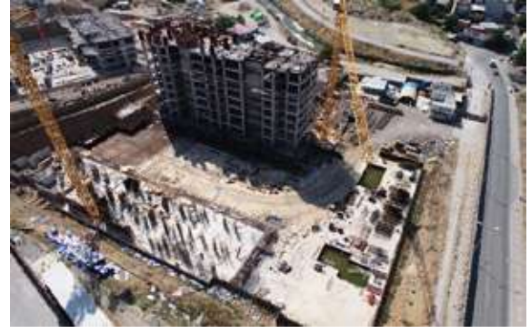
Gaziemir I. Etap Yapım Çalışmaları
