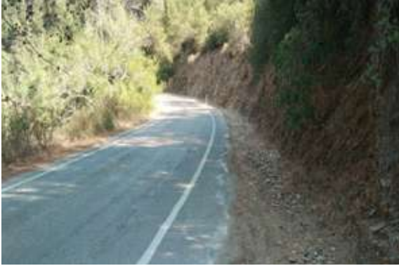
Kemalpaşa İlçesi Bayramlı Mahallesi Ulaşım Yolu Şarmpol Temizliği Çalışması
