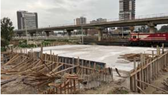
Konak İlçesi Mürselapaşa Alt Geçidi
