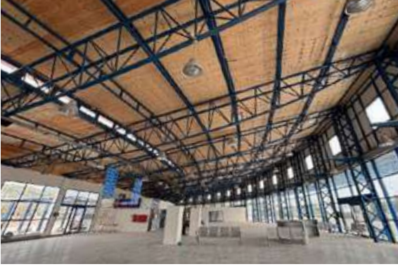
Bergama Şehirlerarası Otobüs Terminali Bakım ve Onarım Çalışması
