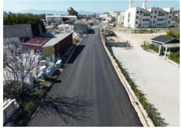
Urla İlçesi Torasan Mahallesi 623/1 Sokak Asfalt Serim Çalışması
