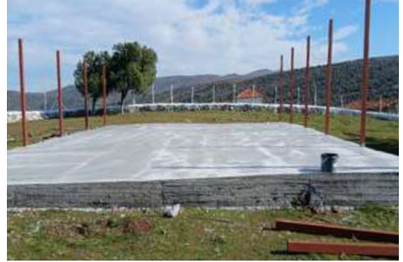
Bergama İlçesi Rahmanlar Mahallesi Hayır Alanı Zemini Beton Dökme Çalışması
