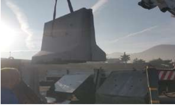
Beton Bariyer İmalatı
