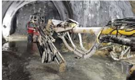
Narlıdere Depolama Tesisi Bağlantı Tüneli
