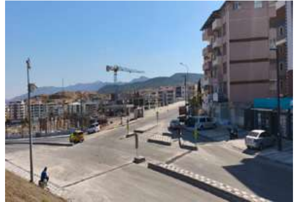
Aliğa İlçesi Yeni Mahalle Güzelhisar Caddesi Samurlu Kavşağı Düzenleme Çalışması
