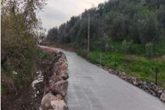
Bergama İlçesi Narlıca Mahallesi Çevre Yolu Beton Dökme Çalışması
