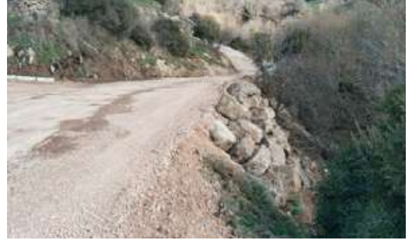
Bornova İlçesi Çamiçi Mahallesi Yayla Üretim Yolu Tesviye Çalışması
