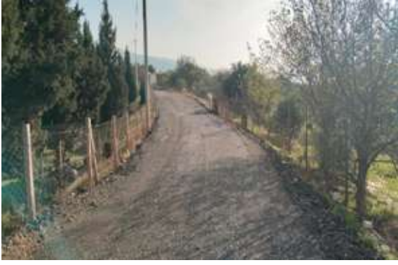
Kemalpaşa İlçesi Sütçüler Mahallesi Efeler Sokak Ulaşım Yolu Yol Tesviyesi Çalışması
