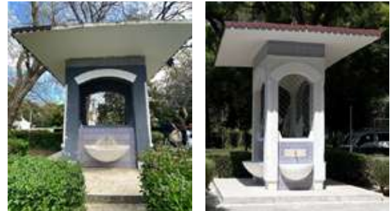
Dalmas&Marseille Çeşmesi Restorasyonu
