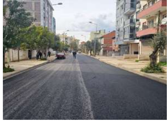
Ödemiş İlçesi Üç Eylül Mahallesi Tavaslı Caddesi Asfalt Serim Çalışması
