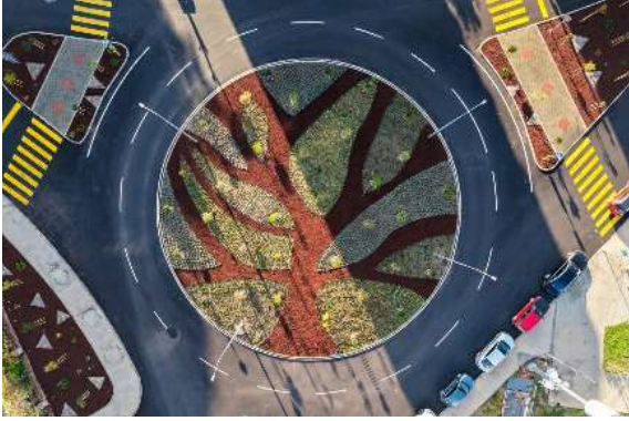
Narlıdere Metro İstasyon Kavşağı Kurakçıl Peyzaj Düzenleme Çalışmaları
