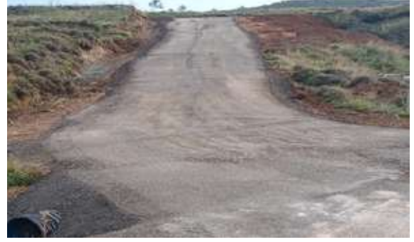
Çiğli İlçesi Cumhuriyet Mahallesi 447 Parsel Yolu Açma Çalışması
