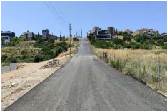
Çeşme İlçesi Musalla Mahallesi 1139 Sokak Asfalt Serim Çalışması
