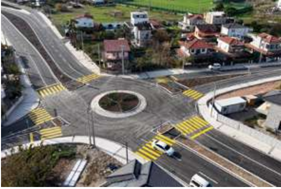
Urla İlçesi Torasan Mahallesi Kemal Ertan Caddesi Tretuvar ve Yol Düzenleme Projesi
