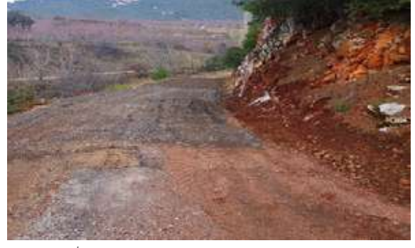
Kemalpaşa İlçesi Beşpınar Mahallesi Derealan Mevkisi Yol Açma Çalışması
