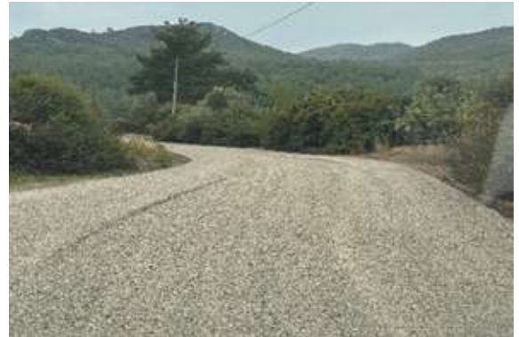
Menderes İlçesi Kuyucak Mahallesi Sathi Kaplama Çalışması
