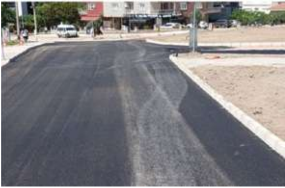
Narlıdere İlçesi Huzur Mahallesi Açelya Sokak Kaymakamlık Metro Önü Asfalt Serim ve Düzenleme Çalışması
