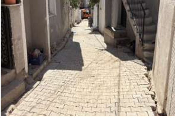
Bergama İlçesi Atmaca Mahallesi Mahalle İçi Ulaşım Yolu Kilit Parke Döşeme Çalışması
