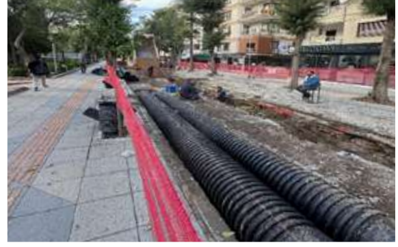
Bornova İlçesi Süvari Caddesi Yağmur Suyu ve Kanalizasyon Çalışması
