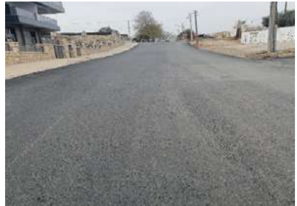
Urla İlçesi Camiatik Mahallesi Dört Yol Sokak Asfalt Serim Çalışması
