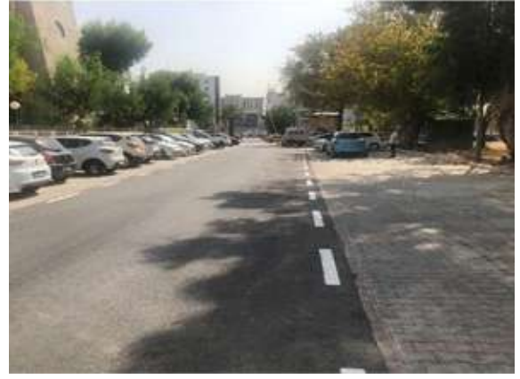
Konak İlçesi Şapar Murat Türkmenbaşı Caddesi Adliye Otoparkı Kaldırım Düzenleme Çalışmaları
