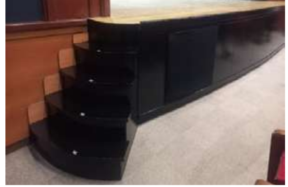
Kültürpark İzmir Sanat Merkezi Bakım ve Onarım Çalışması
