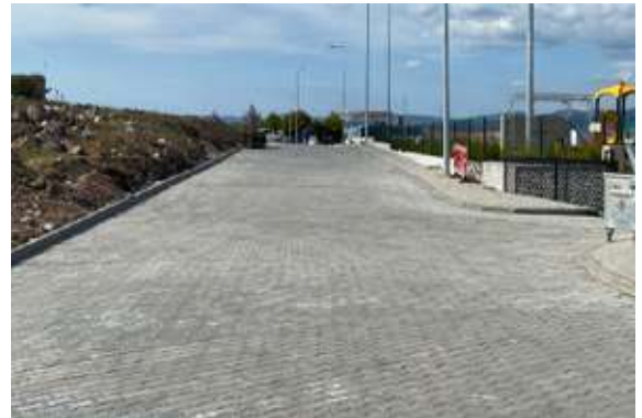
Dikili İlçesi Salimbey Mahallesi Düğün Salonu Ulaşım Yolu Kilit Parke Döşeme Çalışması
