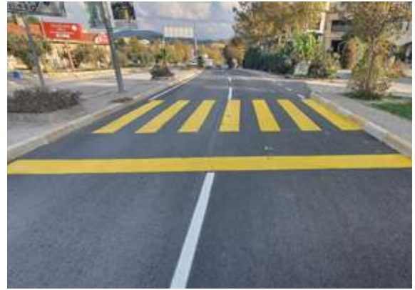
Urla İlçesi Yelaltı Mahallesi Nur Dikmen Caddesi Asfalt Serim Çalışması
