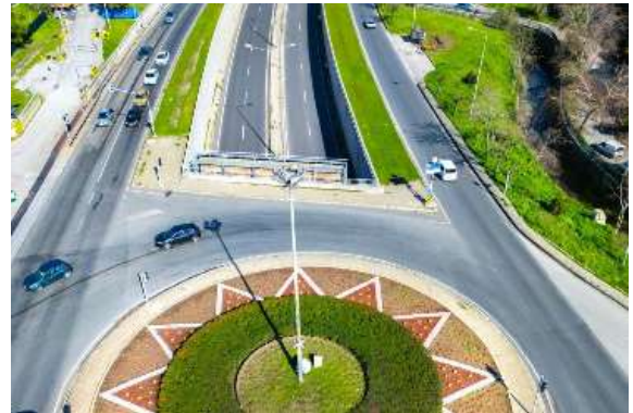
Kuzey Alanları Bakım Çalışmaları
