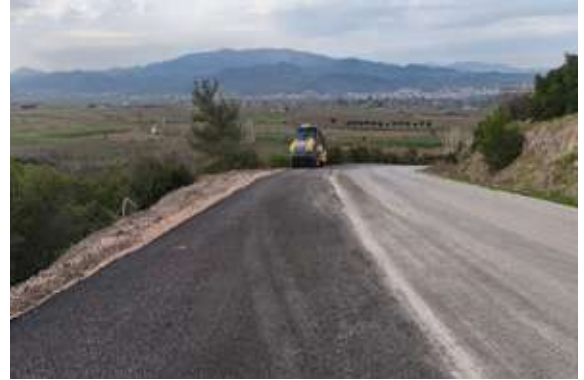
Bergama İlçesi Armağanlar Mahallesi Katı Atık Tesisi Ulaşım Yolu Sıcak Asfalt ile Yol Genişletme Çalışması
