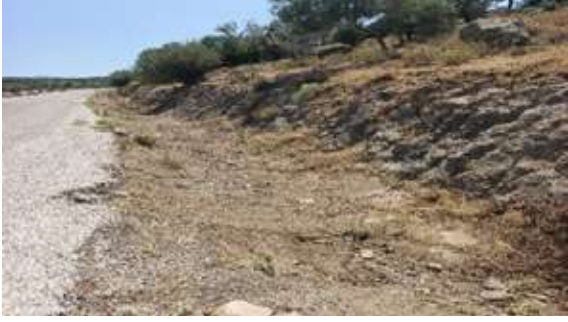
Menemen İlçesi Çaltı Mahallesi Ulaşım Yolu Şarmpol Temizliği Çalışması
