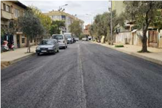
Ödemiş İlçesi Üç Eylül Mahallesi Millet Caddesi Asfalt Serim Çalışması
