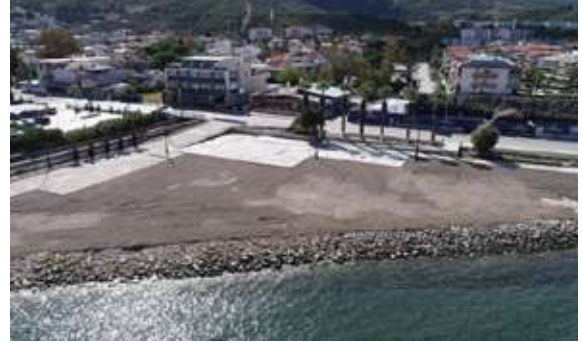
Güzelbahçe İlçesi Maltepe Mahallesi Sosyal Tesis Yapımı
