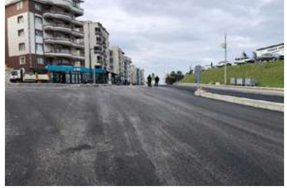
Aliğa İlçesi Yeni Mahalle Güzelhisar Caddesi Samurlu Kavşağı Asfalt Serim Çalışması
