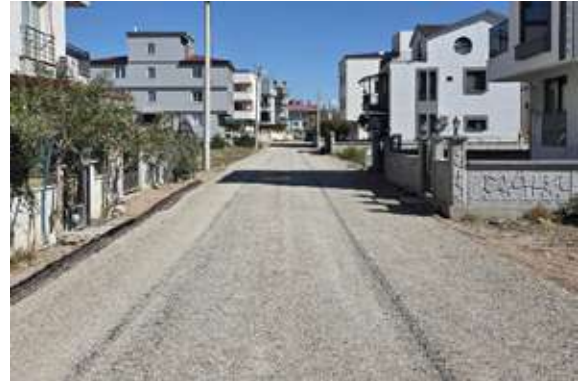
Bergama İlçesi Fatih Mahallesi Muhtelif Cadde ve Sokaklarda Sathi Kaplama Çalışması
