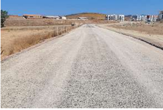
Seferihisar İlçesi Camikebir Mahallesi Karakayalar Sokak Sathi Kaplama Çalışması
