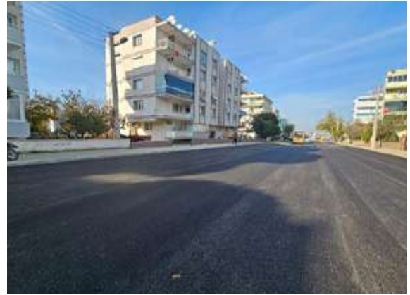
Tire İlçesi Adnan Menderes Mahallesi Rafet Saygılı Caddesi Asfalt Serim Çalışması
