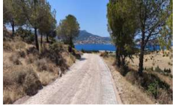
Aliğa İlçesi Çakmaklı Mahallesi Su Deposu Ulaşım Yolu Kilit Parke Döşeme Çalışması
