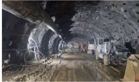
Narlıdere Depolama Tesisi Bağlantı Tüneli
