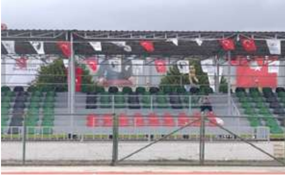
Gazimir İlçe Stadı Tribün Yenileme Çalışması
