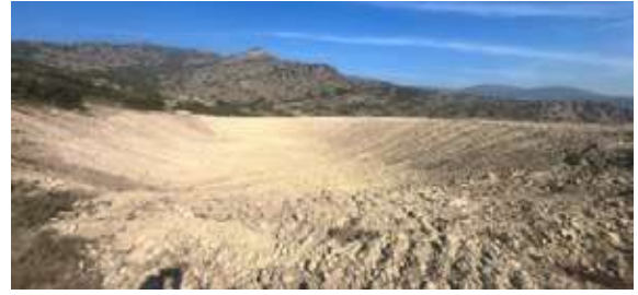
Menemen İlçesi Haykiran Mahallesi Hayvan İçme Suyu Göleti Genişletme Çalışması
