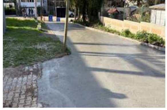
Aliğa İlçesi Çakmaklı Mahallesi Zeytin Sokak Ulaşım Yolu Beton Dökme Çalışması
