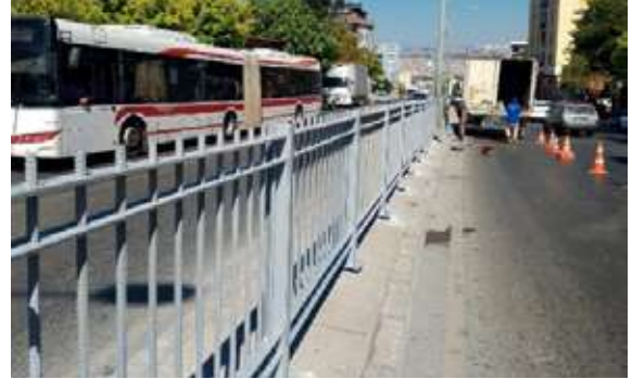
Orta Refüj Korkuluklarının Bakım Onarım ve Montaj Çalışmaları
