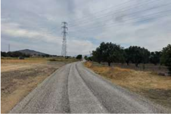
Dikili İlçesi Demirtaş Mahallesi Üretim Yolu Sathi Kaplama Çalışması
