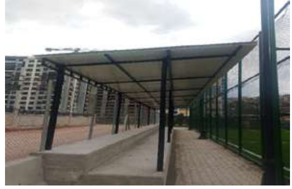
Karşıyaka İlçesi Örnekköy Mahallesi 26921 Ada 3 Parsel Futbol Sahası Alan Düzenleme Çalışması
