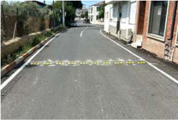
Seferihisar İlçesi Tepecik Mahallesi Tepecik Caddesi 108 ve 105/1 Sokaklar Asfalt Serim Çalışmaları
