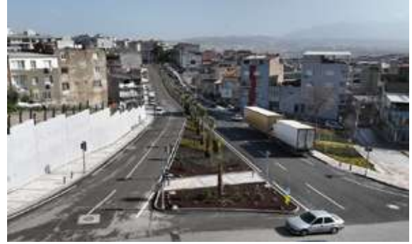
Karabağlar İlçesi Dostluk Bulvarı-Eski İzmir Caddesi Arası İmar Yolları Yapımı
