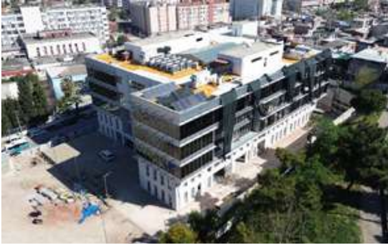
Belediye Ek Hizmet Binası
