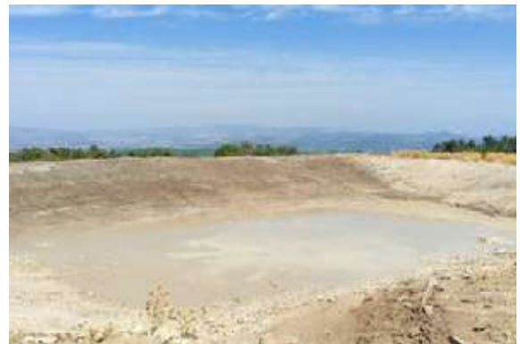
Menemen İlçesi Bozalan Mahallesi Hayvan İçme Suyu Göleti Genişletme Çalışması
