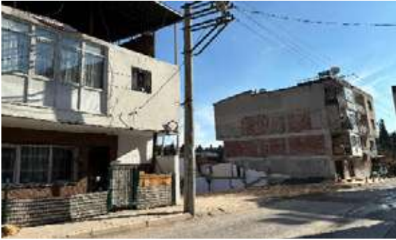
Konak İlçesi Saygı Mahallesi Toros Caddesi No:213 Yıkım Çalışması
