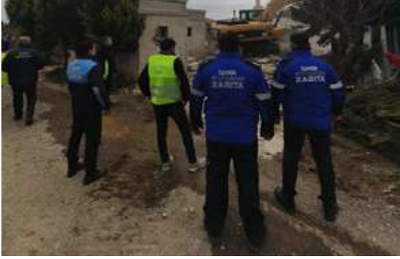
Yapı Yıkım Çalışmaları
