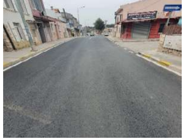
Urla İlçesi Altıntaş Mahallesi Zafer Caddesi Asfalt Serim Çalışması
