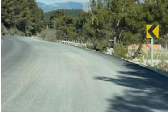
Buca İlçesi Şehit Er Zeki Toker Caddesi Asfalt Serim Çalışması
