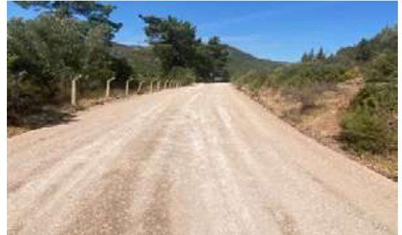
Menderes İlçesi Kuyucak Mahallesi Üretim Yolu Tesviye Çalışması
