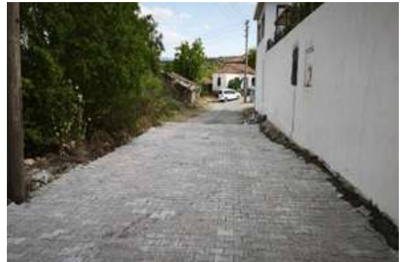
Bergama İlçesi Kaşıkçı Mahallesi Mahalle İçi Ulaşım Yolları Kilit Parke Döşeme Çalışması
