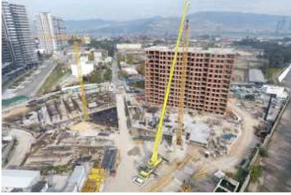
Ege Mahallesi I. Etap Yapım Çalışmaları
