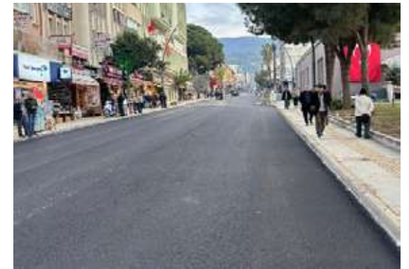
Tire İlçesi Yeni Mahallesi Atatürk Caddesi Asfalt Serim Çalışması
