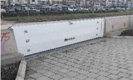
Konak İlçesi Alsancak Mahallesi 1. Kordon Geçici Fırtına Duvarı Yapım Çalışması
