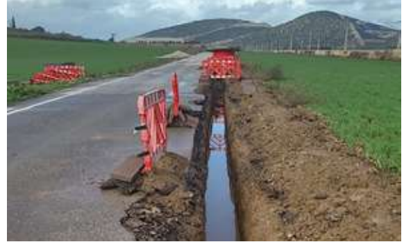
Selçuk İlçesi 12532 Sokak GES Altyapı Çalışması
