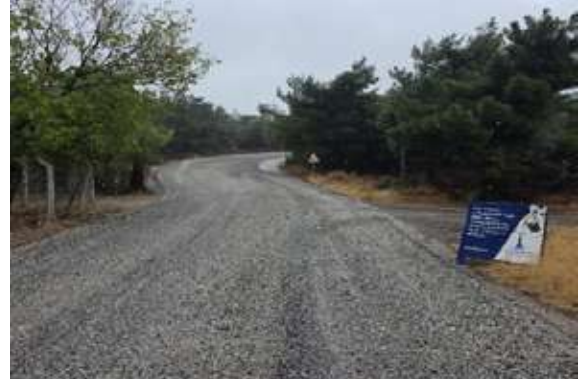
Bergama İlçesi Saridere Mahallesi Ulaşım Yolu Sathi Kaplama Çalışması
