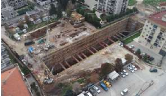
Çamlıkule İstasyonu Makas Yapısı
