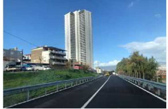
Konak İlçesi Kocakapı Mahallesi 1039 Sokak Asfalt Serim Çalışması
