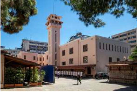
Konak, Ahmet Piriştina Kent Arşivi ve Müzesi (Apikam) Binası Restorasyonu
