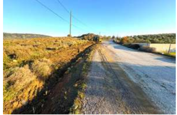
Seferihisar İlçesi Turgut ve İhsaniye Mahallesi Arası Ulaşım Yolu Şarmpol Temizliği Çalışması
