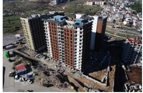
Gaziemir II. Etap Yapım Çalışmaları
