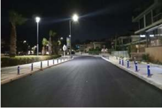
Narlıdere İlçesi Sahilevleri Mahallesi Gürlü Caddesi Asfalt Serim Çalışması
