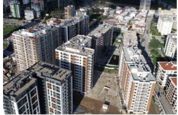
Örnekköy IV. Etap Yapım Çalışmaları
