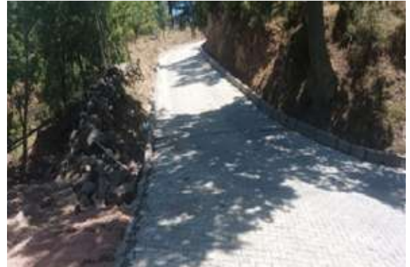
Kınık İlçesi Örtülü Mahallesi Hayır Alanı Ulaşım Yolu Kilit Parke Döşeme Çalışması
