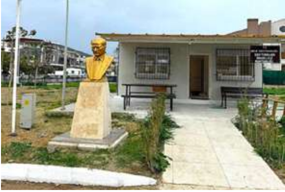
Urla İlçesi Zeytinlanı Mahallesi Muhtarlık Ofisi İmalatı
