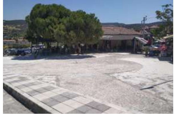
Foça İlçesi Kozbeyli Mahallesi Meydan Düzenleme Çalışması
