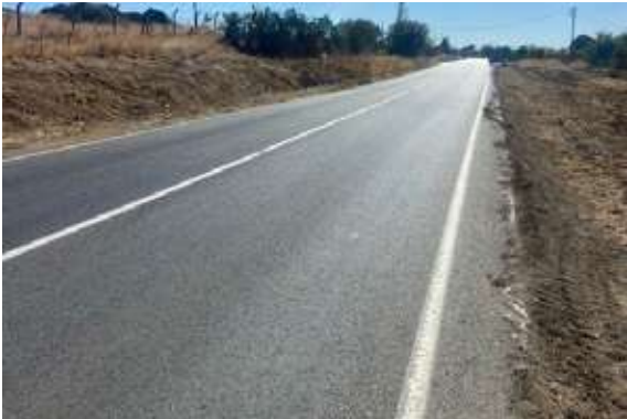
Menderes İlçesi Yeniköy Mahallesi Ulaşım Yolu Şarmpol Temizliği Çalışması
