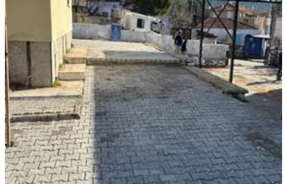
Bergama İlçesi Kaplan Mahallesi Hayır Alanı Kilit Parke Döşeme Çalışması
