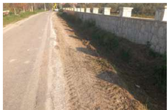
Urla İlçesi İçmeler Mahallesi Tekke Caddesi Şarmpol Temizliği Çalışması
