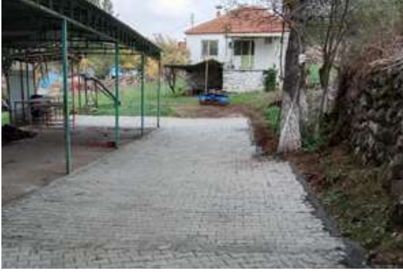
Bergama İlçesi Tavukçukuru Mahallesi Hayır Alanı Kilit Parke Döşeme Çalışması
