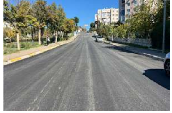
Buca İlçesi Çağdaş Mahallesi Ali Şir Nevai Caddesi Asfalt Serim Çalışması
