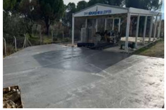
Bergama İlçesi Kiranlı Mahallesi Hayır Alanı Zemini Beton Dökme Çalışması
