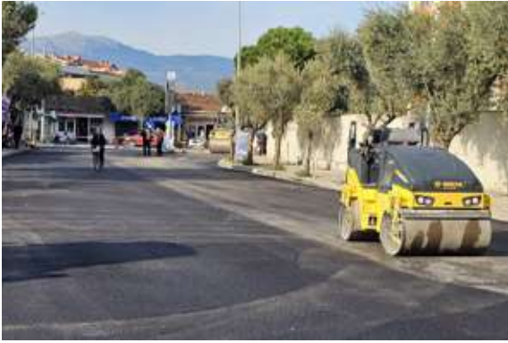
Ödemiş İlçesi Üç Eylül Mahallesi Emmioğlu Caddesi Asfalt Serim Çalışması
