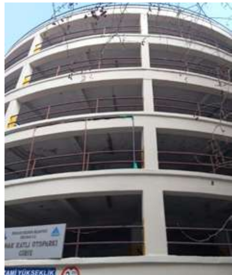
Konak Center Otopark Binası Dış Cephe Boyama Çalışması
