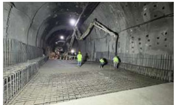
Buca ile Bornova İlçelerini Birbirine Bağlayan Tünelin ve Ara Bağlantı Yollarının Yapımı
