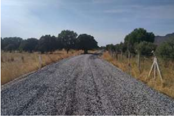
Dikili İlçesi Gökçeaağıl-Kıratlı Mahallesi Arası Ulaşım Yolu Sathi Kaplama Çalışması
