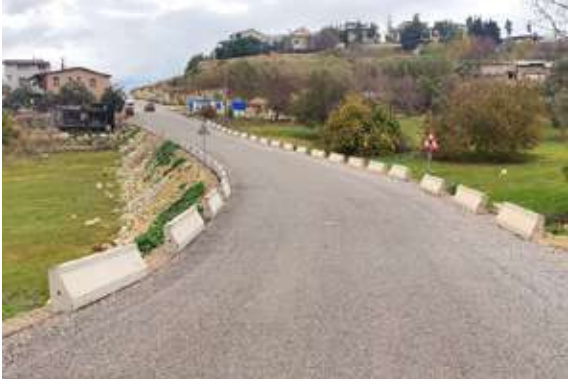
Urla İlçesi Naipli Mahallesi Beton Bariyer Döşeme Çalışması
