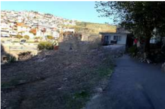
Konak İlçesi Vezirağa Mahallesi 2251 Sokak Yıkılan Binaların Moloz Kaldırma Çalışması
