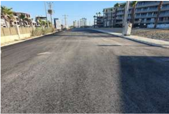
Çeşme İlçesi 16 Eylül Mahallesi 3394 Sokak Asfalt Serim Çalışması
