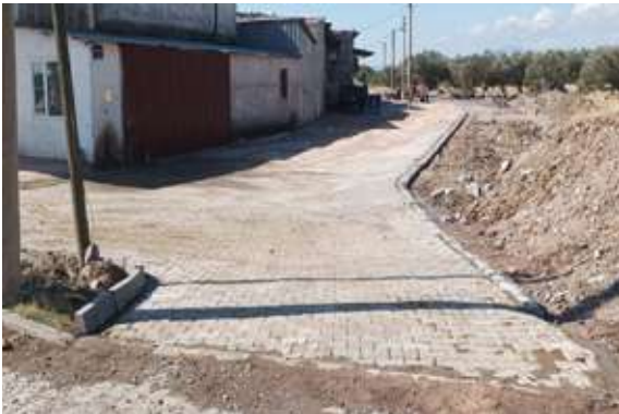
Bergama İlçesi Göçbeyli Mahallesi Sanayi Caddesi Kilit Parke Döşeme Çalışması
