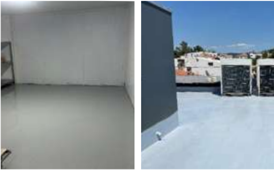
Urla Yerel Hizmet ve Buca Aşevleri Belediye Binalarında Yalıtım Çalışmaları
