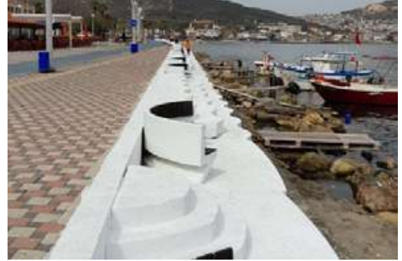
Yeni Foça Sahil Beton Seyir Terasları Boyanması ve 104 Adet Aydınlatma Lambasının Değişim Çalışmaları
