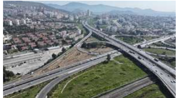
Çiğli KöprülÜ Kavşağı, Karşıyaka Örnekköy Kavşağı Düzenleme Çalışmaları
