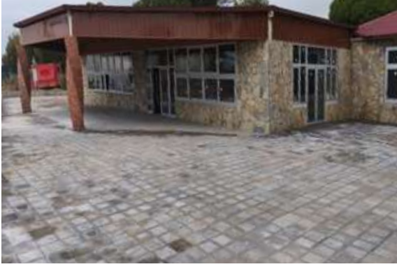
Dikili İlçesi Çandarlı Mahallesi İBB Kamp Alanı İçi Kilit Parke Döşeme Çalışması
