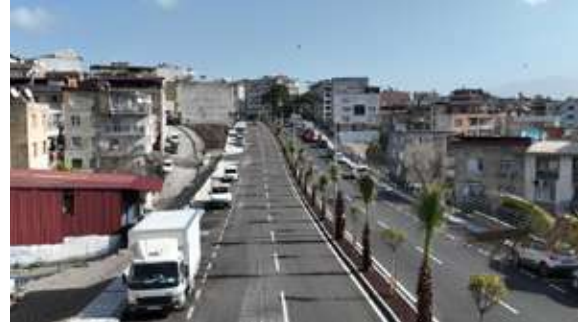
Karabağlar İlçesi Dostluk Bulvarı-Eski İzmir Caddesi Arası İmar Yolları Yapımı
