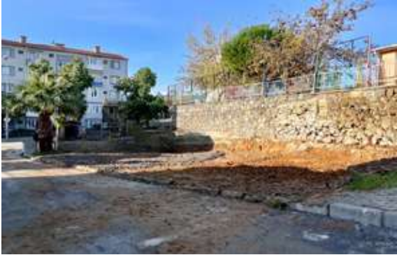
Gazimür İlçesi Yeşil Mahallesi 85 Sokak No: 6 Yıkım Çalışması
