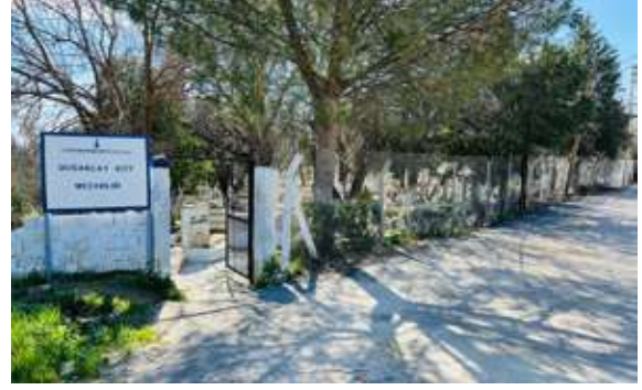
Doğançay Köy Mezarlığı Mezarlık Tel Çit Yapımı
