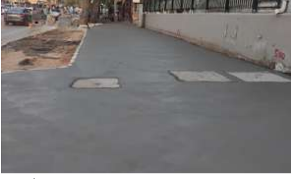
Konak İlçesi Yenişehir Mahallesi Gaziler Caddesi 1145/6 Sokak Kavşak ve Kaldırım Düzenleme Çalışması
