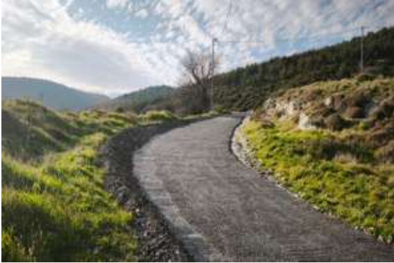
Aliğa İlçesi Güzelhisar Mahallesi Su Deposu Ulaşım Yolu Beton Dökme Çalışması
