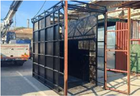
Zürafa Nakliye Kafesi İmalatı
