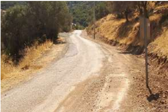
Karaburun İlçesi Kösedere Mahallesi Şarmpol Temizliği Çalışması
