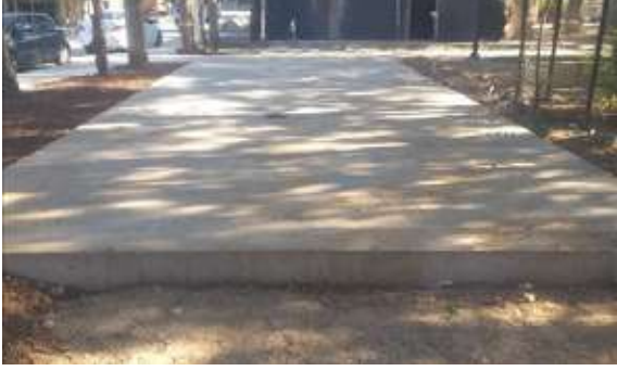
Buca İlçesi Kozağaç Mahallesi Fırat Yılmaz Çakıroğlu Parkı Düzenleme Çalışması
