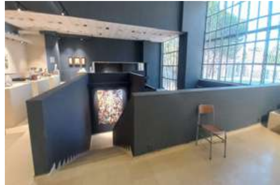
Kültürpark Mehmet Tüzüm Kızılcan Sanat Galerisi Bakım ve Onarım Çalışması
