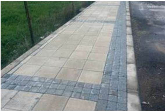
Güzelbahçe İlçesi Yalı Mahallesi 75. Yıl Cumhuriyet Bulvarı Tretuvar Düzenleme Çalışması
