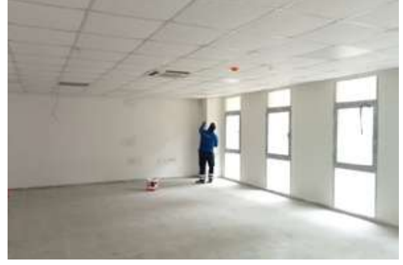
Buca Sosyal Yaşam Engelli Merkezi Bakım ve Onarım Çalışması
