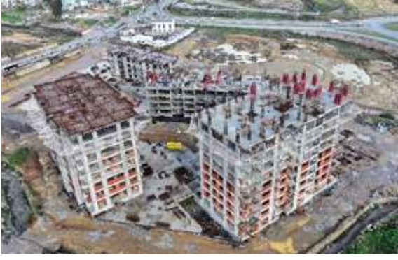
Uzundere III. Etap Yapım Çalışmaları
