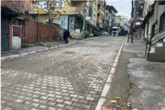
Konak İlçesi Millet Mahallesi Samsun Caddesi 2564-2566 Sokak Kilit Parke Çalışmaları
