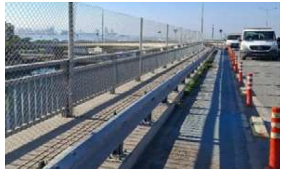
Tel ve Panel Çit Montaj Çalışmaları
