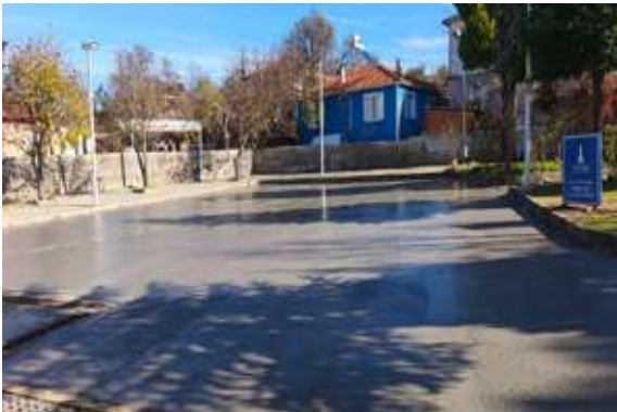
Bergama İlçesi Karaveliler Mahallesi Hayır Alanı Zemini Beton Dökme Çalışması
