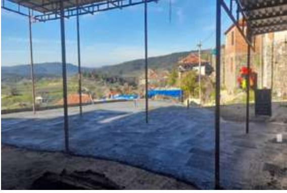
Kınık İlçesi Köseler Mahallesi Hayır Alanı Zemini Beton Dökme Çalışması
