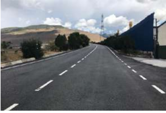
Aliğa İlçesi Helvacı Mahallesi Ana Ulaşım Yolu Asfalt Serim Çalışması
