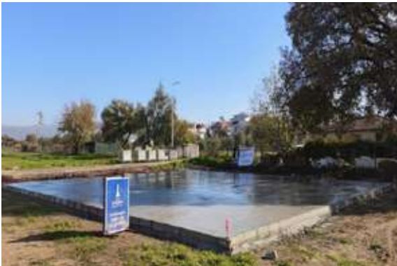
Dikili İlçesi Salihleraltı Mahallesi Çocuk Oyun Parkı Zemini Beton Dökme Çalışması
