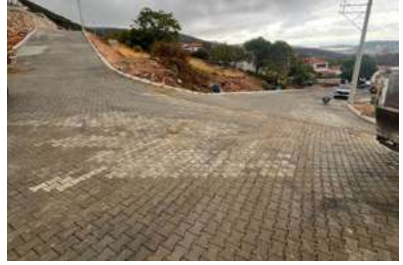
Karaburun İlçesi Saip Mahallesi Eski Okul ve 3231 Sokak Parke Kaplama Çalışması
