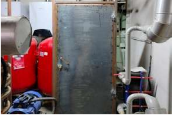
Halkapınar Meslek Fabrikası Bakım ve Onarım Çalışması
