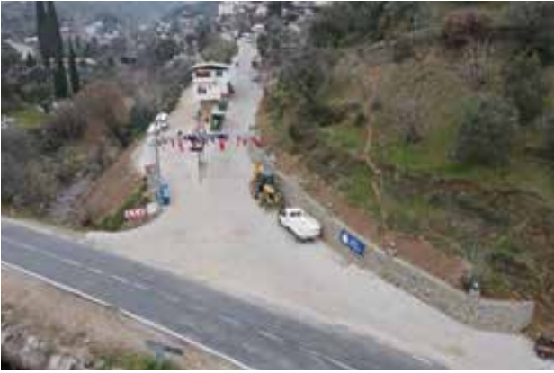
Işıklar Mah. Yol bakım Çalışmaları
