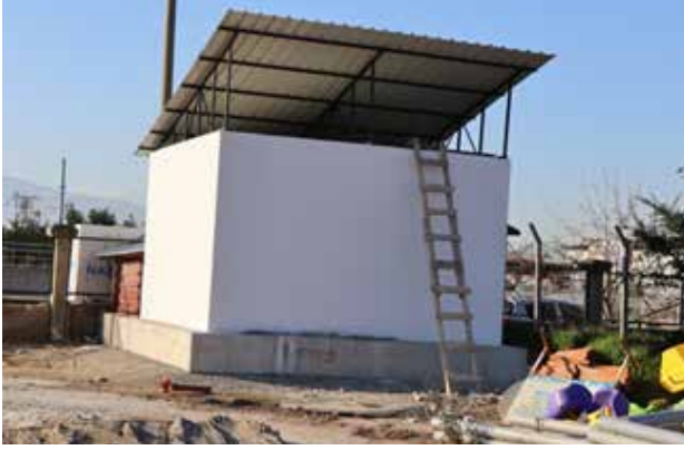
Yeni Sanayi Mah. 40 tonluk su deposu yapımı
