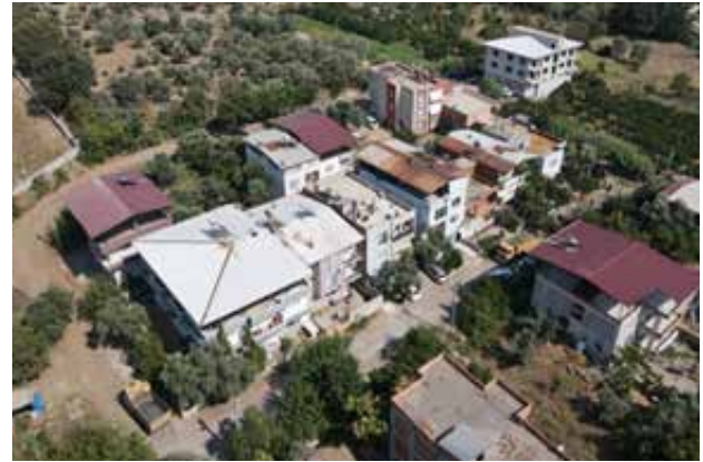
Bozyurt Mah. Yol Yapım Çalışmaları
