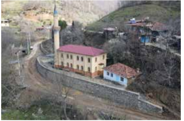
Kuşçular Mah. istinat duvarı yapımı
