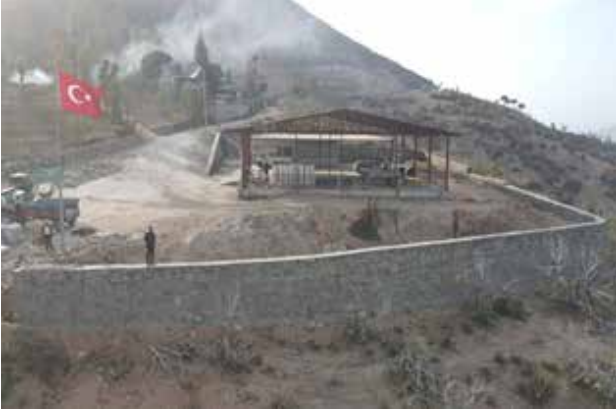
Ovacık Mah. düğün alanı etrafı istinat duvarı yapımı
