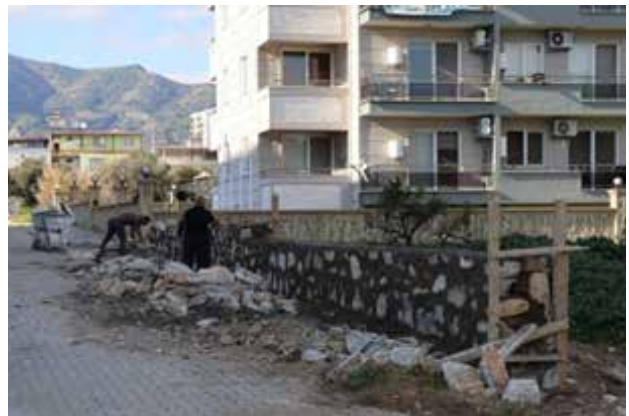
İsabeyli mah. Su deposu yanı istinat duvarı
