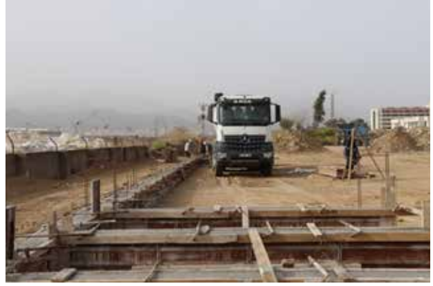
Katı Atık Toplama Birimi İnşaatı
