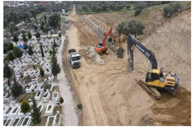
Eğriboyun Mezarlığı genişletme çalışmaları
