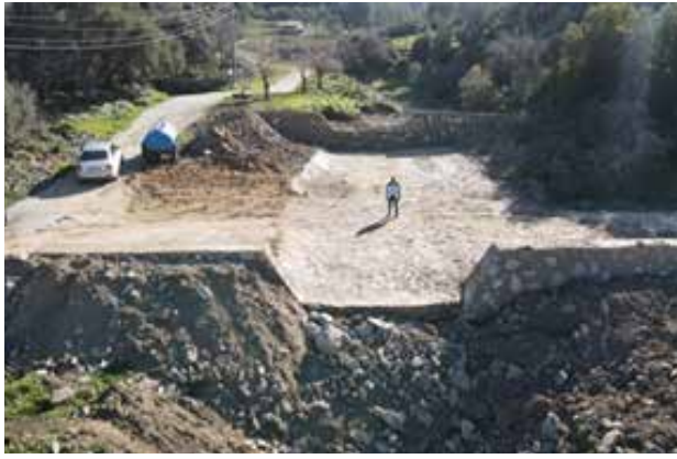
Dualar mah. Ocak taşı ile harçlı su bendi yapılması
