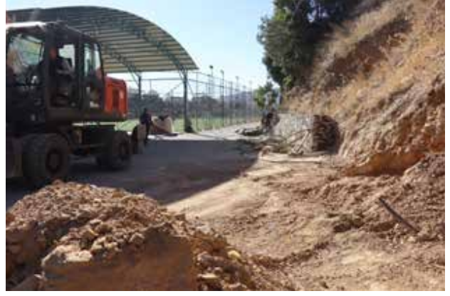
Aşağı Örencik Mah. Düğün Alanı yanı istinat duvarı yapımı
