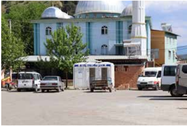
Bayındır Mah. Caminde WC ve Gasilhane Yapımı
