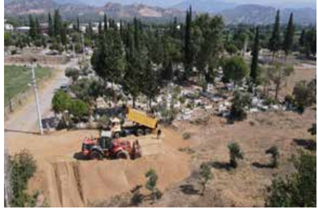
Arslanlı Mezarlığı genişletme çalışmaları
