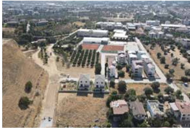
İsabeyli Mah. Yeni Yol Açma Çalışmaları
