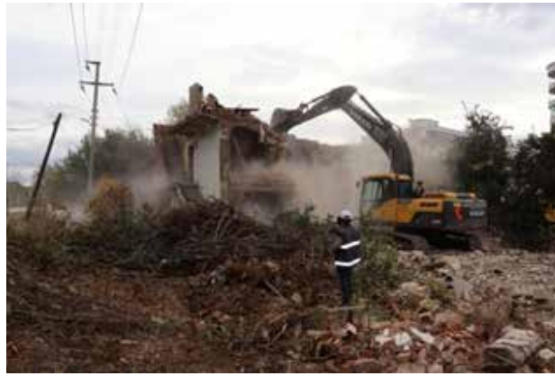
Yeşil Mah. metruk Bina yıkımları
