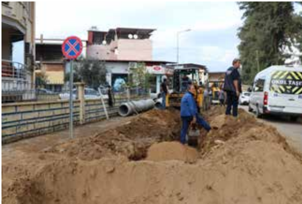
Yeşil Mah. 622 ve 622/1 Sok yağmurlama hattı döşeme
