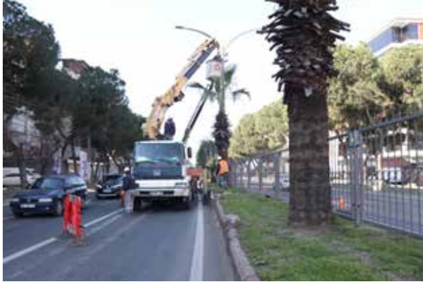
E87 Yolu Işıklandırma ve yenileme çalışmaları
