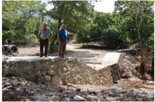
Haydarlı Mah. Dere geçişlerine istinat duvarı yapım işi
