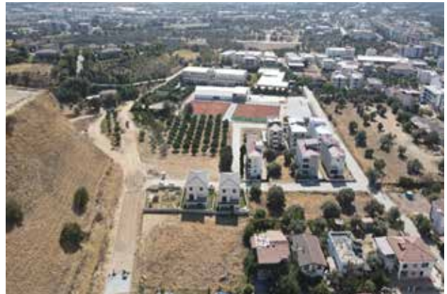
İsabeyli Mah. Yol Açma Çalışmaları
