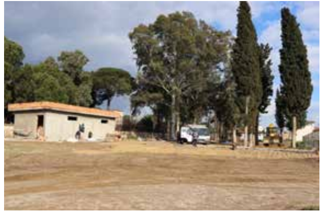
Sümer Deve Güreşi sahasına bay-bayan WC yapımı
