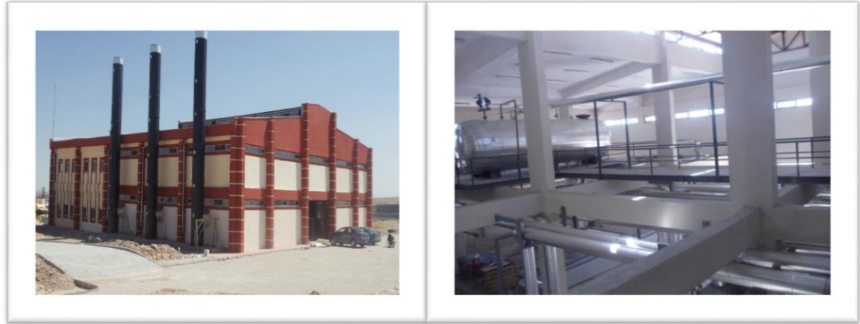
Şekil 22: Isı Merkezi Dış ve İç Görünümü
