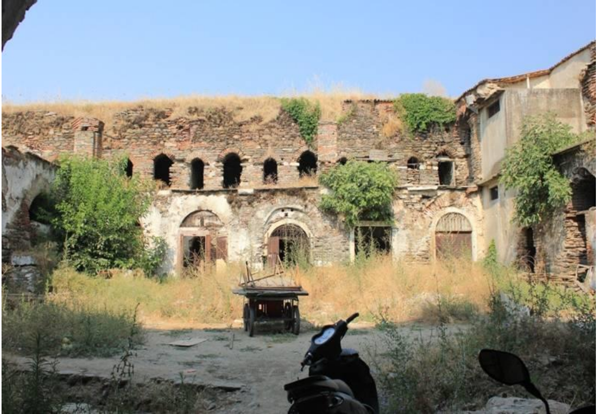
KUTUHAN İÇ MEKAN RESTORASYON ÖNCESİ
