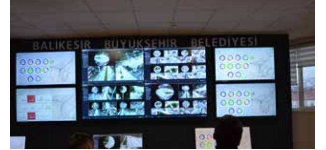
Trafik Kontrol Merkezi | Önceki Hâli
