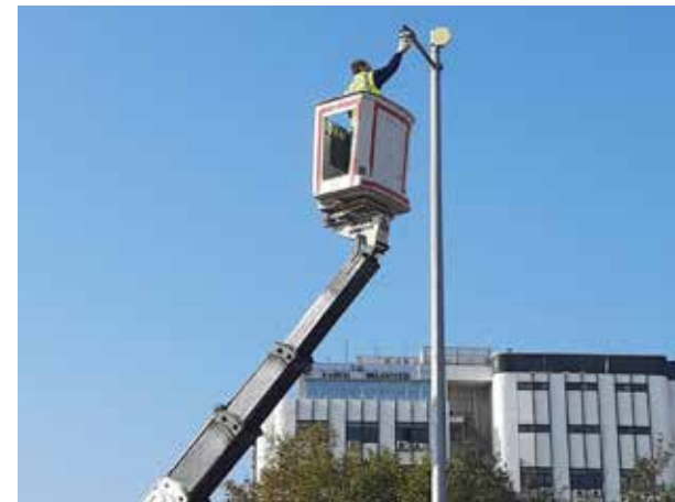
İstasyon Kavşağı (Trafik Kamerası Bakım, Onarım Çalışması)
