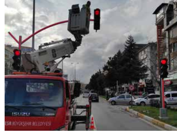
-Bandırma Caddesi Eski Vali Konağı Kavşağı (Sinyalizasyon Sistemi Bakım, Onarım Çalışması)
