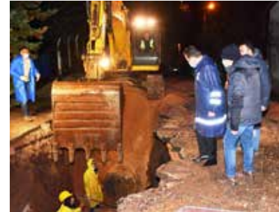
İkizcetepeler Barajı'ndan su sağlayan 5 bin 604 metrelik su hattı, tamamen yenilendi.
