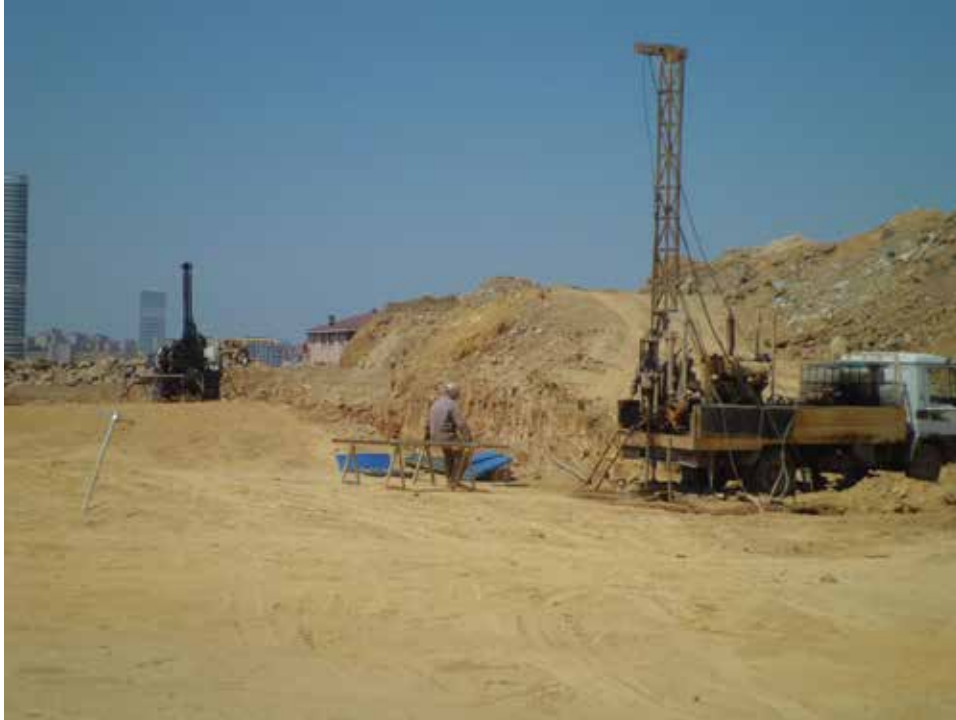
Sondaj çalışmasında sondaj makinasından karotiyerden numune çıkarılması
