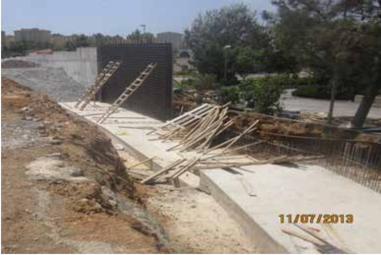
Küçükbakkalköy Mahallesi İstinad duvarı Çalışması
