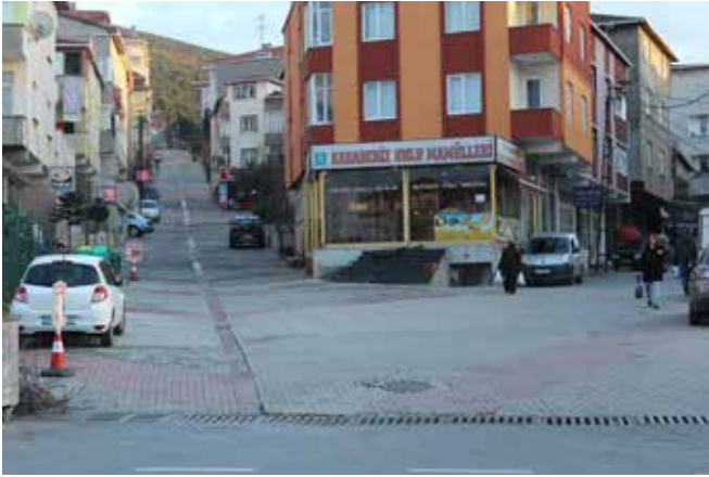
Kayıdağı Mahallesi Çoban Çeşme Sokak Yol Kaplama Çalışması.
