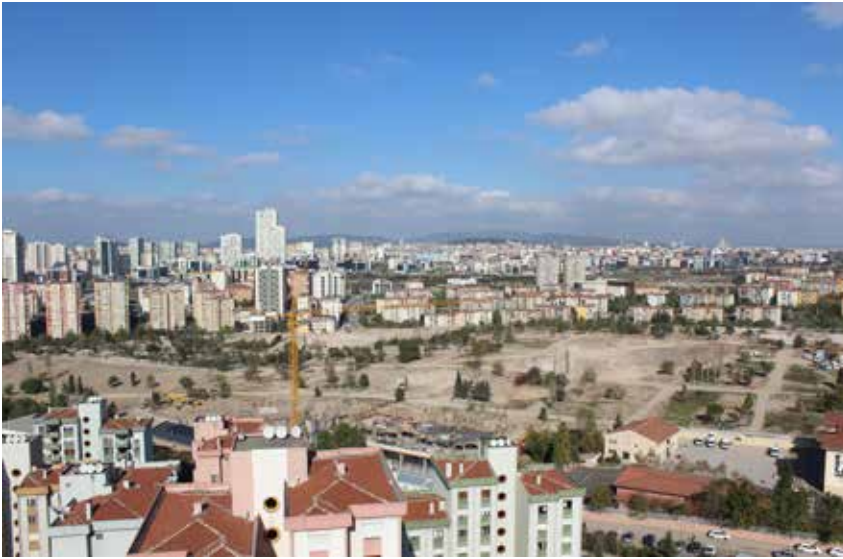
Emekevler Bölgesi Kentsel Dönüşüm İnşaatı
