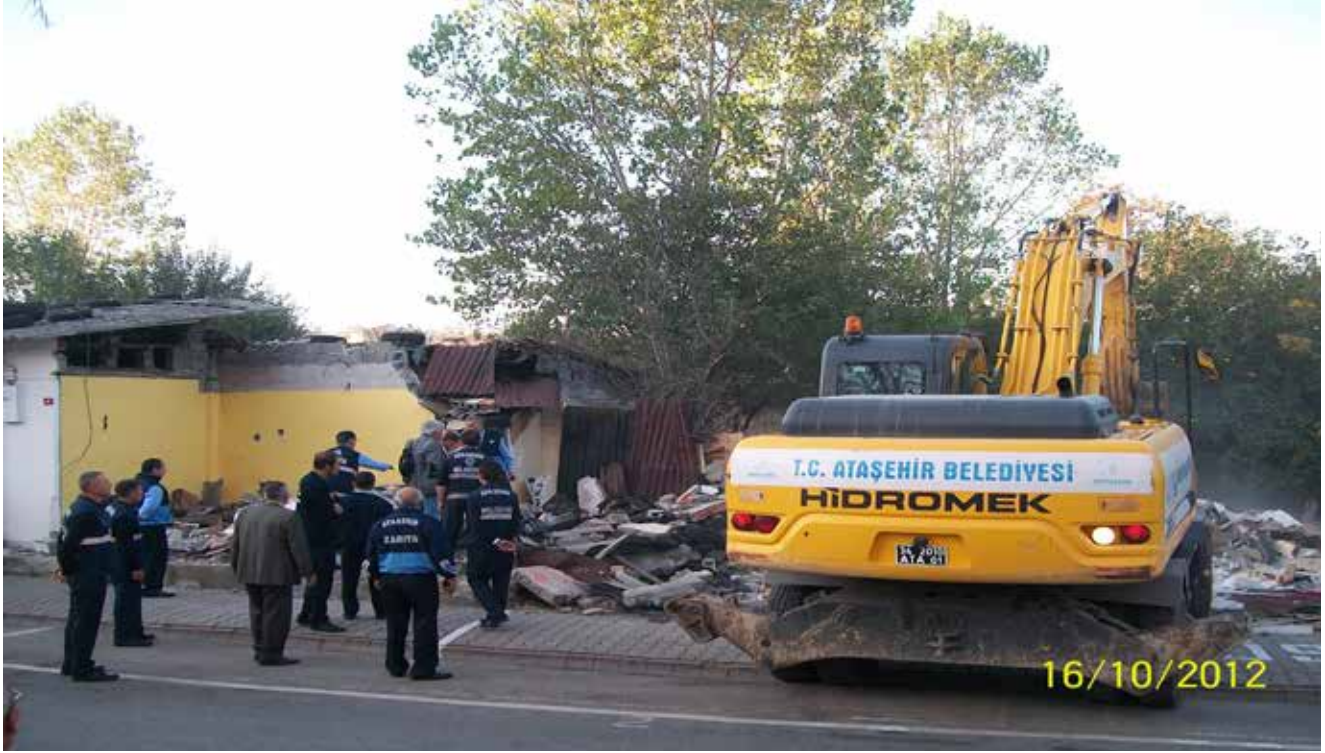
Gecekondu yıkım işlemleri
