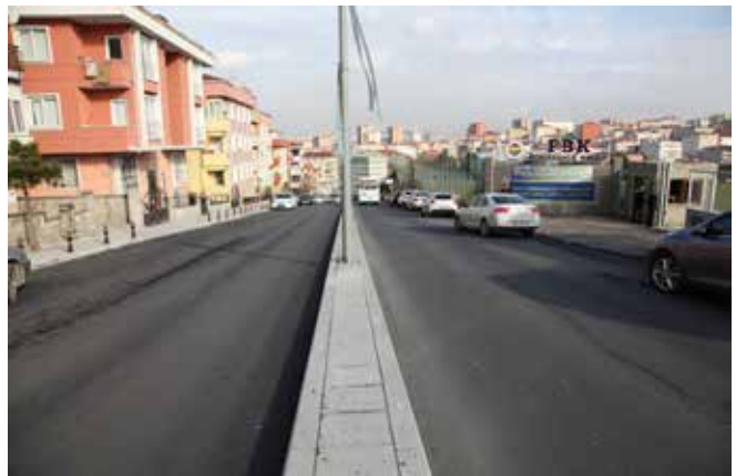
Kayışdağı Mahallesi İstanbul Caddesi Çalışma Sonrası
