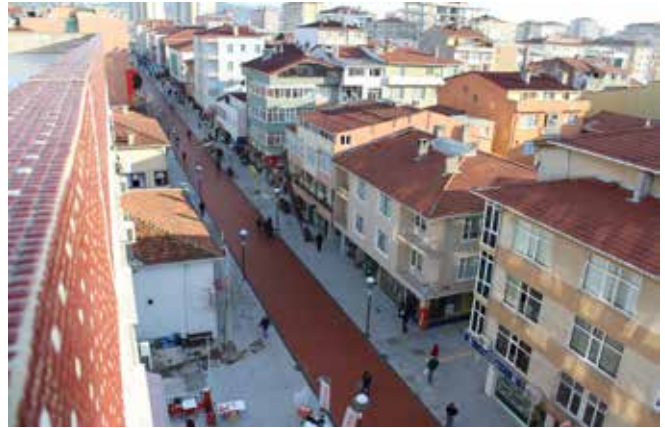
Küçükbakkalköy Mahallesi Fevzipaşa Caddesi Çalışma Sonrası
