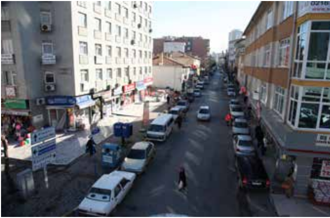
Küçükbakkalköy Mahallesi Fevzipaşa Caddesi Çalışma Öncesi
