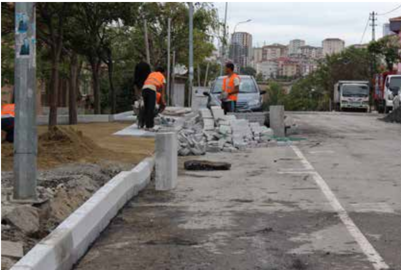
Aşık Veysel Mahallesi 3002 Caddesi Bordür-Tretuvar Çalışması
