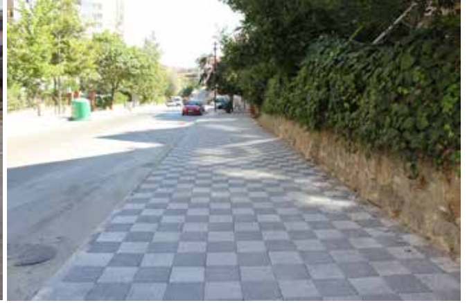
İçerenköy Mahallesi Kavaklı Sokak Bordür-Tretuvar Çalışması
