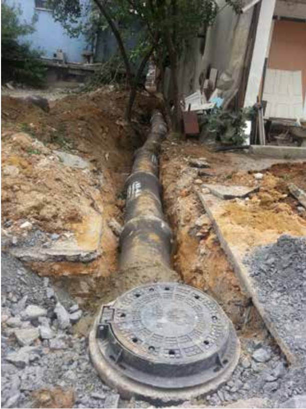
Kayışdağı Mahallesi Ceylan Sokak Yağmursuyu Kanal Çalışması
