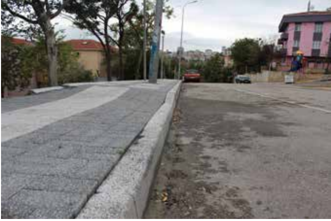
Aşık Veysel Mahallesi 3002 Caddesi Bordür-Tretuvar Çalışması
