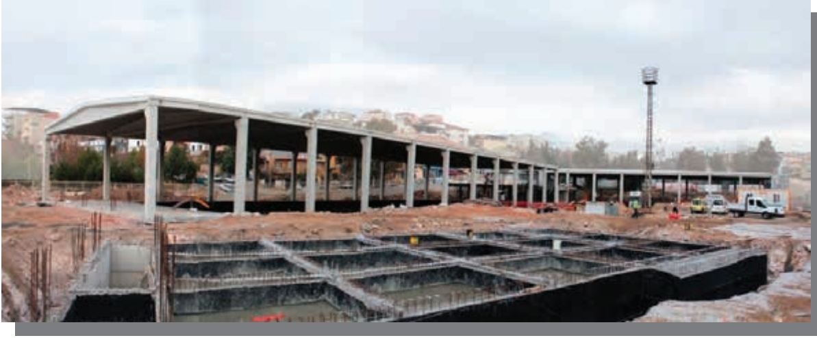
Adatepe Otobüs Garajı Bakım Onarım Atölyeleri İnşaat Aşaması
