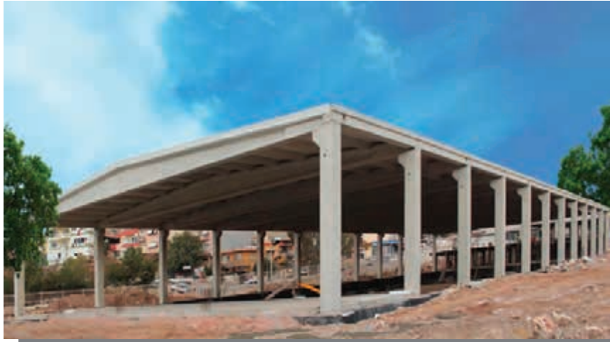
Adatepe Otobüs Garajı Bakım Onarım Atölyeleri İnşaat
