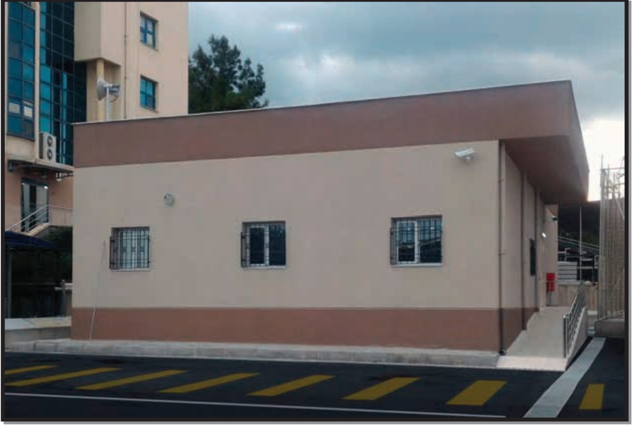
Sistem Binası Dış Görünümü
