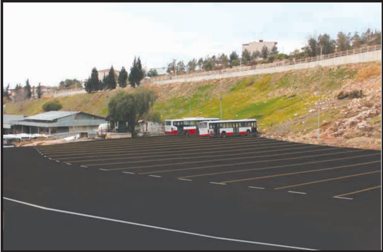
Adatepe Üst Kısım Asfalt ve Zemin Düzenleme Çalışması
