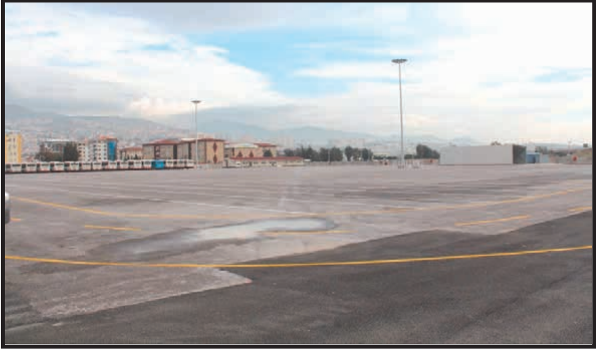
Çiğli Garajı Genel Görünümü
