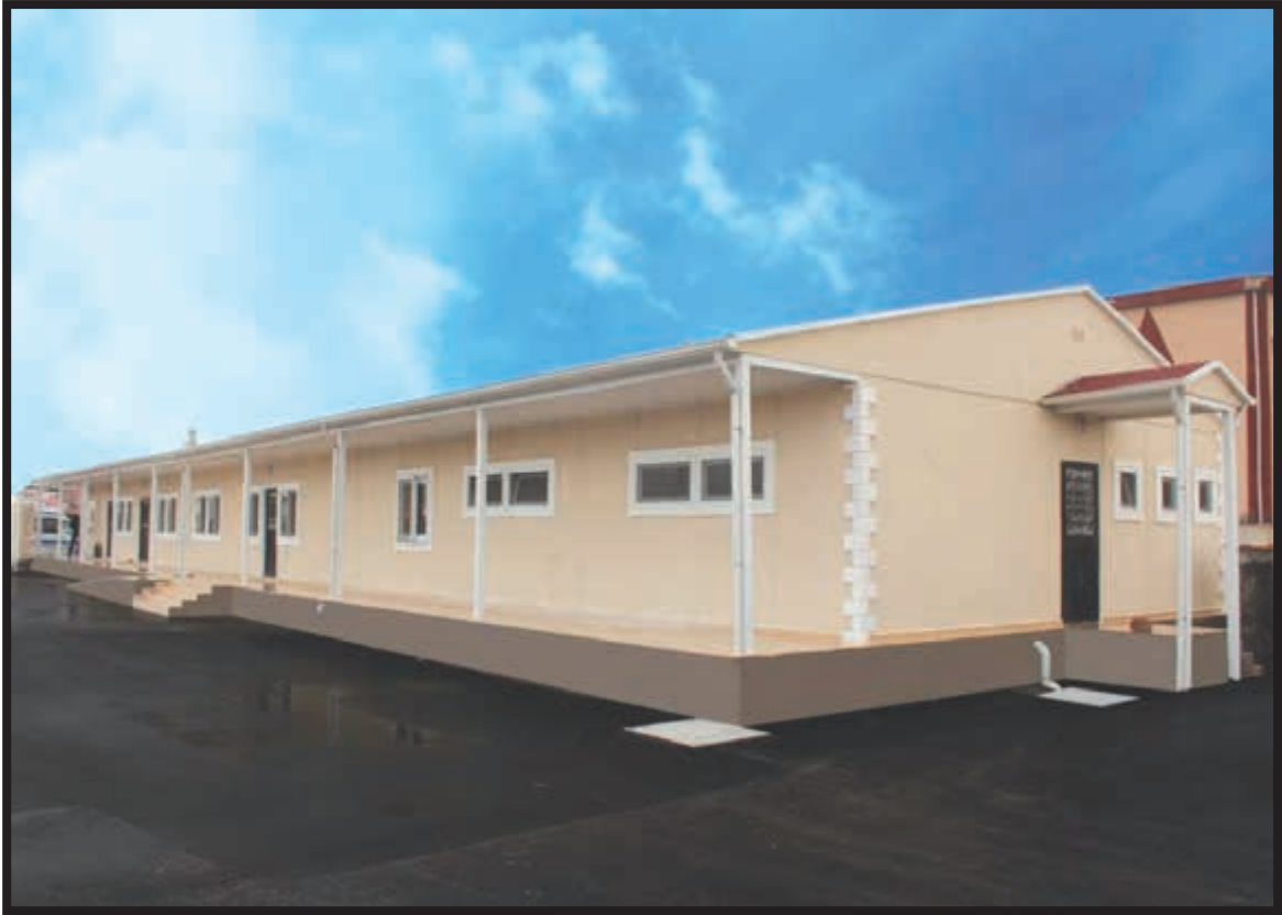
Çiğli Garajı Prefabrik Bina Görünümü
