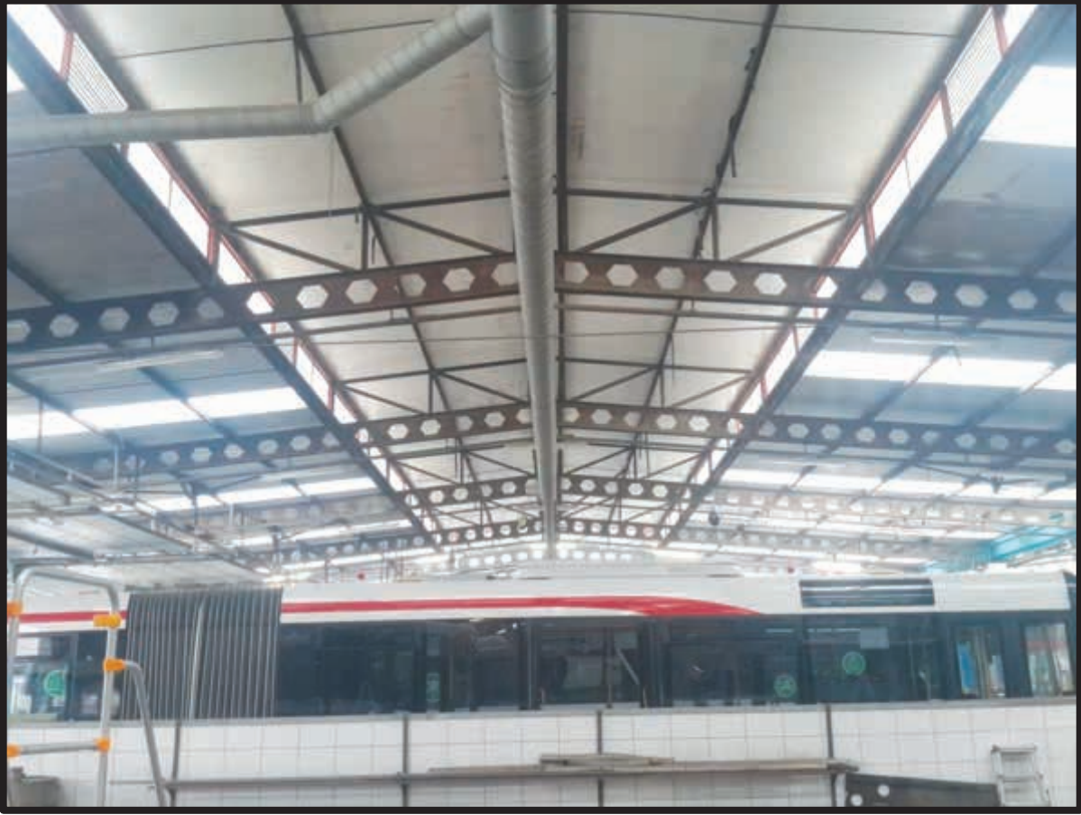
Bakım Kanalları Çatı Tadilatları İçten Görünüm
