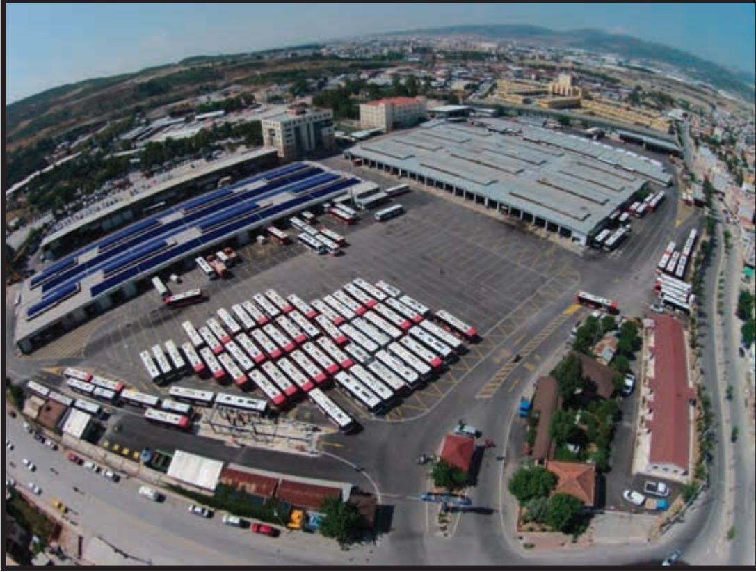
Güneş enerjisi Santrali Kurulumu İş Genel Görünümü
