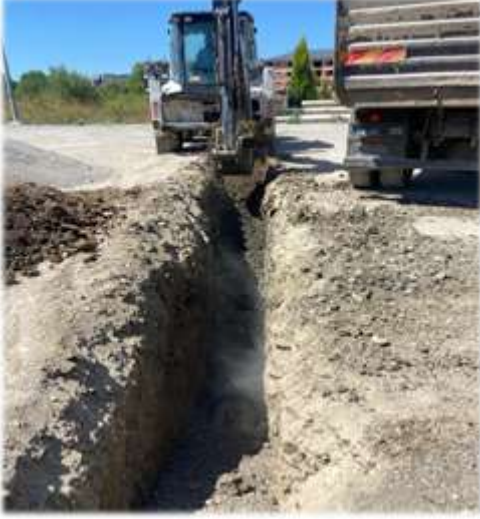
Kemerköprü mahallesi 883. sokak yağmursuyu hattı yapımı.
