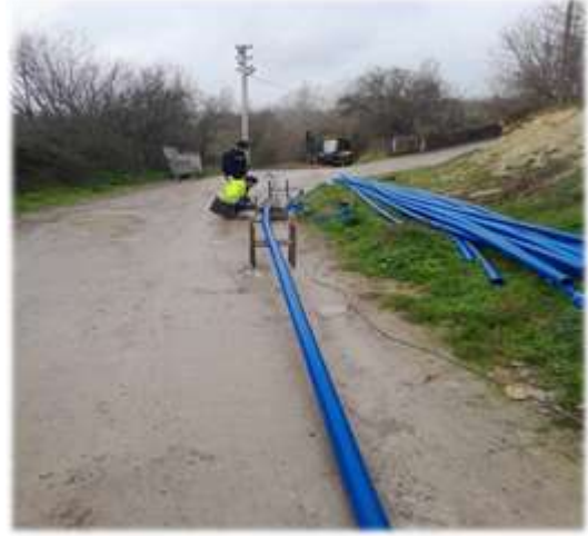
Aladağ Mahallesi 357 Sokak ana boru döşenmesi
