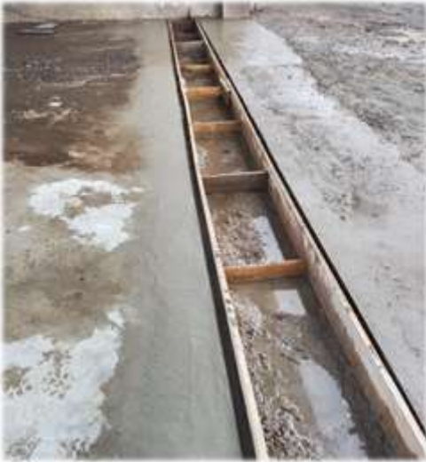
Dalıca atıksu arıtma tesisi ızgara yapımı.
