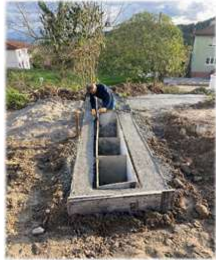
Uzunöz mahallesi yağmur suyu ızgarası yapımı
