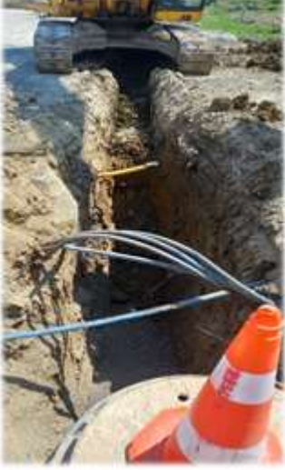
Karaköy mahallesi kanalizasyon hat yapımı.
