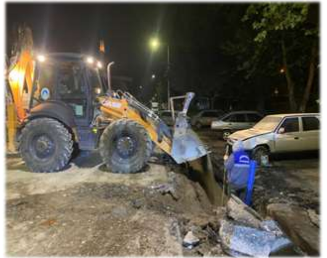
Sanayi sitesi yağmursuyu hat yapımı.
