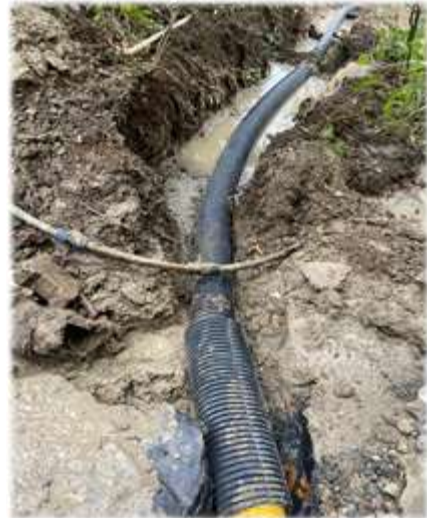
Demirciler mahallesi 486. sokak drenaj bağlantısı yapımı.
