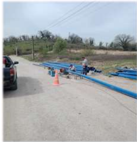
Yeni TOKİ hattı döşenmesi
