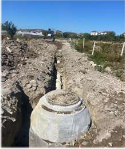
Tuna mahallesi 222.sokak kanalizasyon hat yapımı
