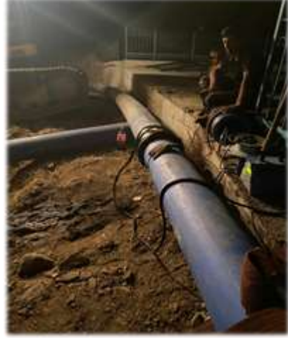
Karaçay keson hatlarının döşenmesi
