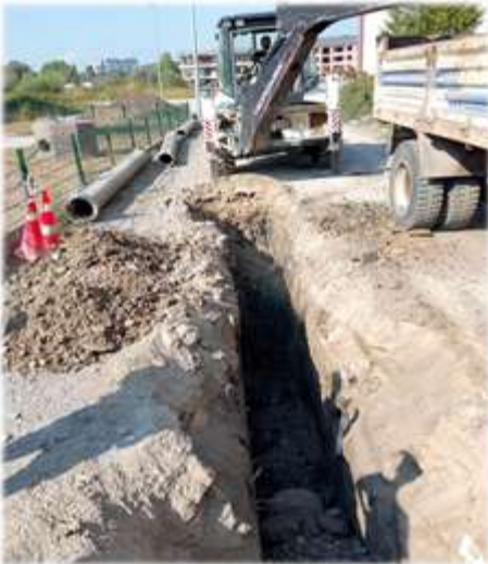
Şiremirçavuş mahallesi yağmursuyu hat yapımı.
