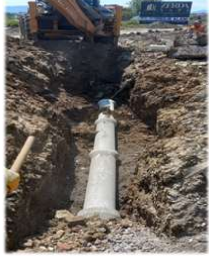
Tuna mahallesi kanalizasyon hat yapımı.
