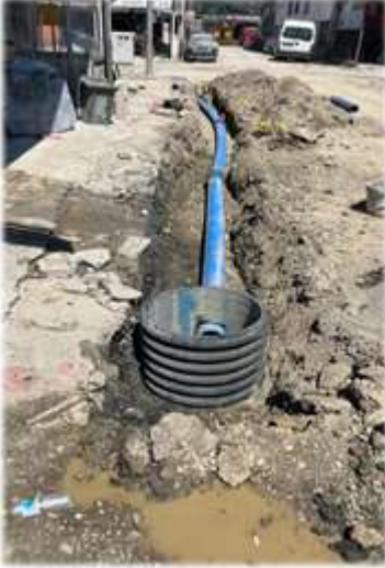
Sanayi sitesi yağmur suyu hat yapımı.
