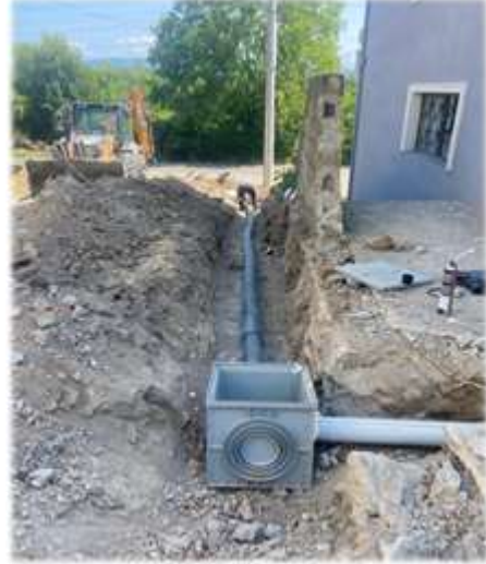
Yıldız mahallesi kanalizasyon bağlantısı yapımı.
