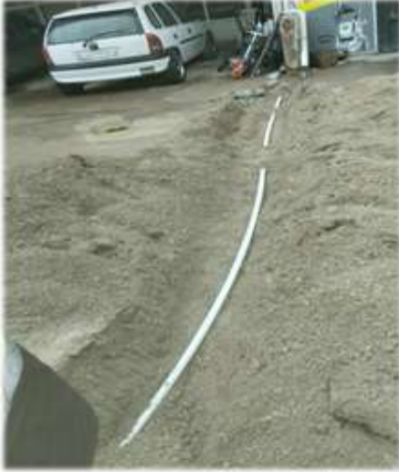
Kavallar DSİ üstü abone bağlantısı yapımı.
