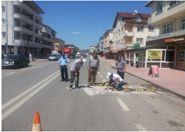
Plastik Hız Kesici Montaj Çalışmalarımız
