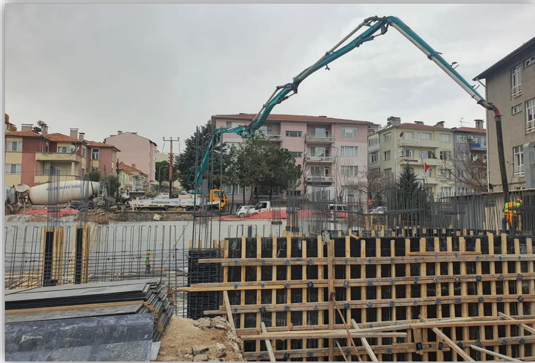
(Diş Hekimliği Fakültesi ve Diş Hastanesi Binası)
