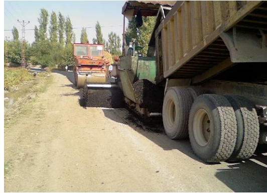
Stabilize Yapım Çalışmaları
