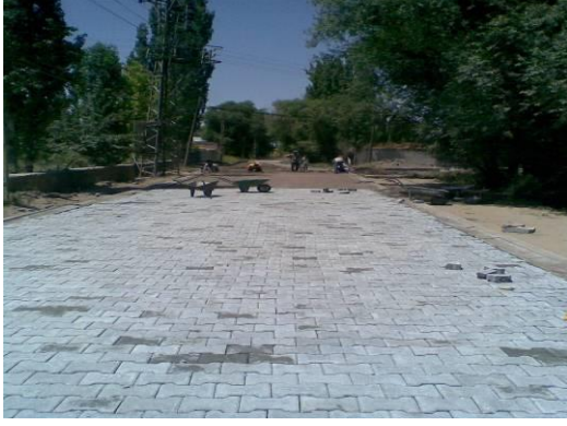
Köy İçi Parke Yapım Çalışmaları
