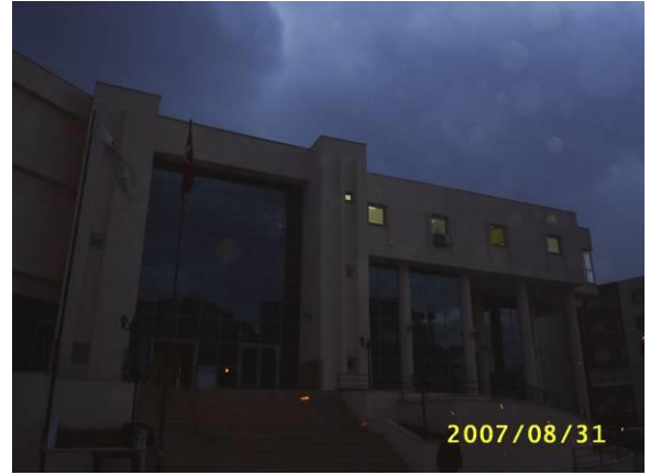
Kültür Sarayı İnşaatı Resim 2
