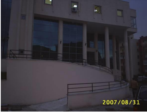
Kültür Sarayı İnşaatı Resim 1
