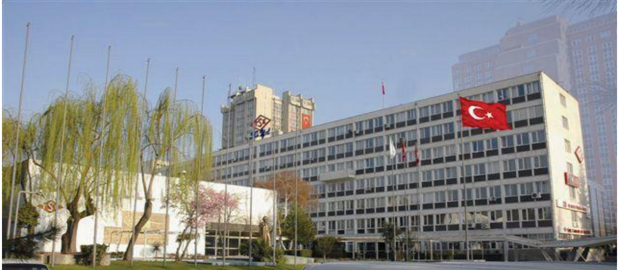
Şekil 1: TSE Merkez Binası
