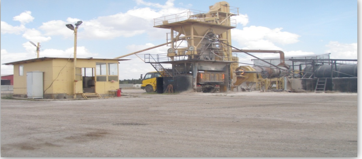
HAVSA ASFALT ŞANTİYESİ
