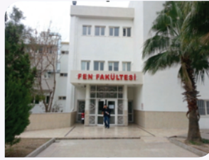
Fen Fakültesi Dış Cephe Onarımı
