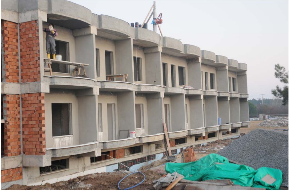
Resim 9- Tesisin inşaatından bir görüntü.
