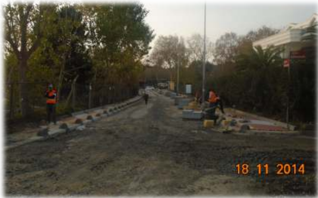
Asfalt s k m  ve kaplaması G rsel
