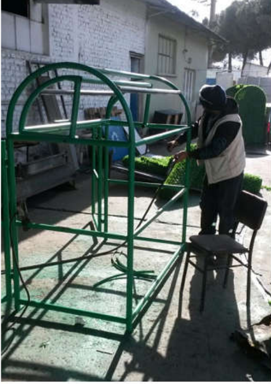
Şekil 25: Yeşil Çöp Konteynırı Giydirme Çalışması
