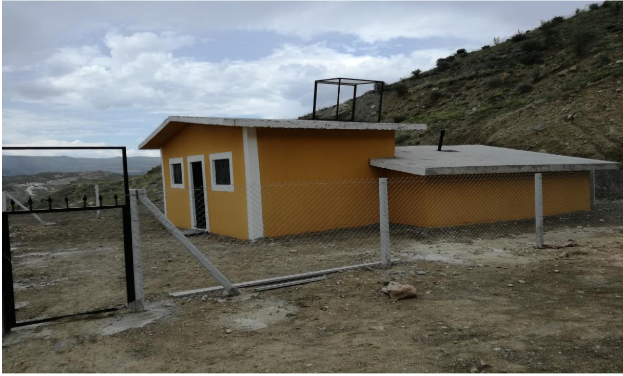
İÇME SUYU DEPOSU
