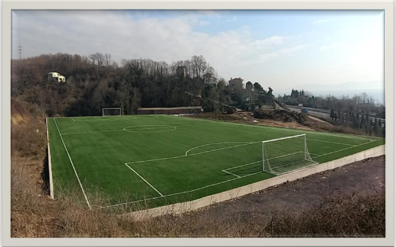
SPOR TESİSİ YAPIM ÇALIŞMALARIMIZ
