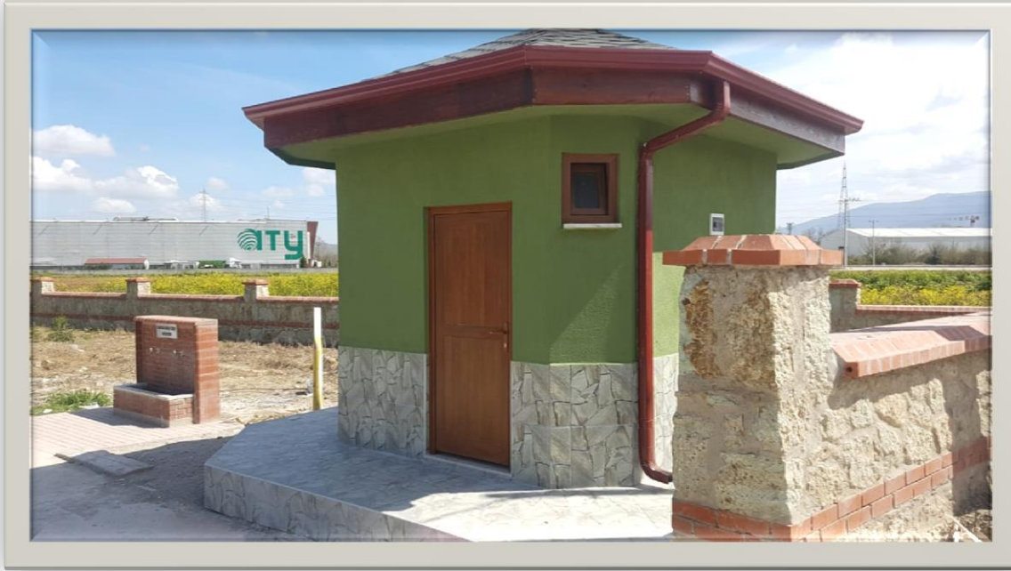
UZUNBEY MAHALLESİ ŞADIRVAN YAPIMI
