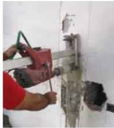
Karot Alınarak Beton Dayanımı Tespiti
