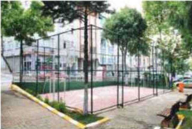
Ş. Sedat Yenigün Parkı Basketbol Sahası Yapım Çalışmalarımız
