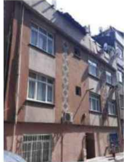
7509 Sayılı Parseldeki Riskli Bina
