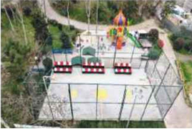
Recep Tayyip Erdoğan Parkı Basketbol Sahası Yapım Çalışmalarımız
