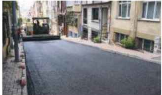
Diğer Cadde ve Sokaklarda Yapılan Asfalt Kaplama Çalışmaları
