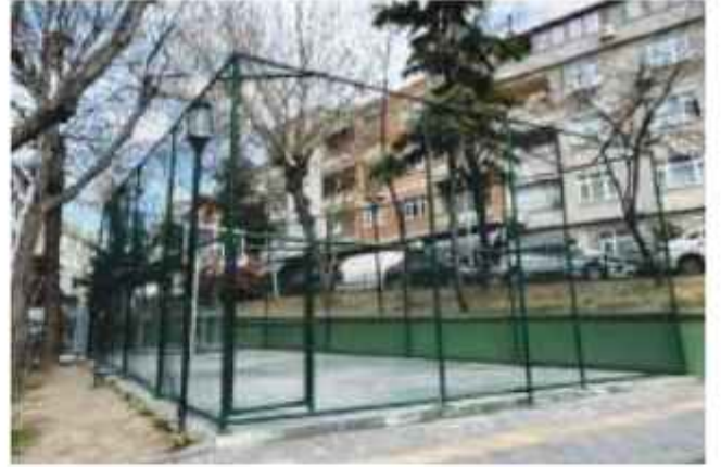
58. Sk. Parkı Basketbol Sahası Yapım Çalışmalarımız
