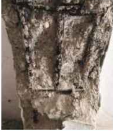
Sıyırma Yöntemi ile Donatı Tespiti
