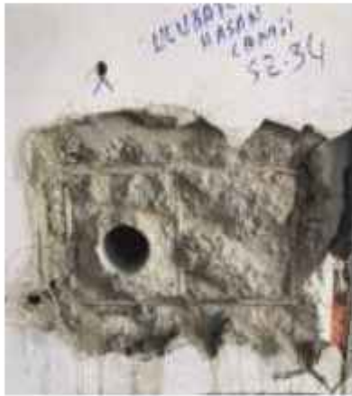
Karot Alınarak Beton Dayanımı Tespiti
