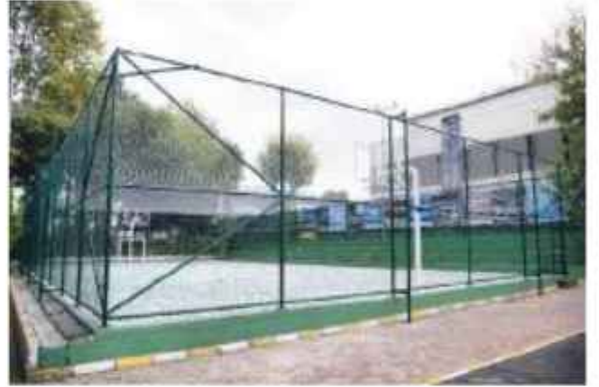
Sabri Akpınar Parkı Basketbol Sahası Yapım Çalışmalarımız
