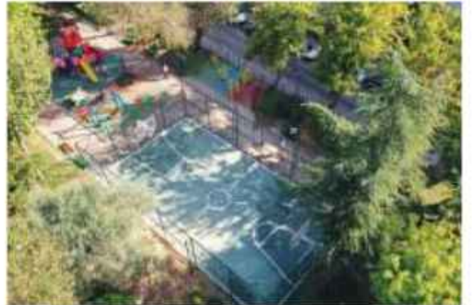
Ertuğrul Gazi Parkı Basketbol Sahası Yapım Çalışmalarımız
