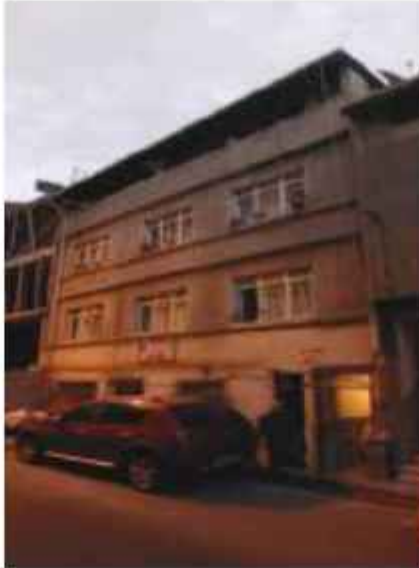
17442 Sayılı Parseldeki Riskli Bina
