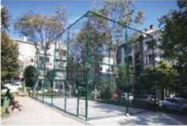
Sevgi Parkı Basketbol Sahası Yapım Çalışmalarımız
