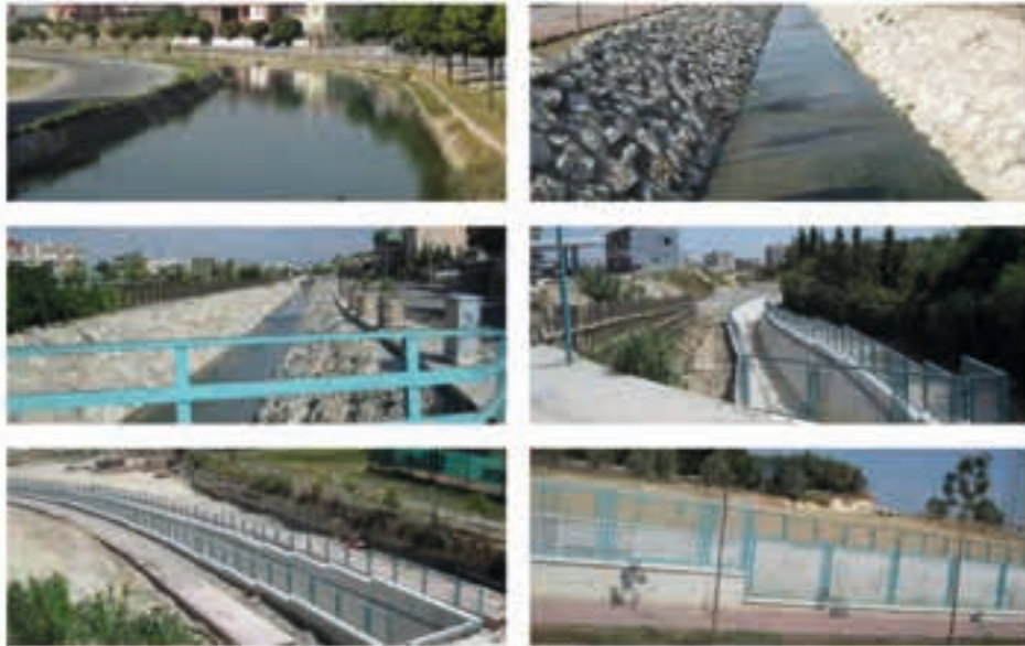
Resim 8. Kanallara demir korkuluk, ihata duvarı yapımı ve parke döşenmesi
