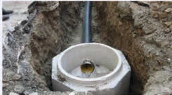
Resim 2. Kanalizasyon Borusunun Döşenmesi
