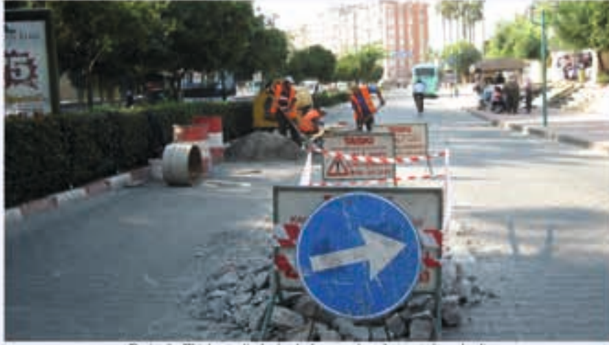
Resim 3. Ekipler varilırl olarak alt yapı çalışmalarını sürdürmektedir
