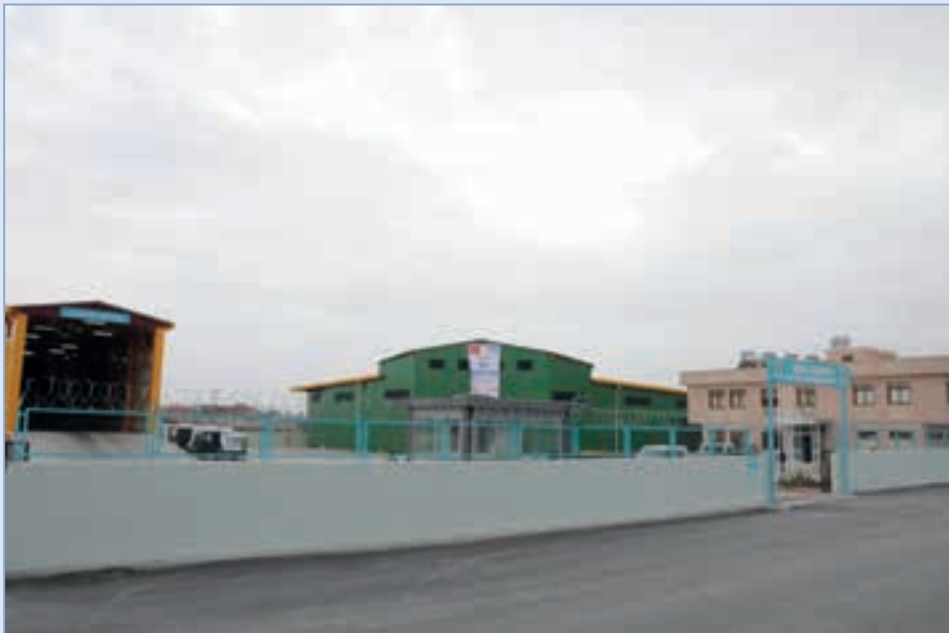
Şekil 1: Katı atık aktarma istasyonu
