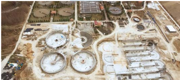
Yeni Atıksu Arıtma Tesisi Çalışmaları
