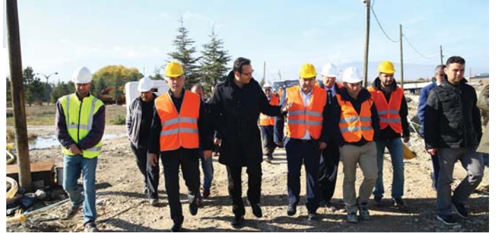
SU ARITMA TESİSİ İNCELEMESİ
