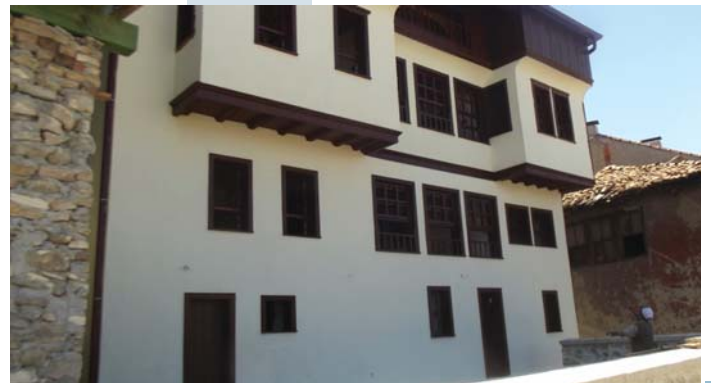
220 Envanter Nolu Konak Restorasyon Uygulaması İşi
