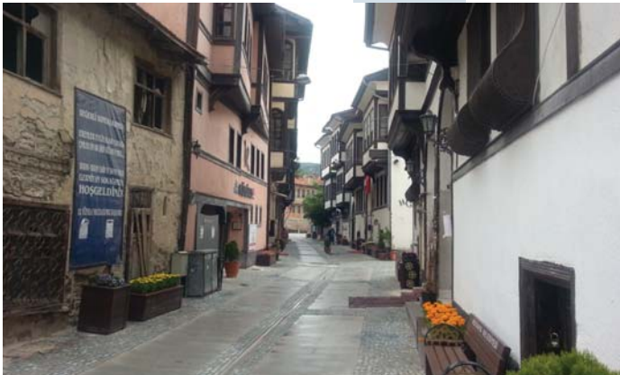
Germiyan Sokak Aydınlatma Altyapı ve Yol Düzenleme Uygulaması İşi
