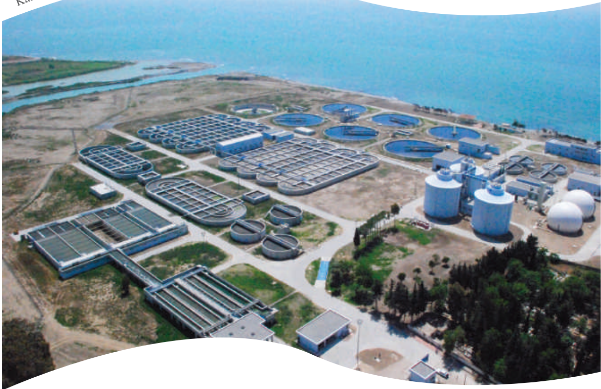
Karaduvar Atıksu Arıtma Tesis
