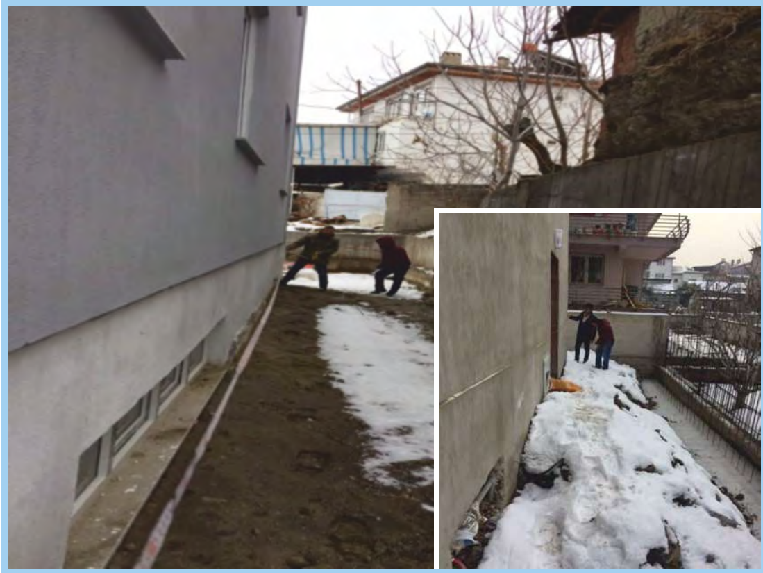
Sırapapılar ve Karaman Mahallelerimizde bina cephelerinin kontrolü işlemi
