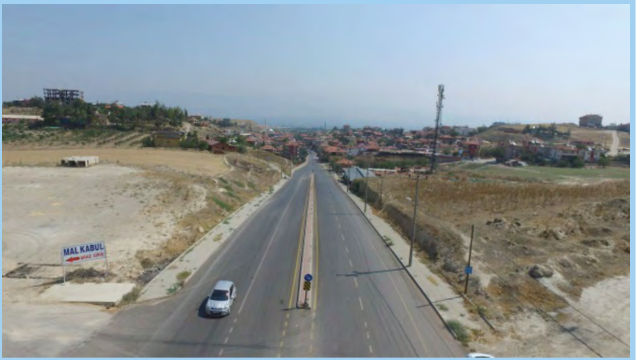
Eskihisar Mahallesi asfalt çalışması
