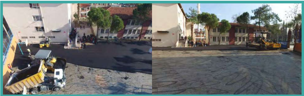
Namık Kemal Ortaokulu bahçesine yaptığımız asfalt çalışması
