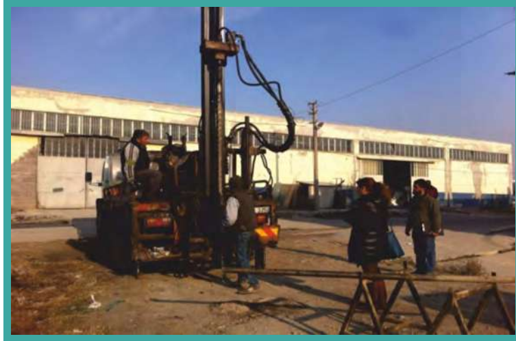
Gümüşçay Mahallesi sondaj çalışması
