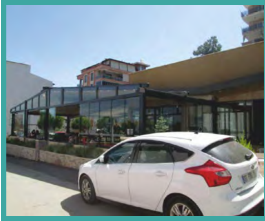
İşyerinde Kaçak İlave Yapı
