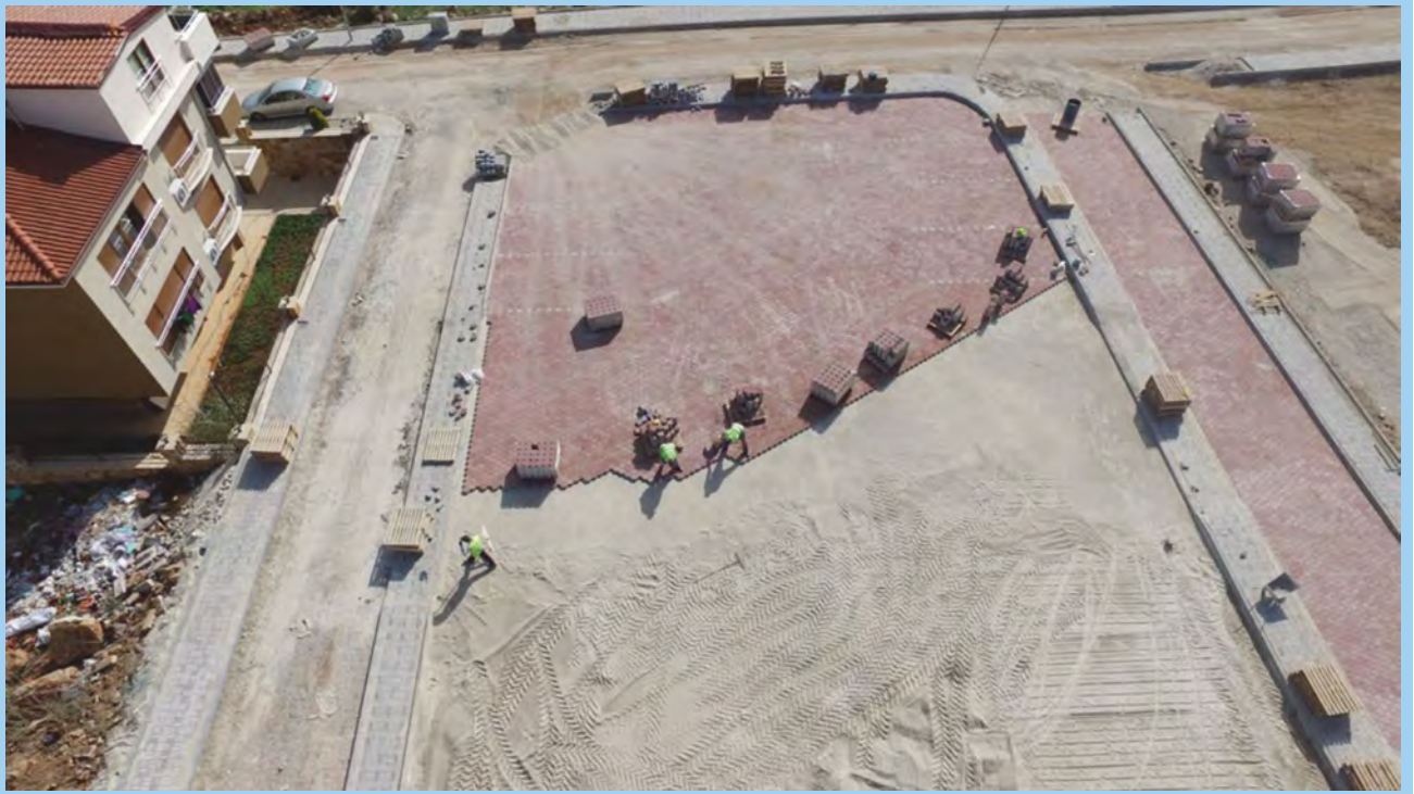
Gerzele Mahallesi kilit taş parke çalışması.
