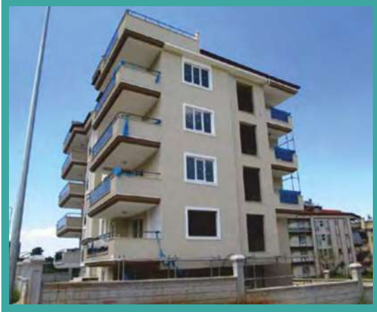
Kaçak Balkon Kapatmaları
