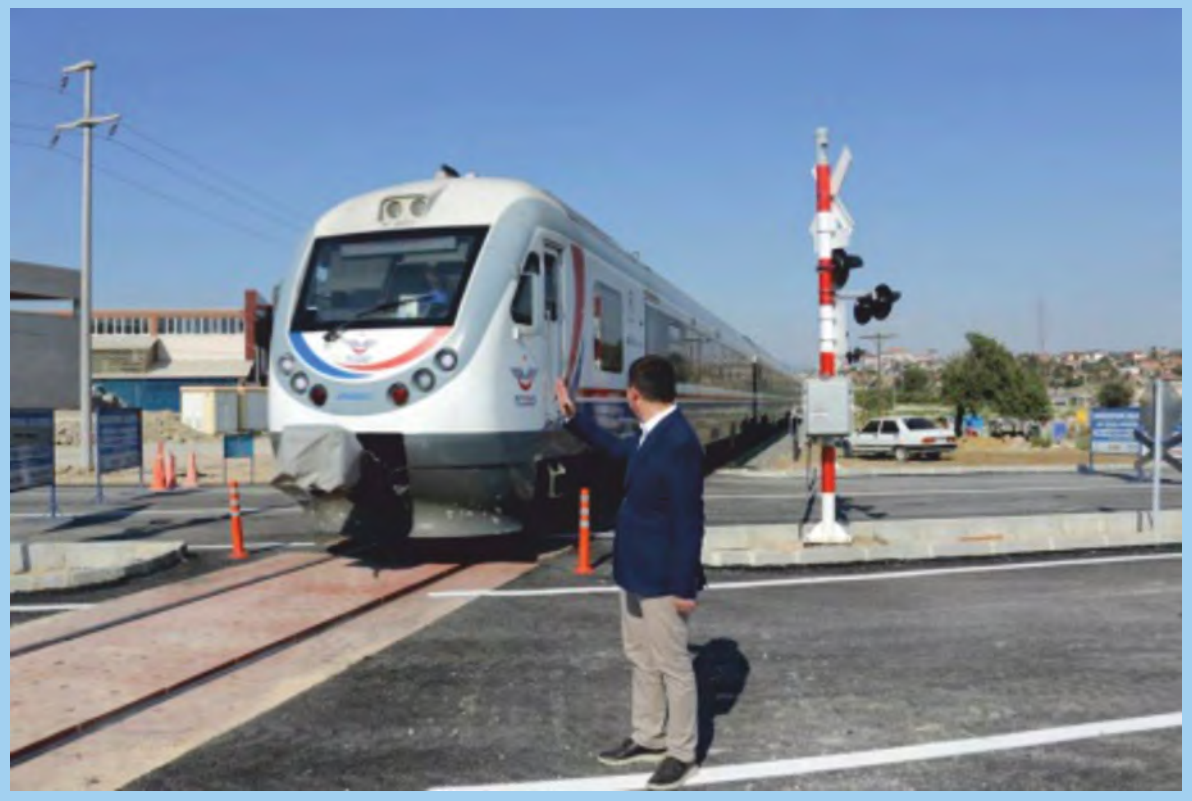
Sümer Tren Yolu Hemzemin Geçidi tamamlandı.
