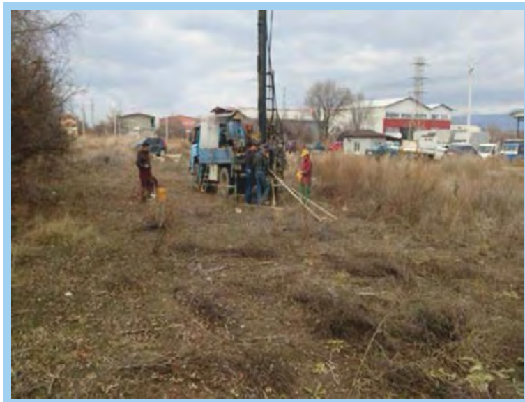
Akçeşme Mahallesi sondaj çalışması
