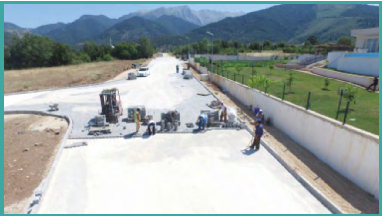
Başkarcı vali konağı çevresi kilit taş yol ve kaldırım yapım çalışmalarımız
