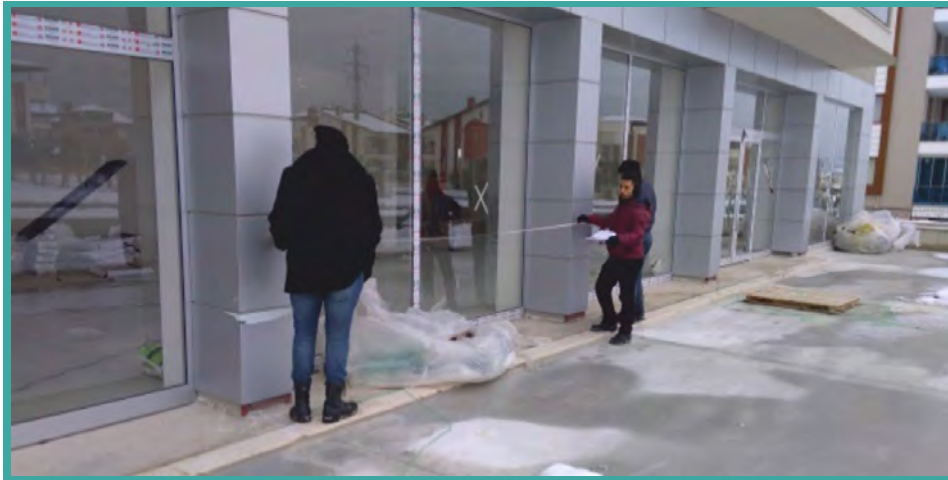
Gümüşşay ve Çakmak Mahallelerimizde bina cephelerinin kontrolü işlemi
