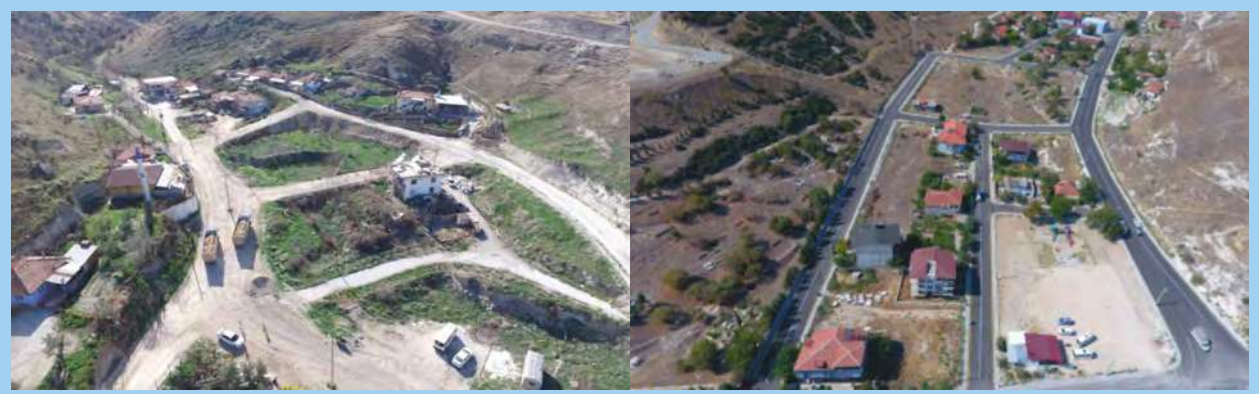
Kayalar Mahallesi Öncesi
