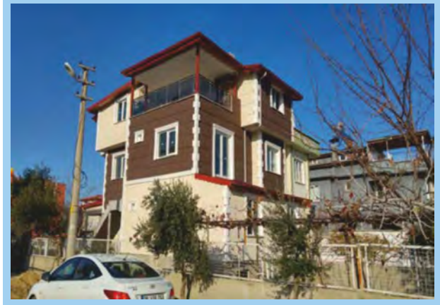
Kaçak Çatı Katı ve İlave Yapılar
