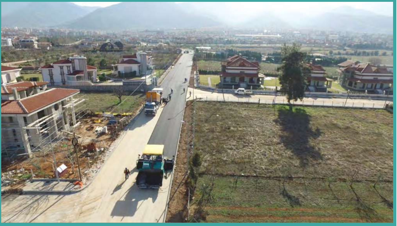
Merkezefendi Mahallesi asfalt çalışması
