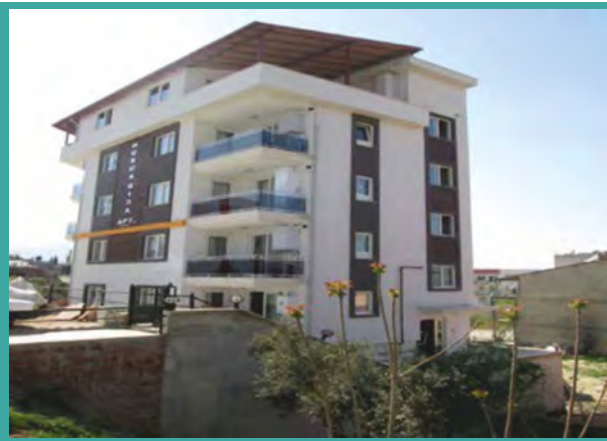
Kaçak Çatı Katı
