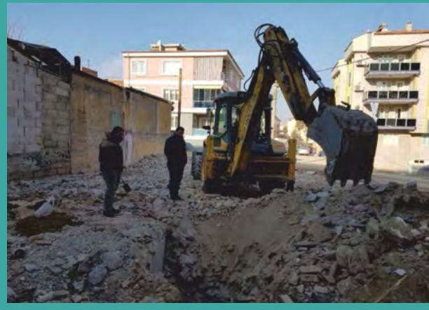
Akkonak Mahallesi Araştırma Çukuru
