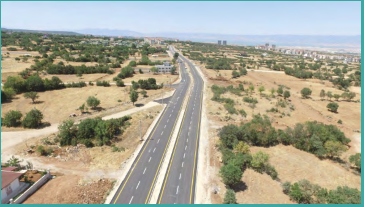
Başkarcı Mahallesi asfalt çalışması
