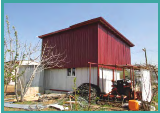
Ruhsatsız Kaçak Yapı
