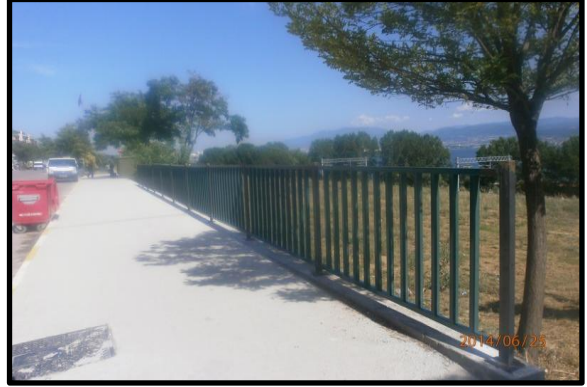
Yol Kenarına Korkuluk Yapılması
