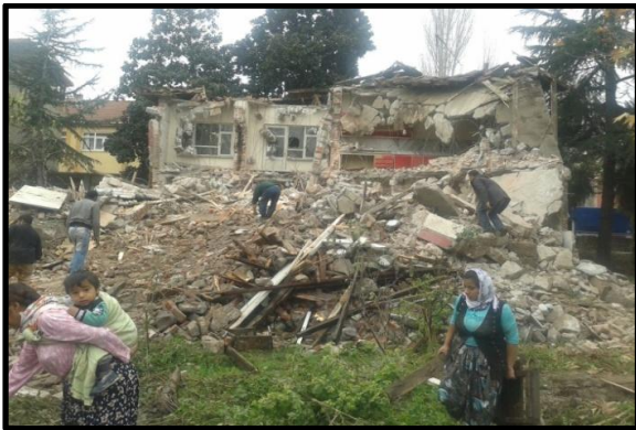
Metruk Bina Yıkımı
