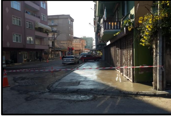
Beton Kaldırım Çalışması
