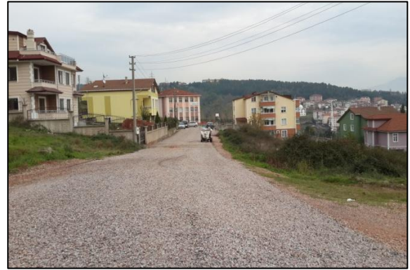
Soğuk Asfalt Yapımı
