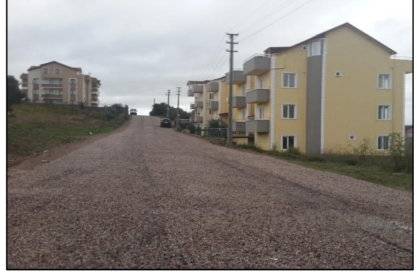
Soğuk Asfalt Yapımı
