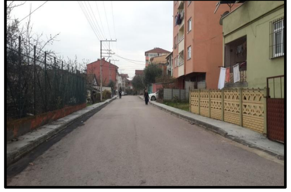
Beton Kaldırım Çalışması
