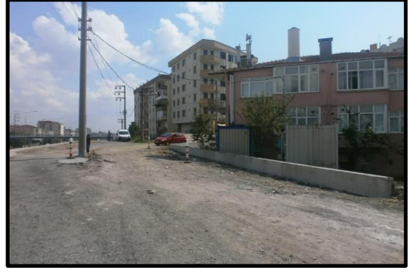
Betonarme Taşıyıcı Duvar Yapılması
