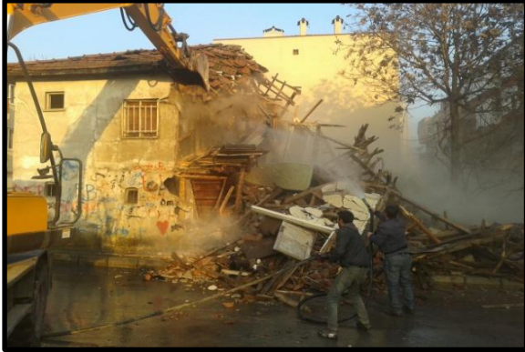
Metruk Bina Yıkımı
