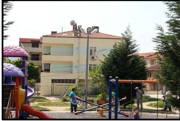
Park Aydınlatması Yapılması
