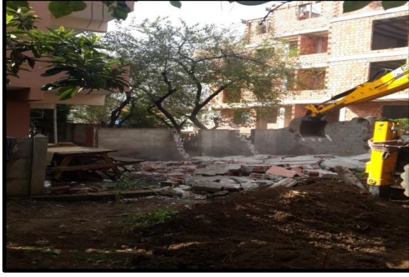
Yolda Kalan Binanın Yıkımı
