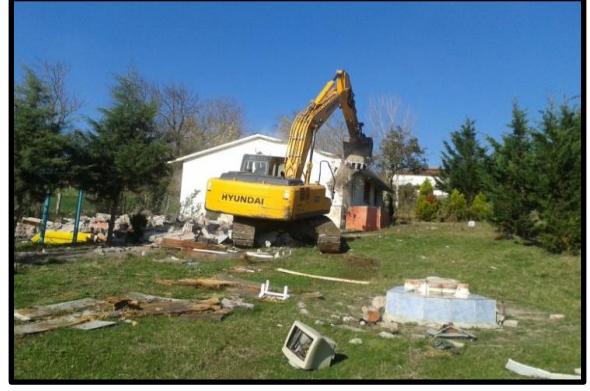
Eski Köy Okulunun Yıkımı
