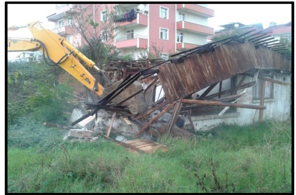
Metruk Bina Yıkımı
