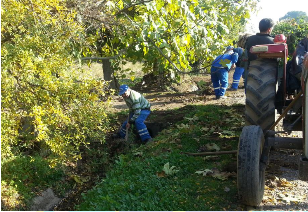
Şekil 11 : Yeniköy Kanal Temizliği
