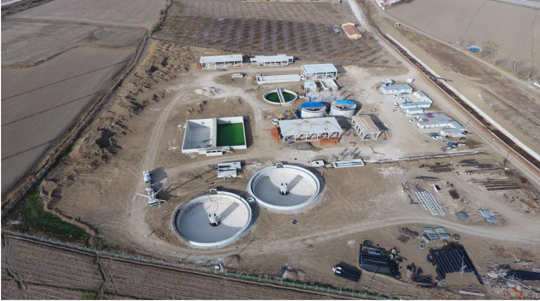
( T.C. Merzifon Belediyesi Atıksu Arıtma Tesisi İnşaat Sahası)
