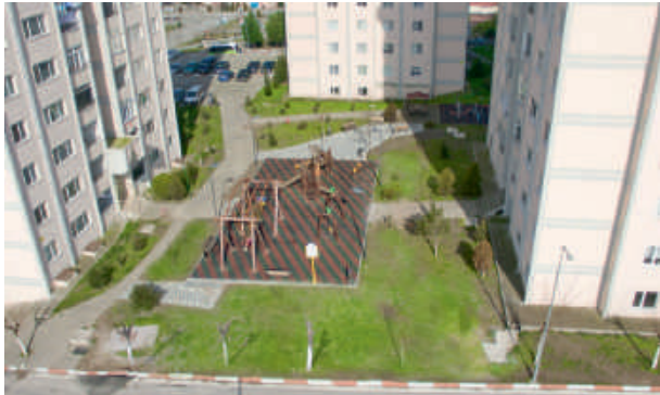
YENİ MAHALLESİ TOKİ 2.ETAP
