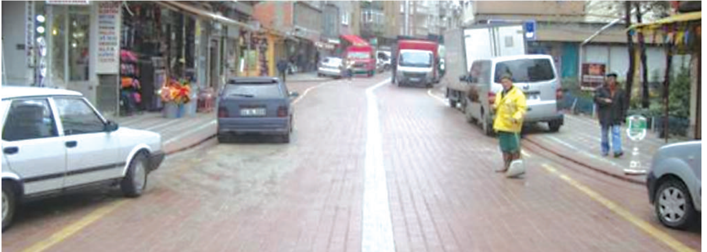
Telsiz Mahallesi 84. Sokak prestij yol kaplaması.
