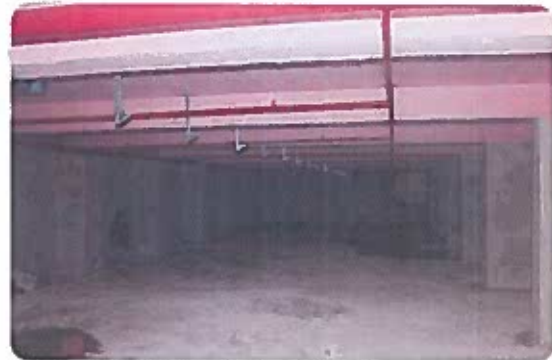
Yer altı Otoparkı İnşaatı
