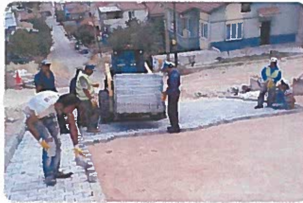
Gazi Osman Paşa Mahallesi Yol Çalışmaları
