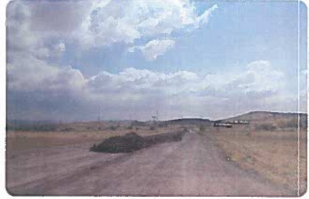
Savaştepe Yolu Çevre Yolu Bağlantısı ve Yeni Yol Asfalt Çalışmaları
