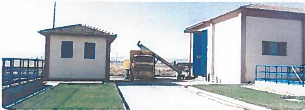
Atıksu Arıtma Tesis Belt Pres Çamur Çıkışı
