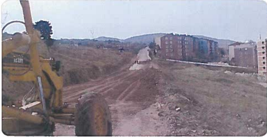
Dinkçiler Mahallesi Yol Açma Çalışmaları
