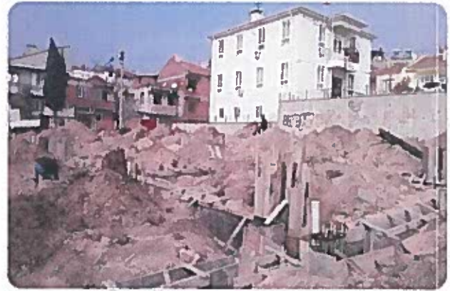
Osman Paşa Mahallesi Kapalı Pazar Yeri Temel Çalışmaları
