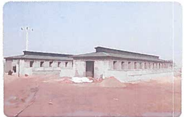
Tehlikeli Hayvanlar İçin Barınma Yeri İnşaatı
