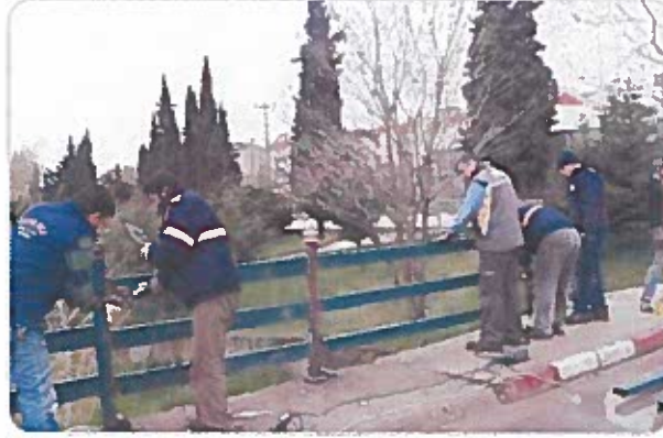
Milliye Mahallesinde Dere Islahı ve Köprü Yapımı Çalışmaları
