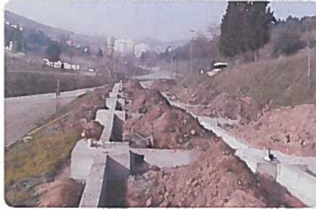
Dinkçiler Mahallesi Kapalı Pazar Yeri İnşaatı Temel Çalışmaları
