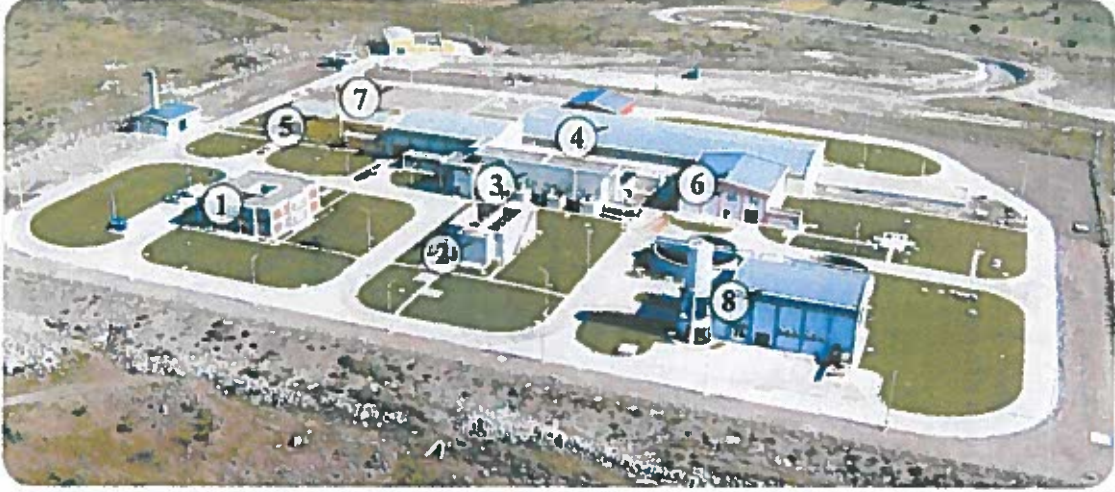
İçme Suyu Arıtma Tesisi
