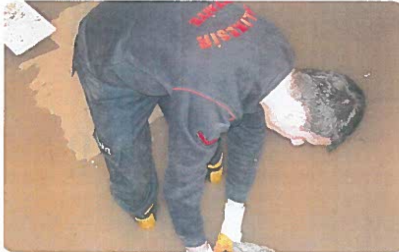
Su Baskınlarında Su Tahliyesi Çalışması
