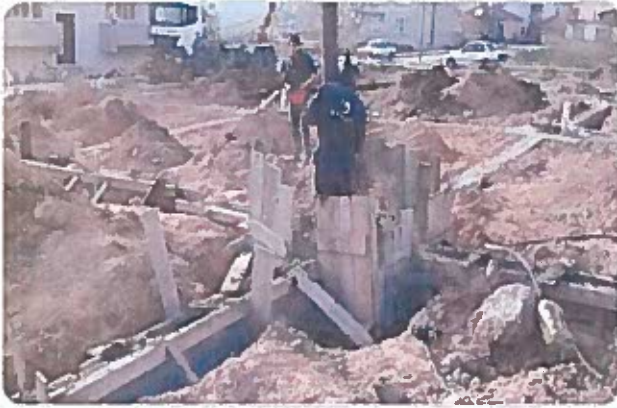
Gazi Osman Paşa Mahallesi Kapalı Pazar Yeri Temel Çalışmaları
