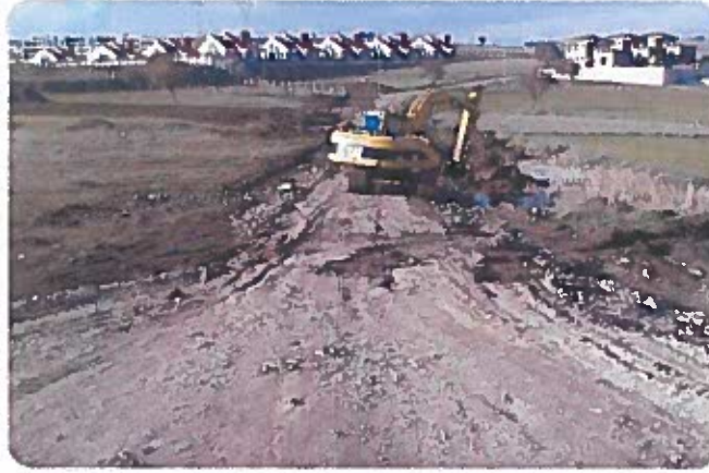
Yeni Sanayi Bölgesinde Yol Açma Çalışmaları
