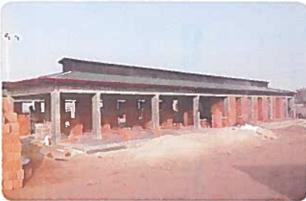
Tehlikeli Hayvanlar İçin Barınma Yeri İnşaatı
