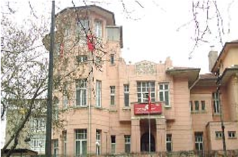
Demirtepe Ek Hizmet Binası
