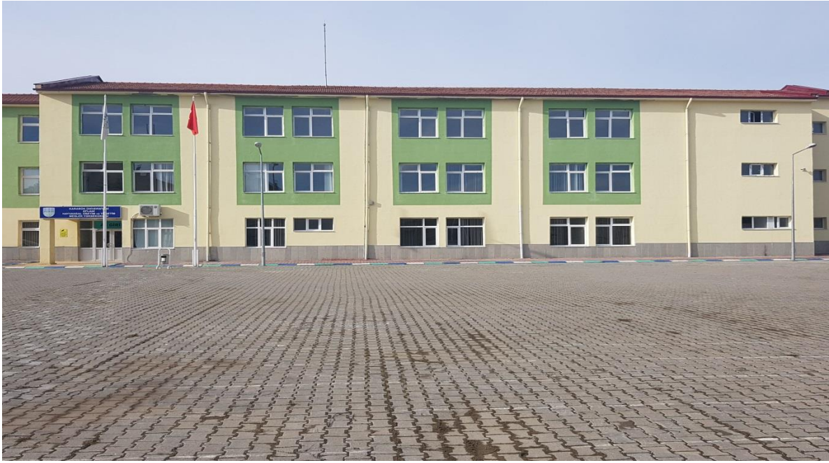
Resim 11. Eflani Meslek Yüksekokulu Binası
