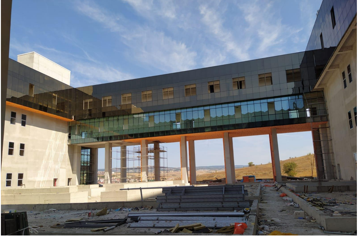
Resim 33. Mühendislik Fakültesi Laboratuvar İnşaatı
