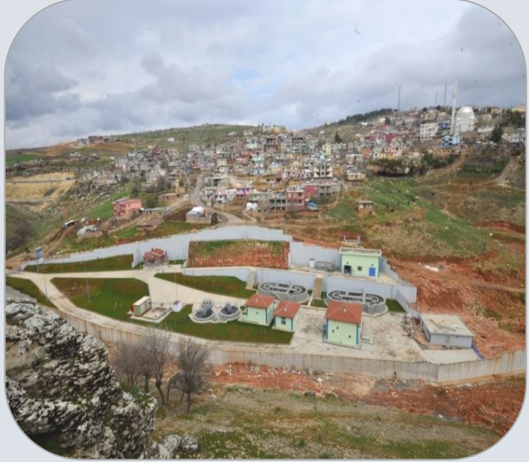
Eğil Biyolojik Atıksu Arıtma Tesisi
