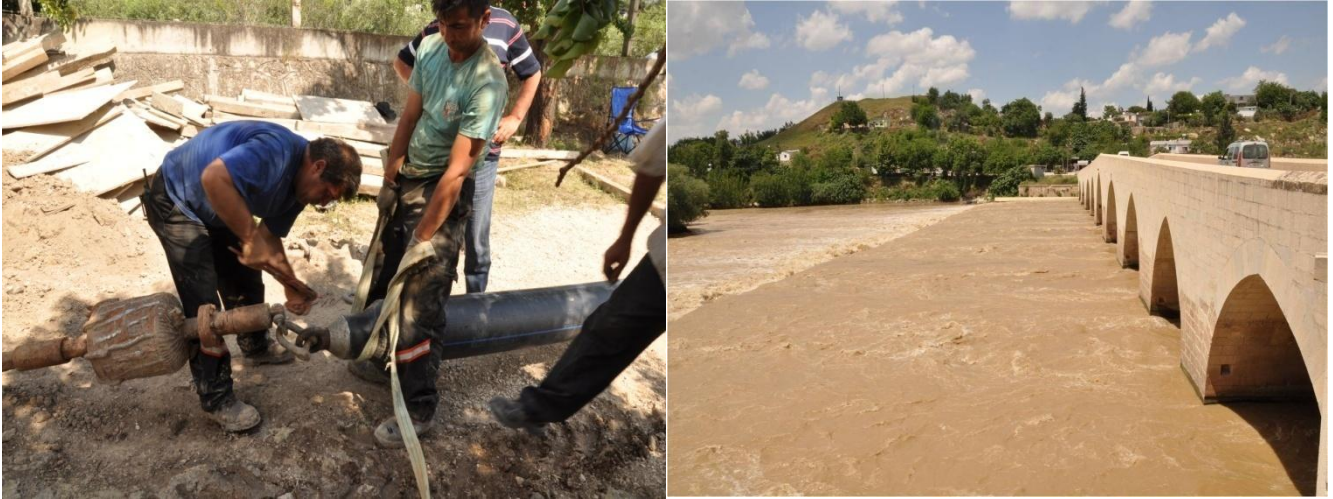
İçmesuyu Şebekesi 250 HDPE 324 mt Ceyhan Nehri Yönlendirilebilir Yatay Delgi Çalışması
