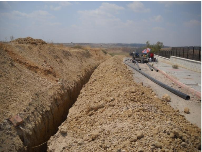
Mıdık Mahallesi ve Büyük Dikili Kuyumcular ve Karakuyu Mah İçmesuyu Şebekesi Yapımı
