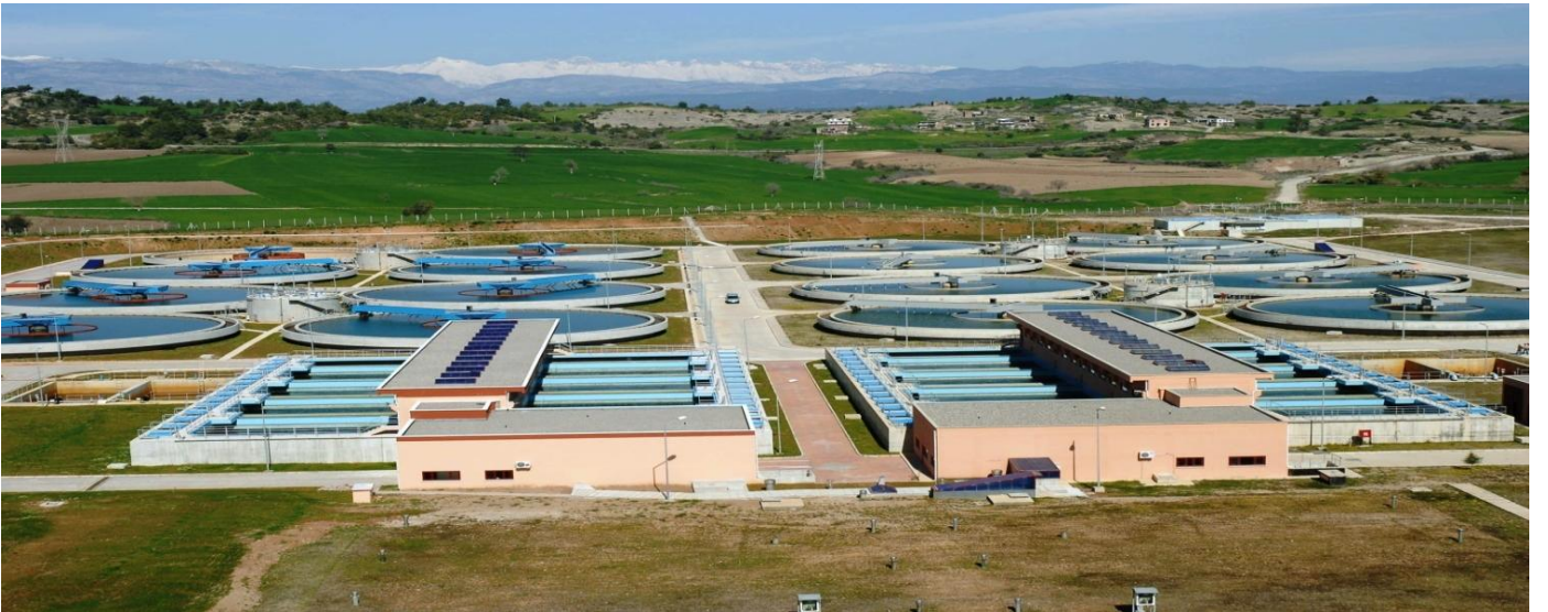
Çatalan İçmesu Arıtma Tesisleri
