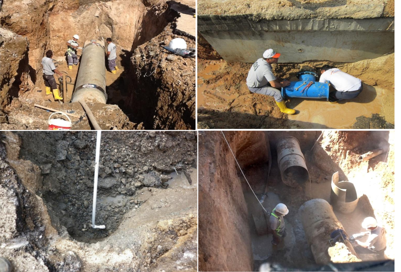
İçmesuyu Şebekesi Bakım Onarım Çalışmaları
