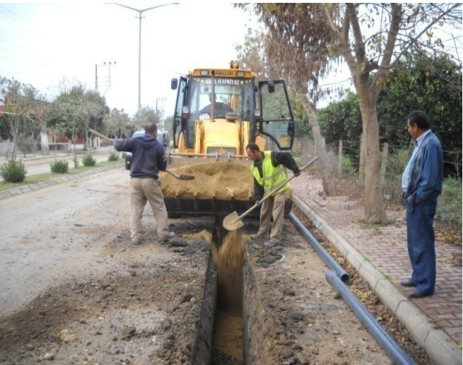
Mıdık Mahallesi ve Büyük Dikili Kuyumcular ve Karakuyu Mah İçmesuyu Şebekesi Yapımı
