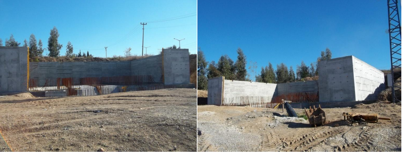
İçmesuyu Deposu Yapım Çalışmaları
