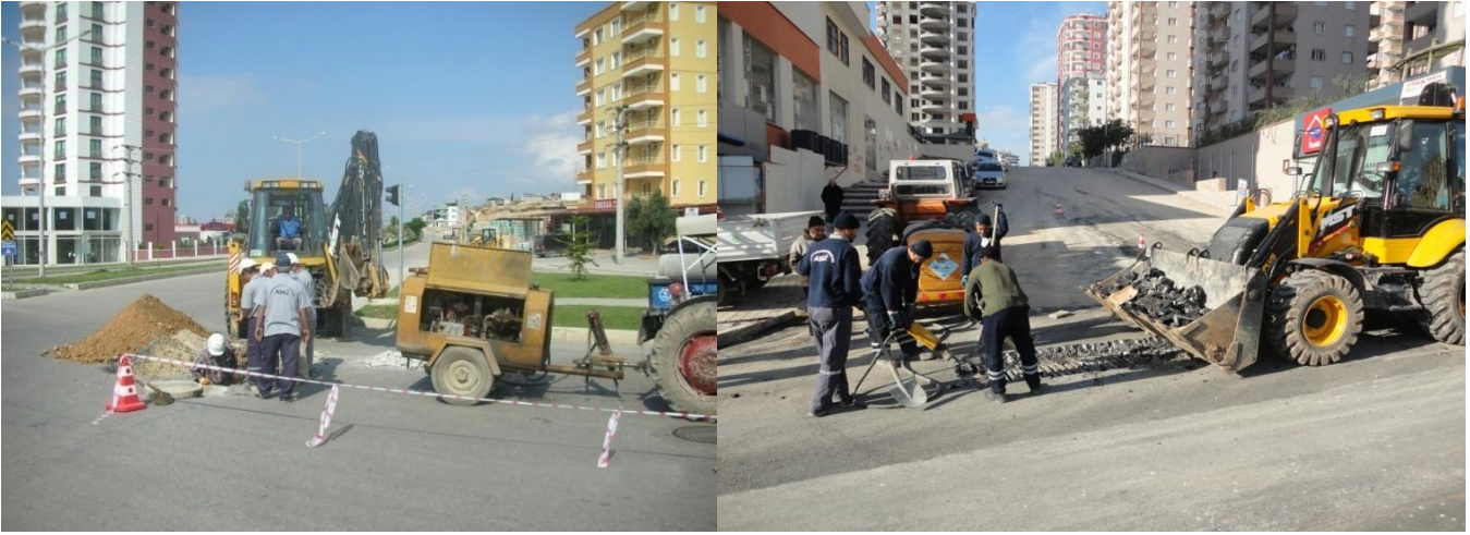
Kanalizasyon şebekesi bakım ve onarım çalışmaları
