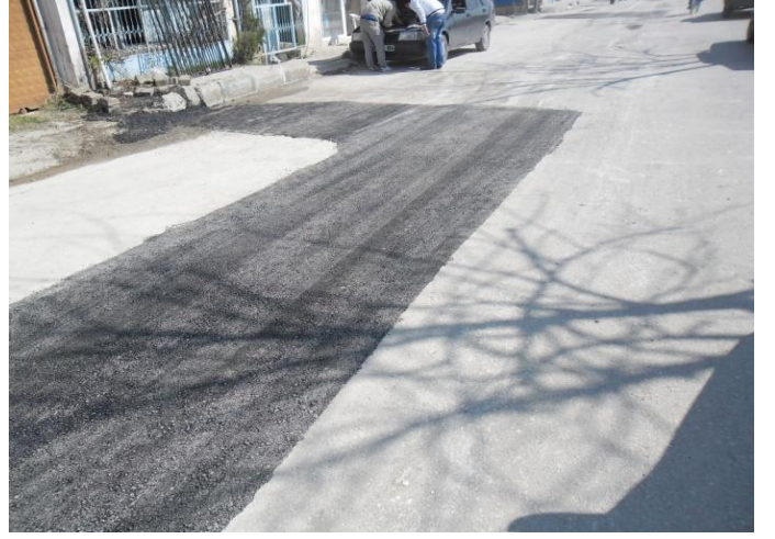
İçmesuyu Şebekesi Sonrası Asfalt Kaplama Çalışmaları
