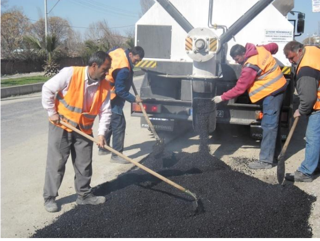
İçmesuyu Şebekesi Sonrası Asfalt Kaplama Çalışmaları
