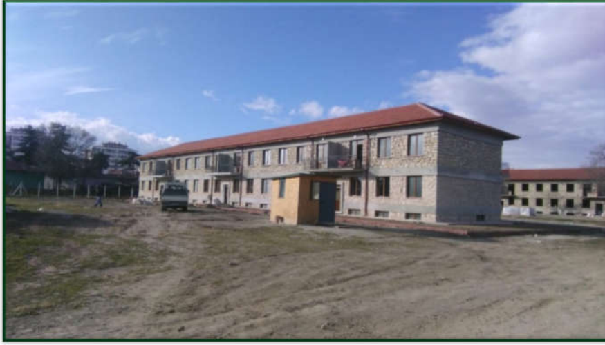
İlçemiz, Gülbahçe Mahallesi'nde restorasyonuna başlanan Taş Evler' in düzenlenmesi ve yapım işlemleri devam etmektedir.
