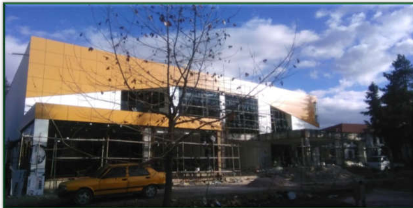
İlçemiz, Sümer Mahallesi'nde yapımına başlanan Kütüphane Projesi'nin inşaatı devam etmektedir.
