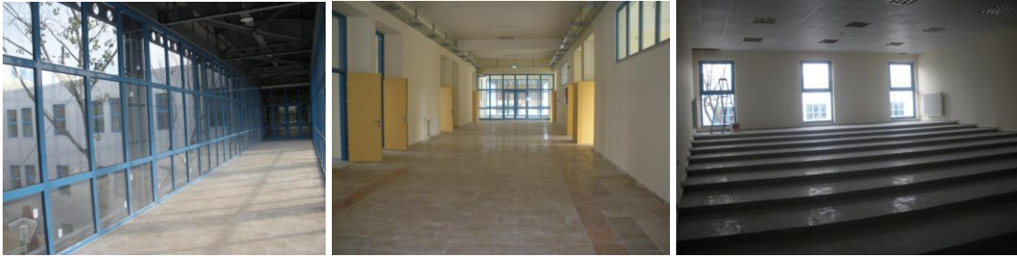
İnşaat Fak. D-D1 Blokları, iç yapı görüntüleri
