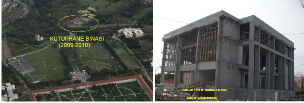
Kütüphane Binası Yapım İşi.
