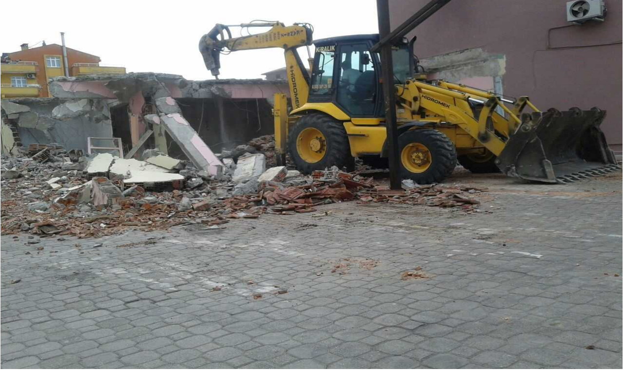
100. Yıl İlköğretim Okul bahçesinde eski bina yıkılarak parke çalışması yapıldı.
