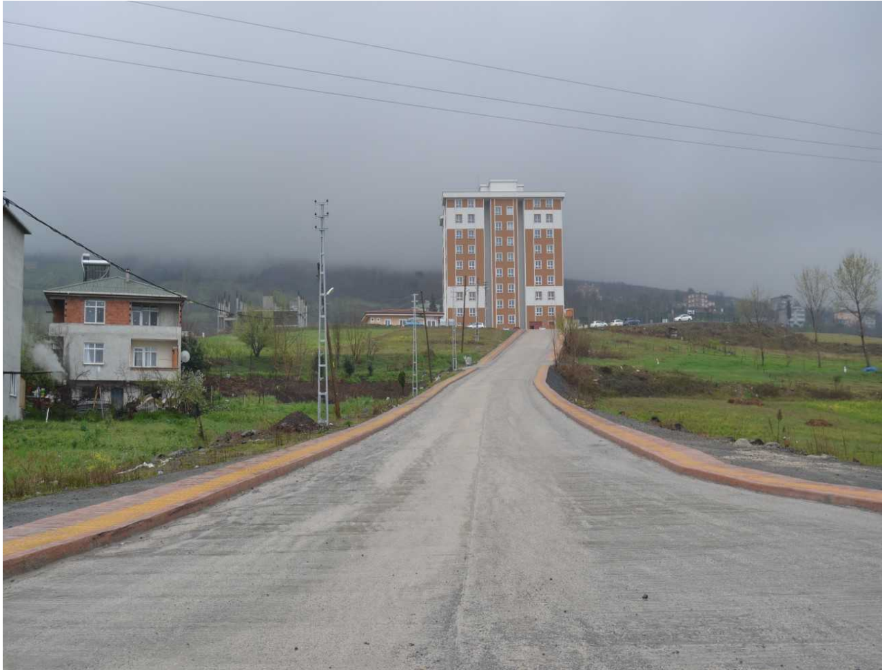
Atatürk Mahallesi 444. Sokakta beton yol çalışması yapıldı. Bölgemizde 2016 yılı içerisinde 6100 m 2 beton yol çalışması yapıldı.
