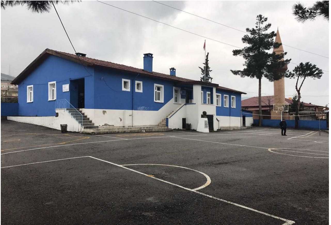
Teknepınar İlköğretim Okulu binası dış cephe boyası yapıldı.
