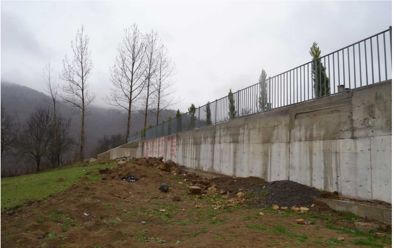
Yeşilpınar Mahallesi okul alanında betonarme duvar imalatı yapıldı.
