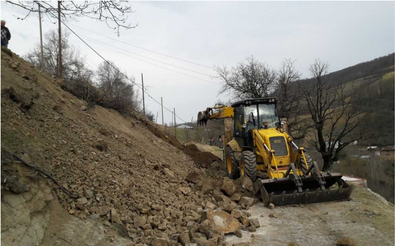
20-) YAYLA MAHALLESİ CAMİ TEMEL KAZI ÇALIŞMASI YAPILDI.
