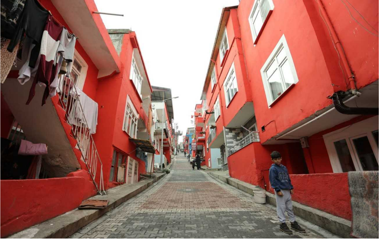
11-) YAVUZ SELİM MAHALLESİ BİNA DIŞ CEPHE BOYALARI YAPILDI.
