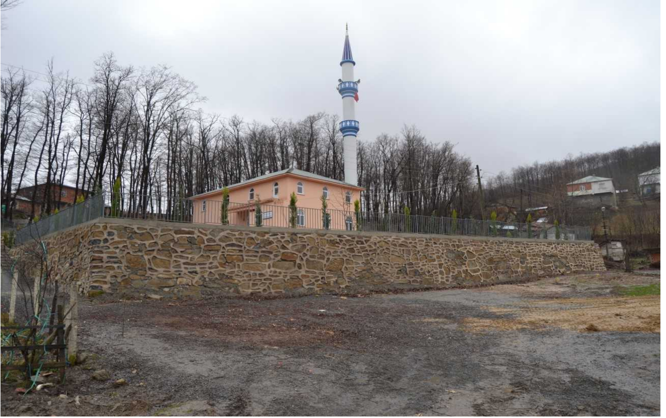
Düzardıç Mahallesi camii alanında betonarme duvar üzerine korkuluk imalatı yapıldı.
