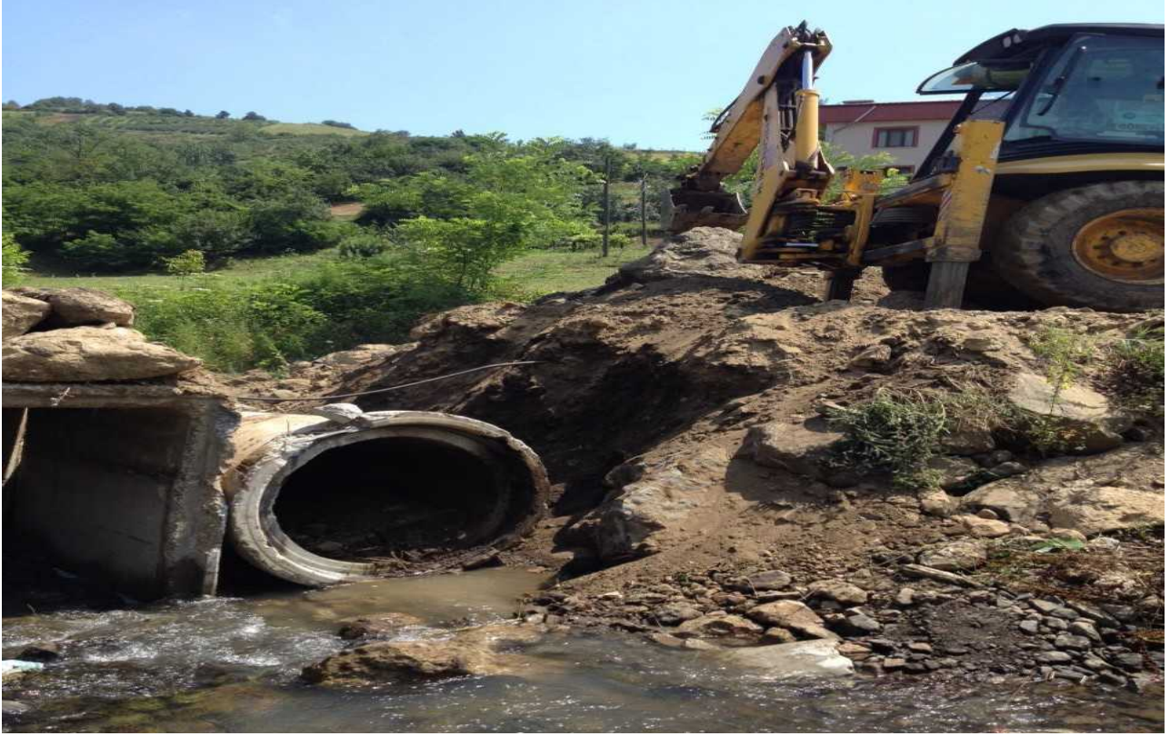
17-) ADATEPE MAHALLESİNDE YOL GEÇİŞİ ALT YAPI ÇALIŞMASI YAPILDI.
