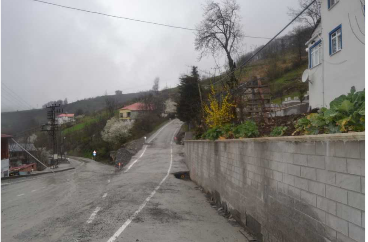
Kaşyayla Mahallesi Mahalle içinde beton yol çalışması
