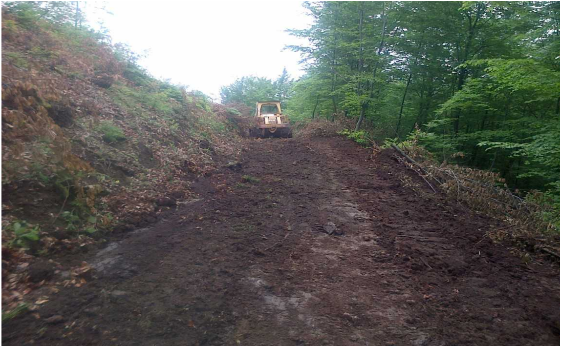
Kaşyayla mahallesi yol açma çalışmaları
