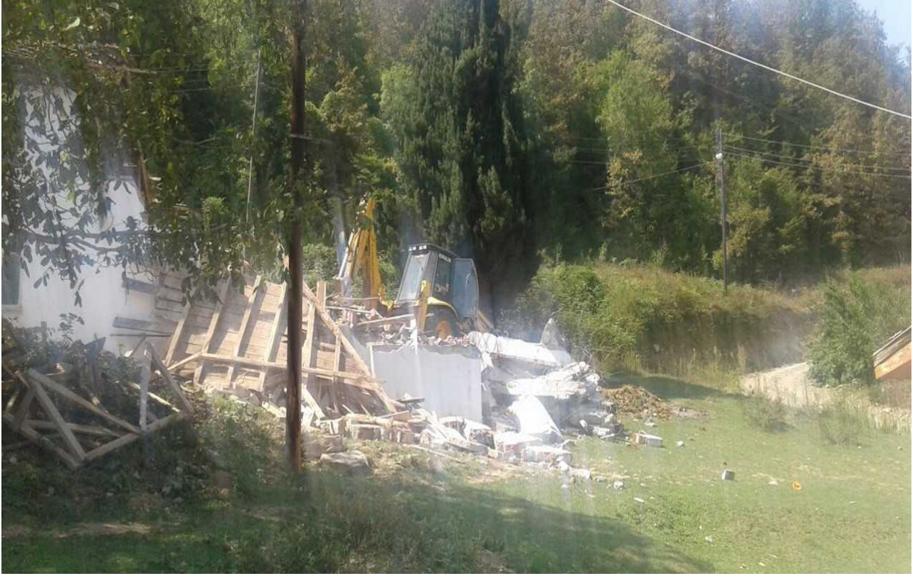
19-) ÜÇPINAR MAHALLESİ ESKİ CAMİNİN YIKIM ÇALIŞMASI YAPILDI.
