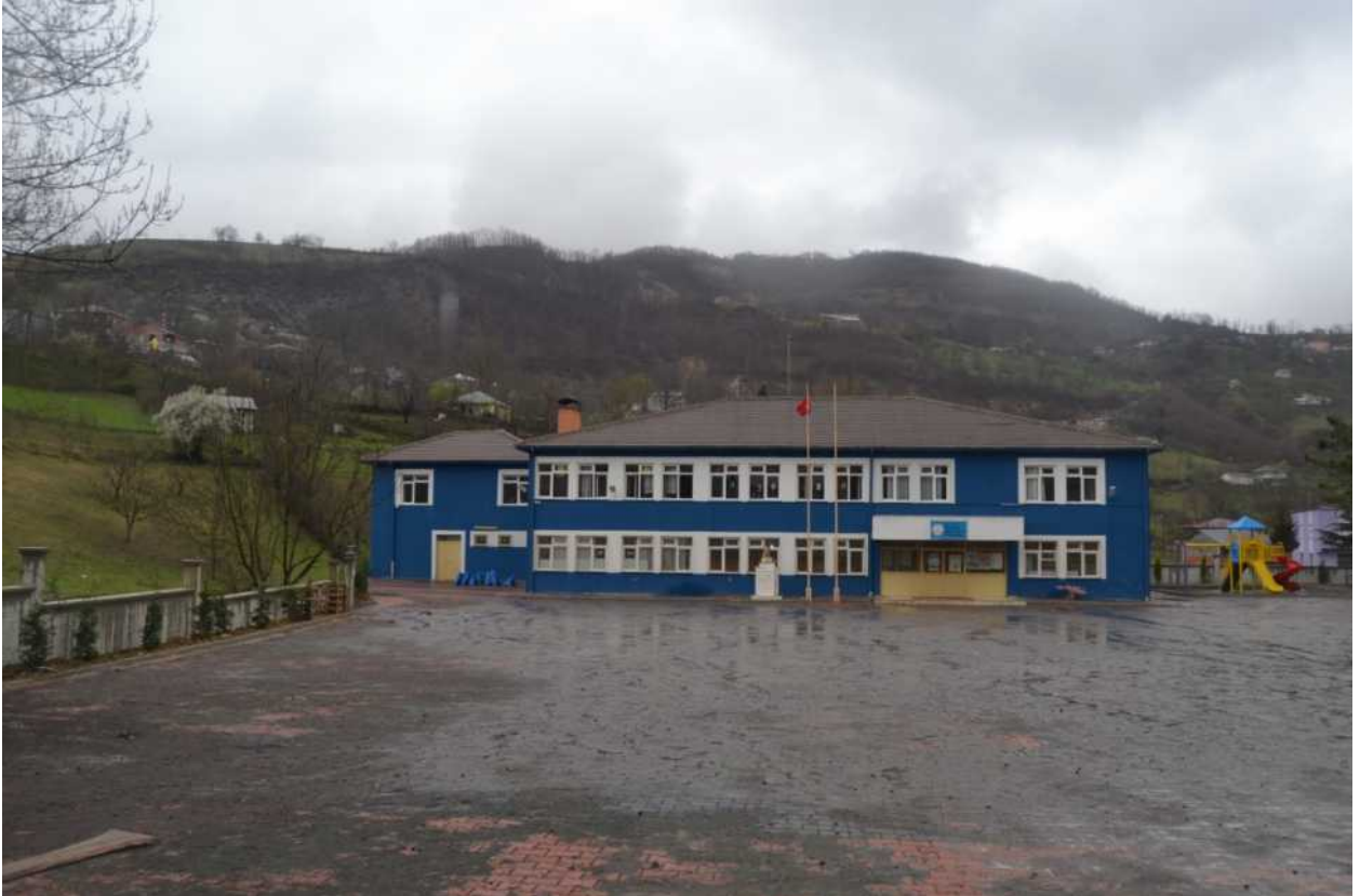
Gölalan İlköğretim Okul bahçesinde parke taş döşeme çalışması yapıldı.
