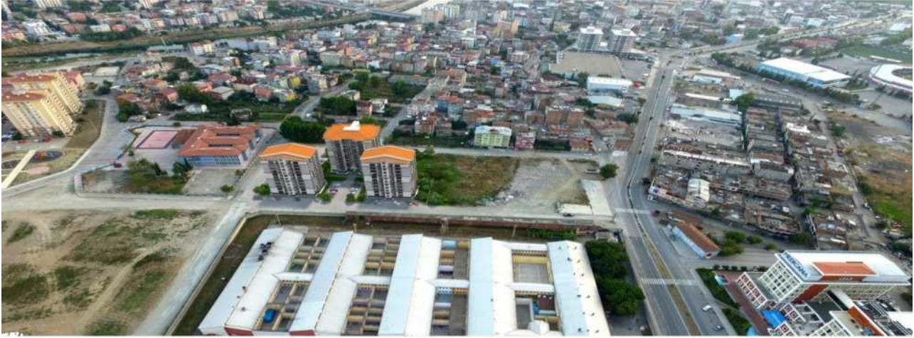
Kuzeyyıldızı Mahallesi 127 Konut Projesi.
