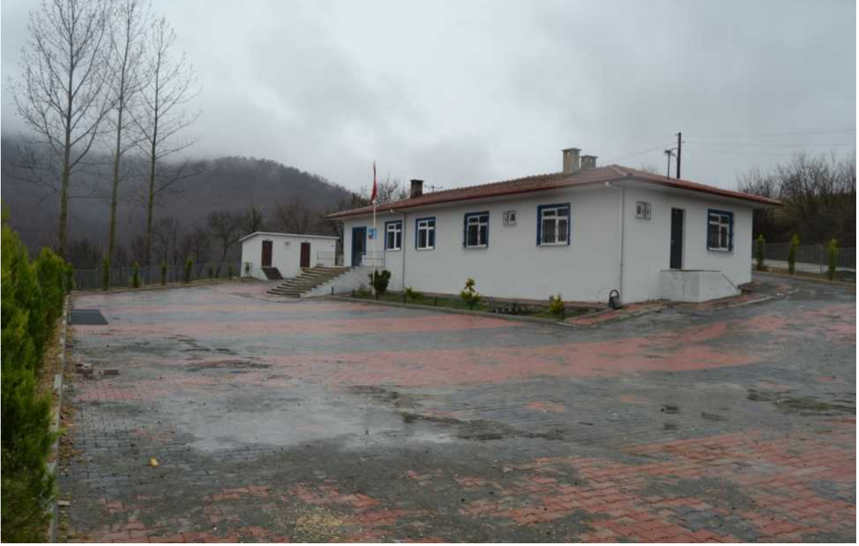
Yeşilpınar İlköğretim Okul bahçesinde parke taş döşeme çalışması yapıldı.
