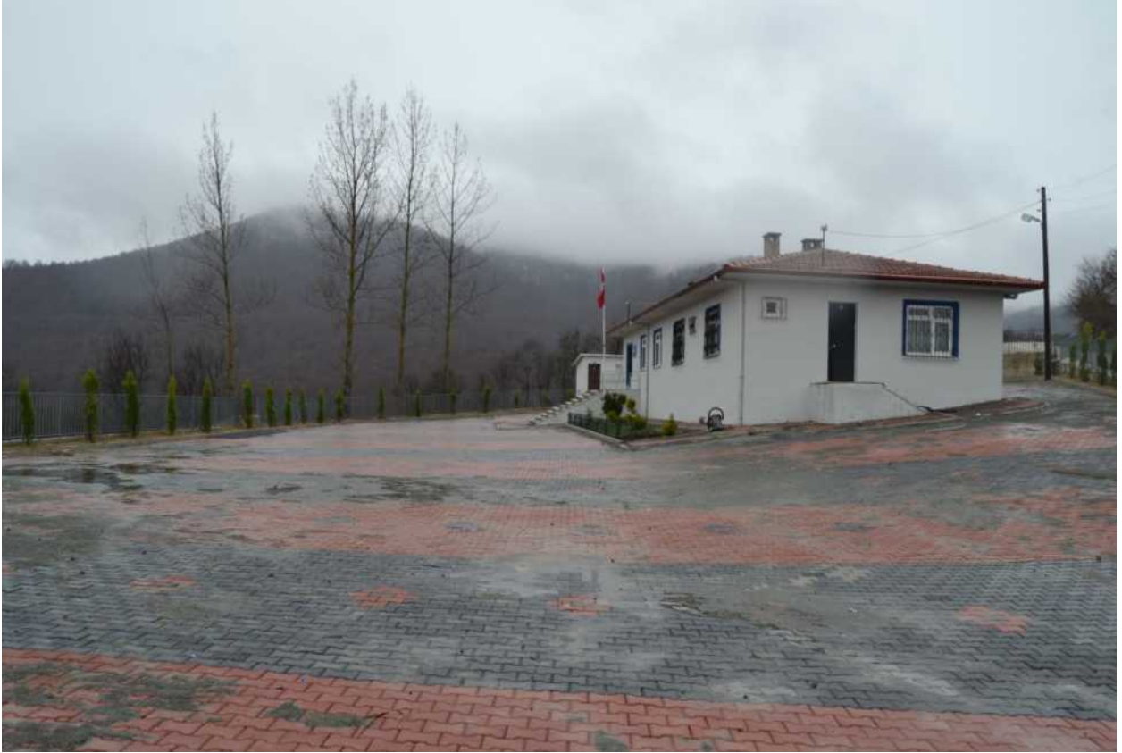
Yeşilpınar Mahallesi okul alanında betonarme duvar üzerine korkuluk imalatı yapıldı.
