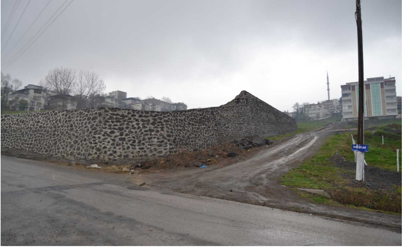
Hacı İsmail Mahallesi halı saha inşaat alanında taş duvar imalatı yapıldı.
