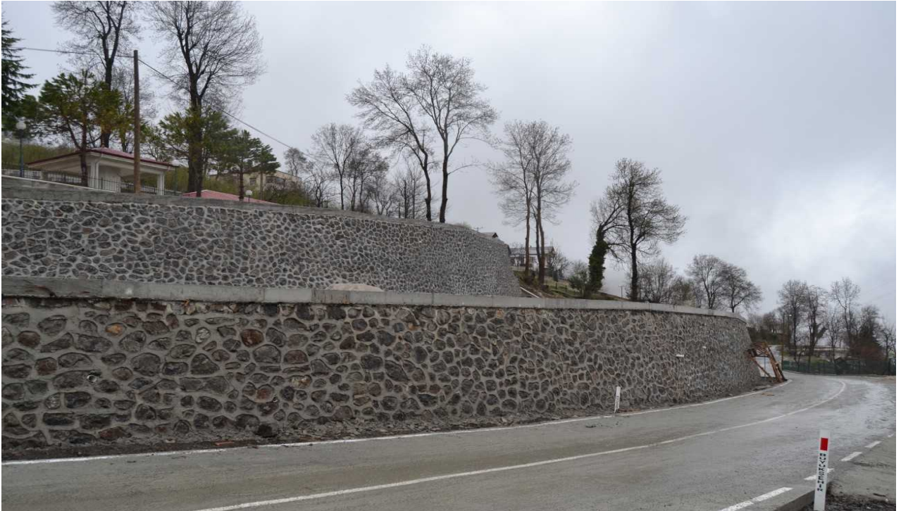
Kaşyayla Mahallesi hanım konağı inşaat alanında taş duvar imalatı yapıldı.
