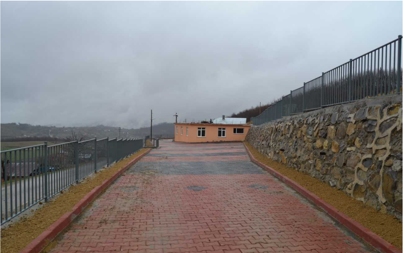
Düzören Mahallesi camii alanında betonarme duvar üzerine korkuluk imalatı yapıldı.
