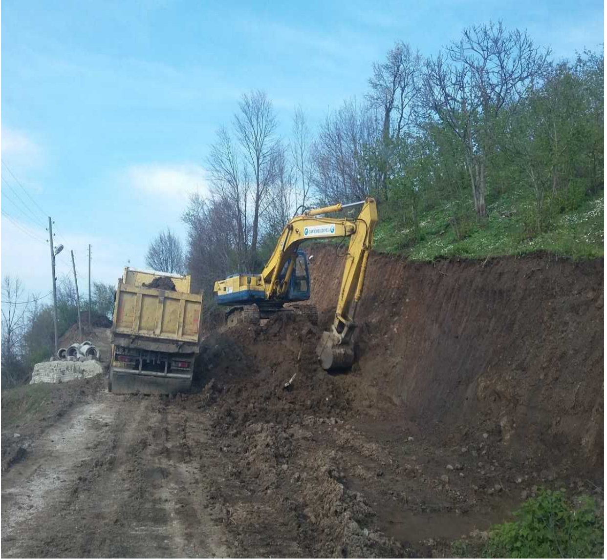
Gültepe mahallesi yol açma çalışmaları
