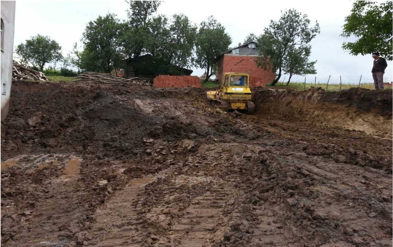
18-) HACINAİPLİ MAHALLESİ CAMİİ LOJMAN TEMEL KAZISI ÇALIŞMASI YAPILDI.
