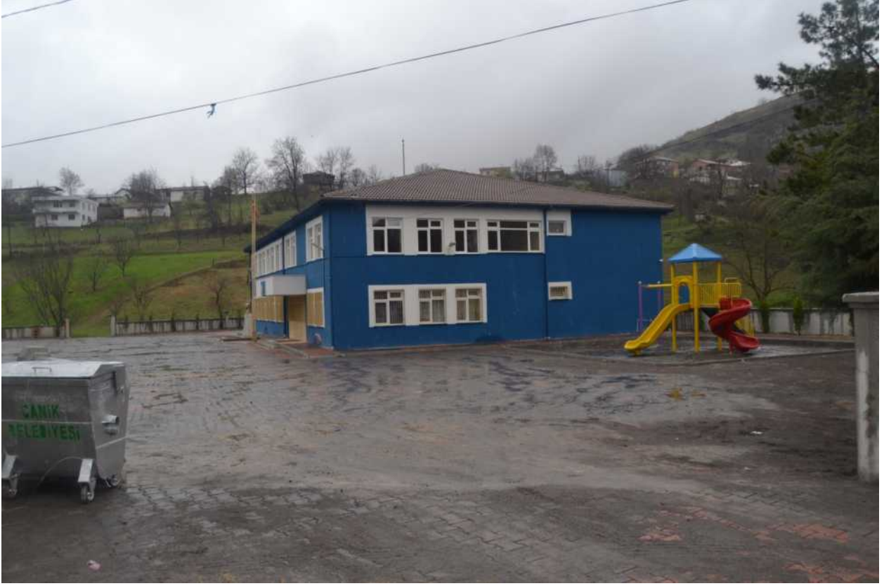
Gölalan İlköğretim Okul bahçesi etrafı betonarme duvarlar çalışması yapıldı.
