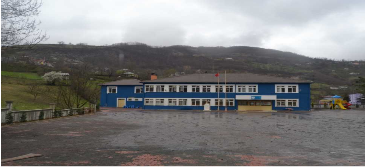
Gölalan İlköğretim Okulu dış cephe boya çalışması yapıldı.
