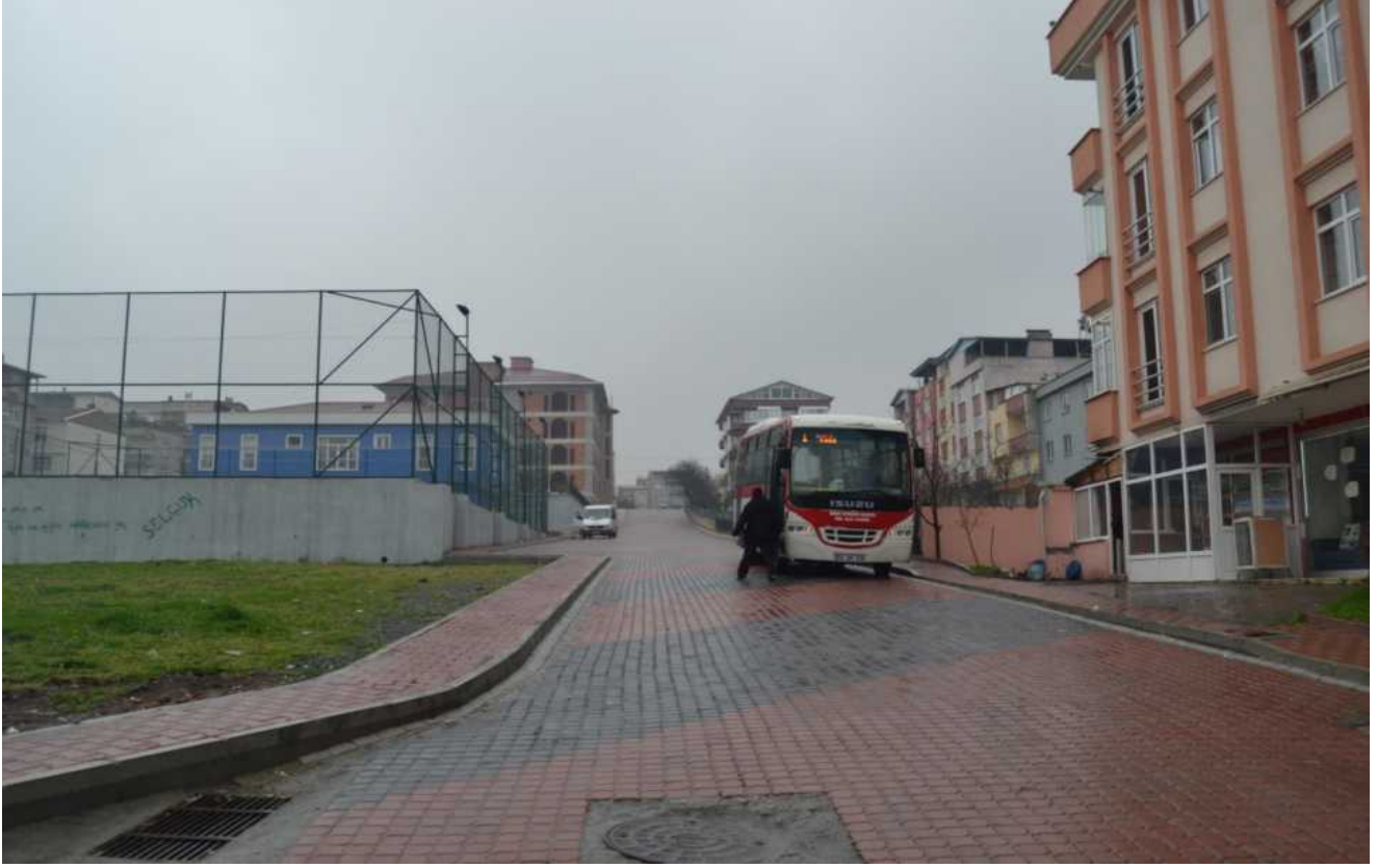
Gazi Osman Paşa Mahallesi hanım konağı ve halı saha çevresinde betonarme duvar imalatı yapıldı.
