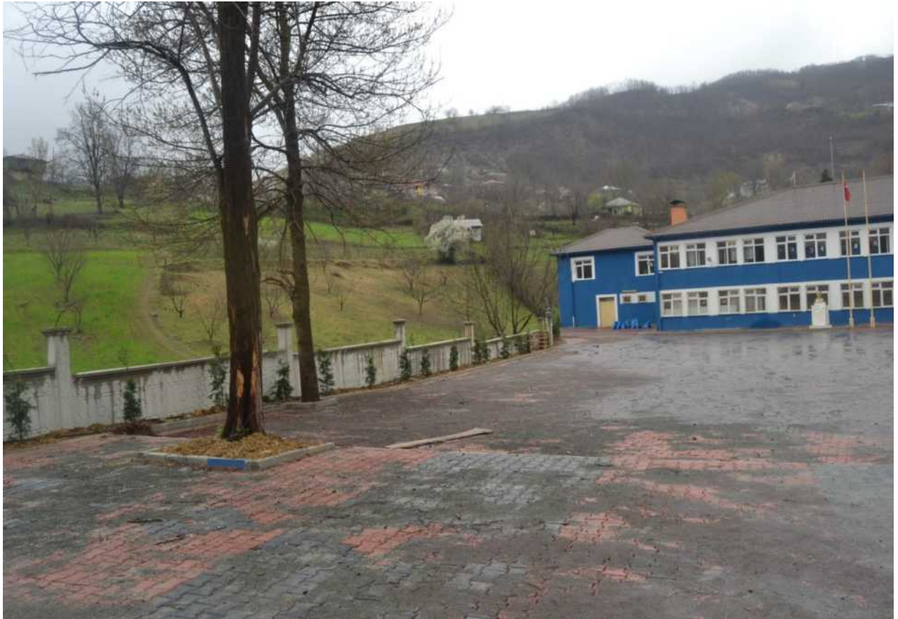
Gölalan Mahallesi okul alanında betonarme duvar imalatı yapıldı.
