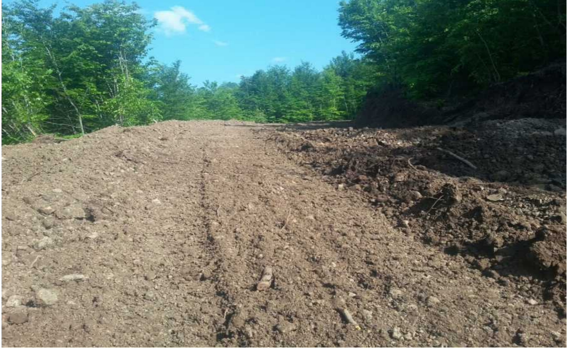
İlçemizde 2016 yılında 5160.00 metre yol açma çalışmaları yapıldı.
