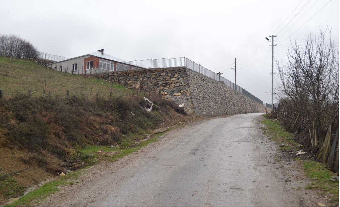
Düzören Mahallesi camii alanında taş duvar imalatı yapıldı.
