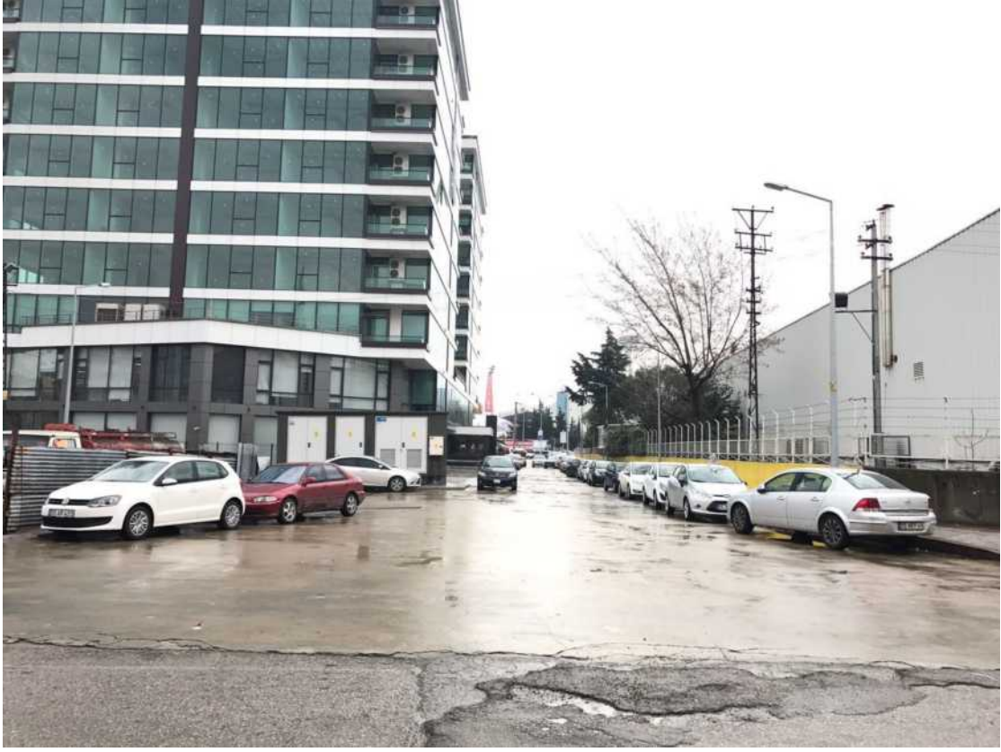
Yeni Mahalle Mahallesi 104. Sokakta beton yol çalışması.
