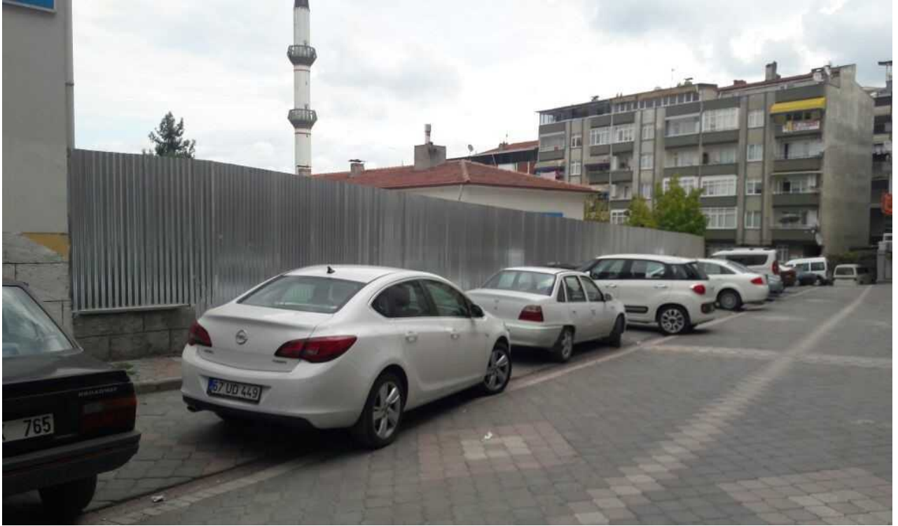
Belediye Evleri İmam Hatip Orta Okulu bahçesine bahçe duvarına sac montajı yapıldı.
