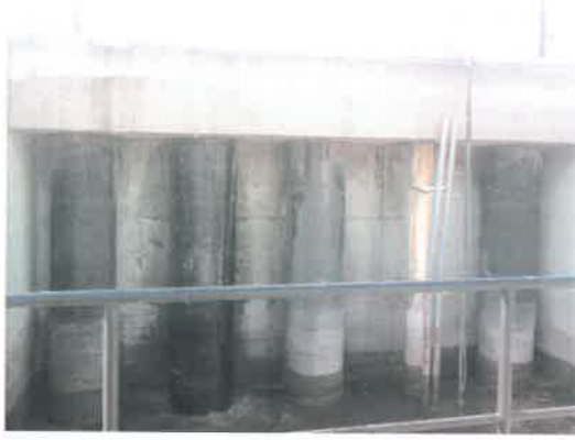
(Terfi Pompa İstasyonu)
