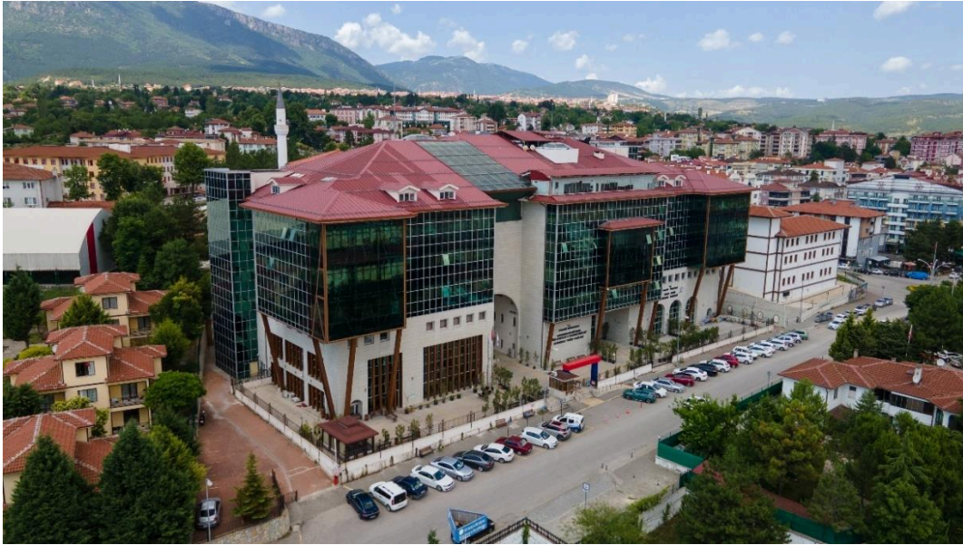
Resim 10. Safranbolu Fethi Toker Güzel Sanatlar ve Tasarım Fakültesi Binası
