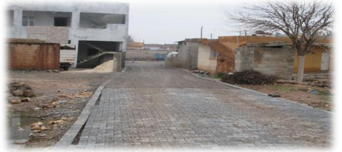
Suruç Beton Parke
