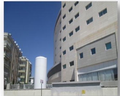
Oksijen araçları gaz boşaltımı
