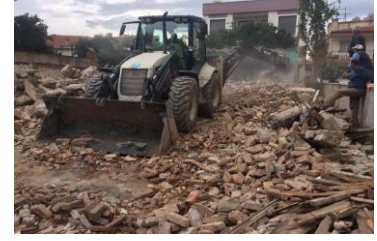
Metruk Bina Yıkımı
