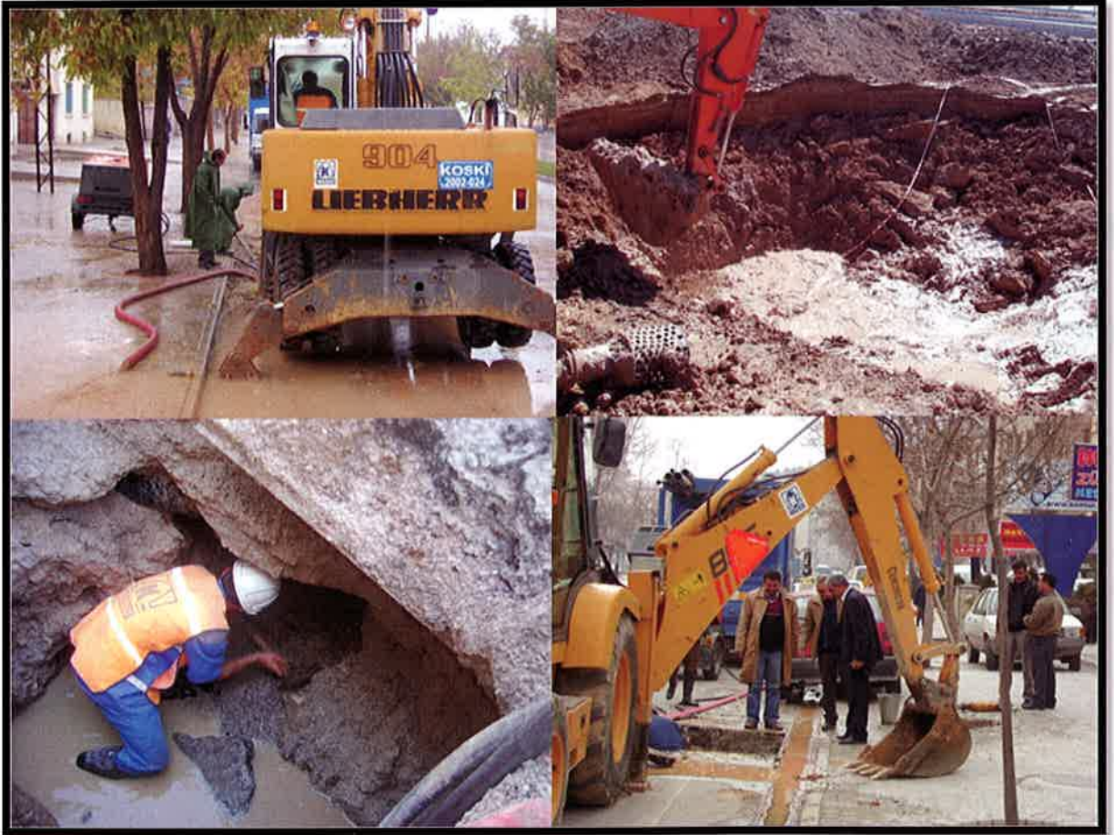
İçme Suyu Şebekesi ArızasıYapım Çalışmalarından Görüntüler
