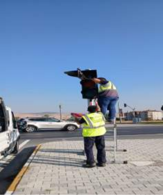
Sanayi 3. Kapı Kavşağı (Sinyalizasyon Bakım ve Onarım Çalışması)
