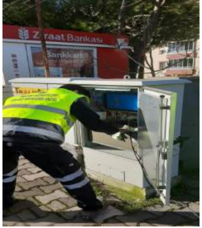
Şehir Merkezi (Kavşak Kontrol Cihazı Bakım ve Onarım Çalışması)
