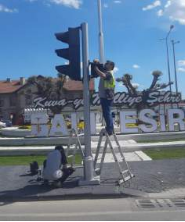
İstasyon Kavşağı (Sinyalizasyon Bakım ve Onarım Çalışması)
