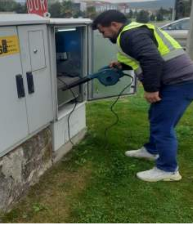
Şehir Merkezi (Kavşak Kontrol Cihazı Bakım ve Onarım Çalışması)
