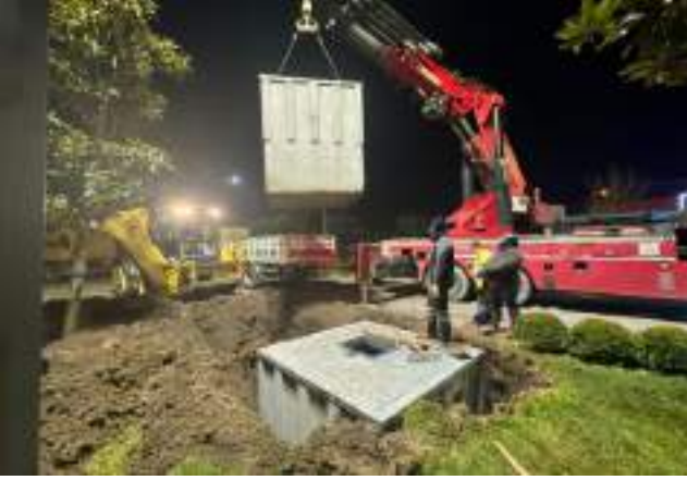
Yeraltı Konteyneri Yerleştirilmesi
