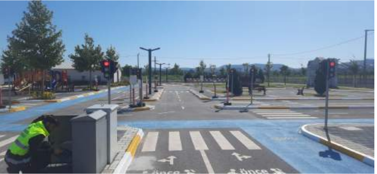
Çocuk Trafik Eğitim Parkı Sinyalizasyon Bakım ve Onarım Çalışması
