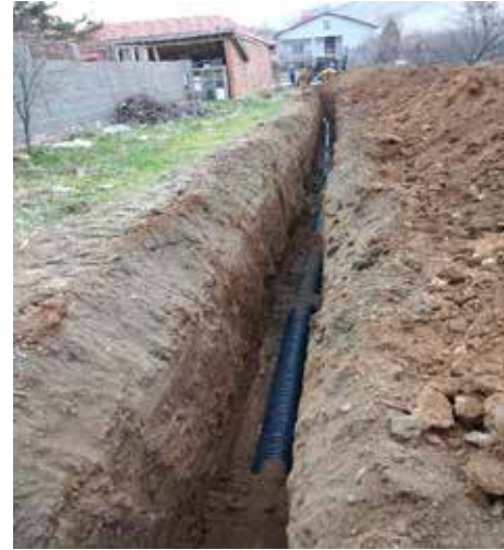
SARAYÖNÜ LADİK MH. KANALİZASYON ŞEBEKE HATTI YAPIMI
