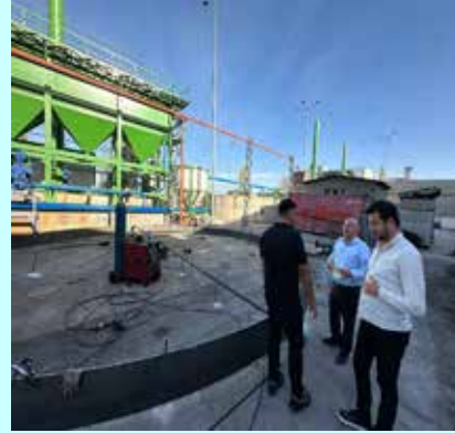
Süt arıtma tesisi revizyon çalışmaları
