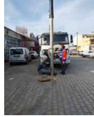
ÇUMRA ÇAYBAŞI MH. KANAL TEMİZLEME FAALİYETİ
