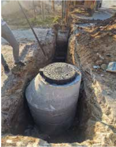
KULU KEMALİYE MH. KANALİZASYON ŞEBEKE HATTI YAPIMI
