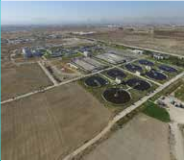
ÇAVDAR DOĞAL ATIKSU ARITMA TESİSİ
