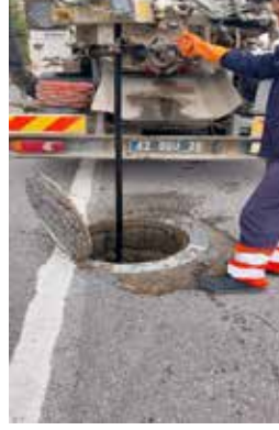
SEYDİŞEHİR PINARBAŞI MH. KANAL ŞEBEKE ARIZASININ GİDERİLMESİ
