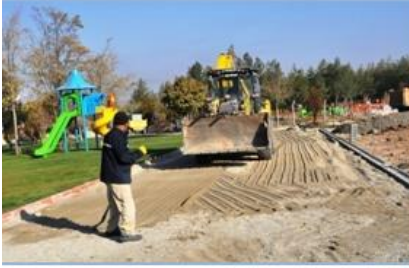
PARK BAHÇE MÜDÜRLÜĞÜ DÜZENLEME ÇALIŞMASI
