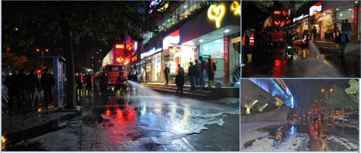
Turgut Özal Bulvarı Köpüklü Su ile Yıkama çalışmaları
