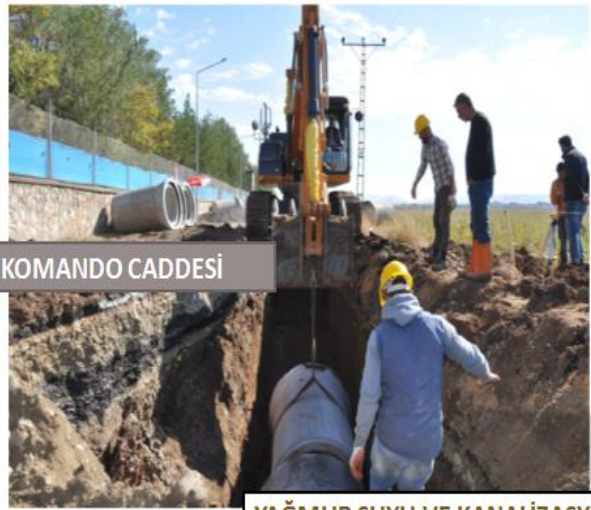
YAĞMUR SUYU VE KANALİZASYON ŞEBEKESİ
