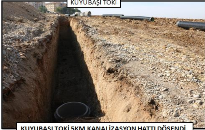
KUYUBAŞI TOKİ 5KM KANALİZASYON HATTI DÖŞENDİ
