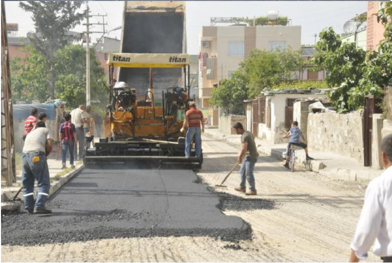
Asfalt yama ve kaplama çalışmaları
