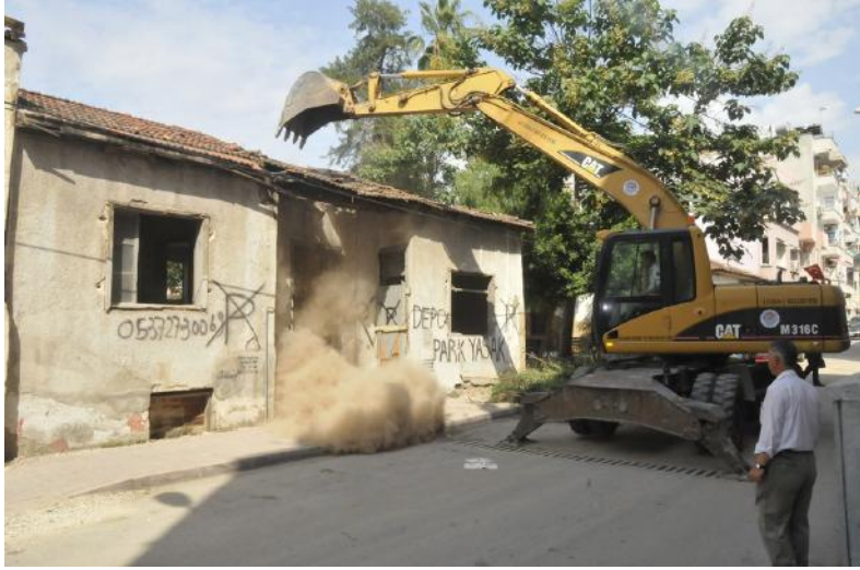
Harabe yapıların yıkılması
