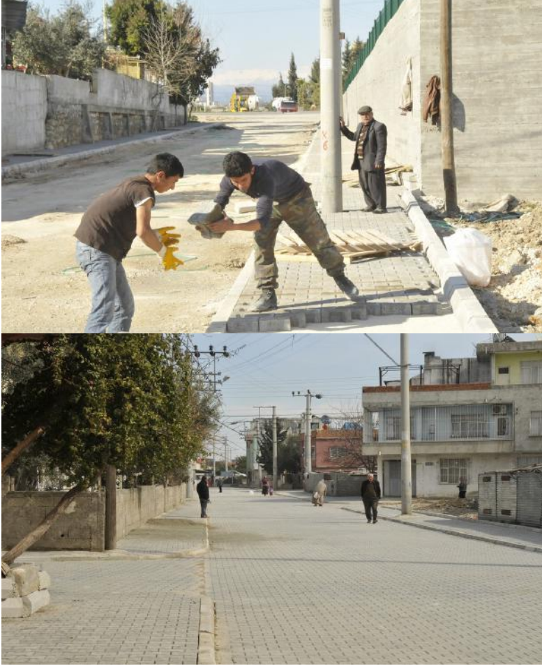
Yol ve Kaldırım çalışmaları
