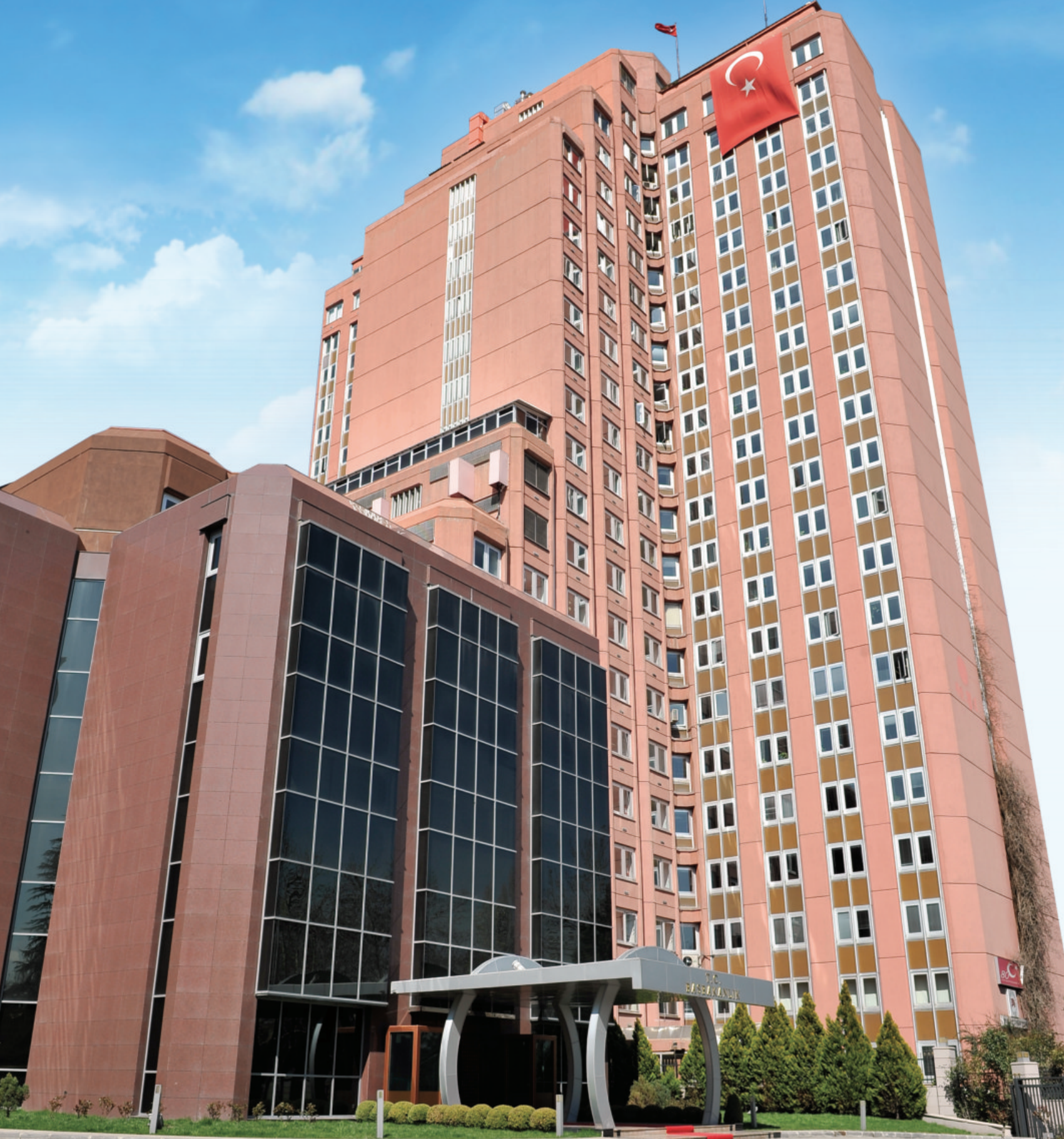
Bařbakanlık Yeni Bina
