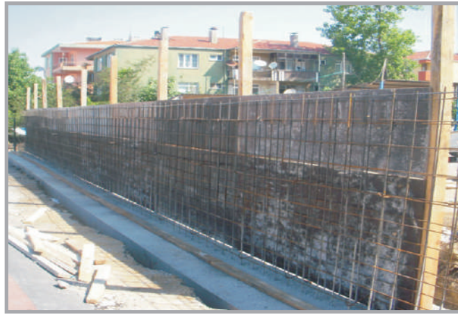
Perde Duvar Çalışmalarından Görüntü.
