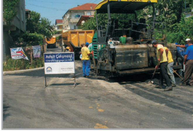
Asfalt Çalışmalarından Görüntüler.
