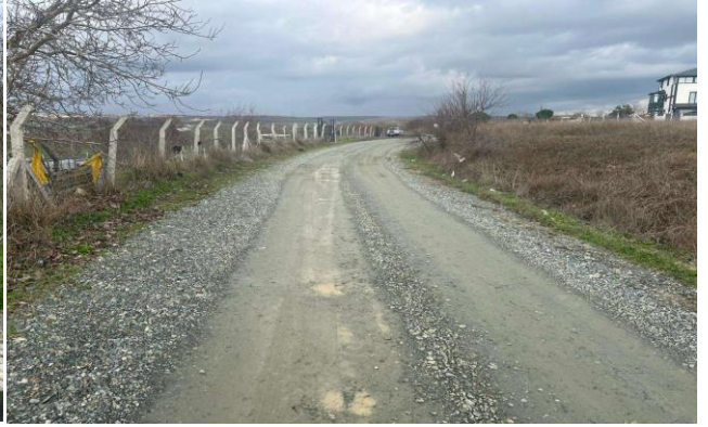
Yeni Mahalle Şubat Sokak
