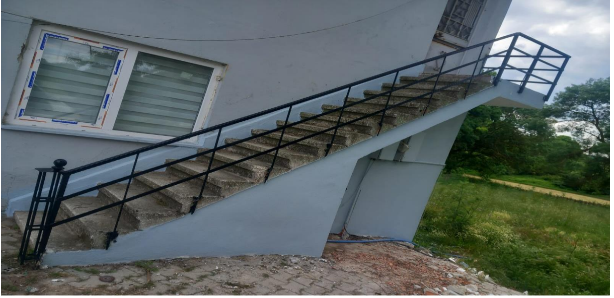
Ayvacak Mahalle Muhtarlığı Binası Merdiven Korkuluğu Yapımı
