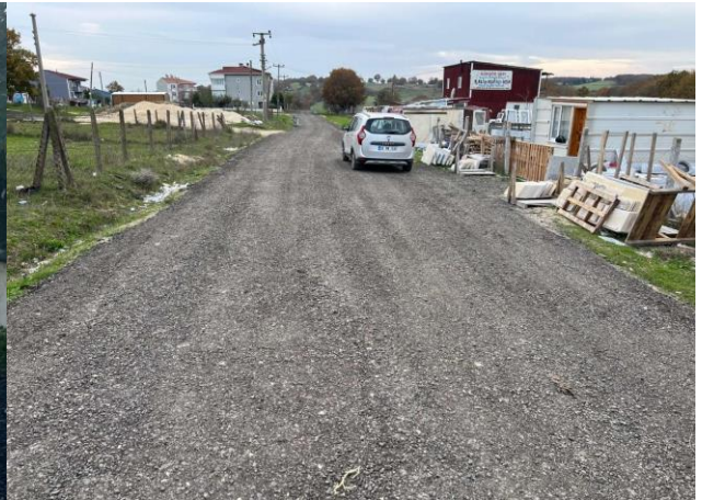
Atatürk Mahallesi Eşref Bitlis Caddesi
