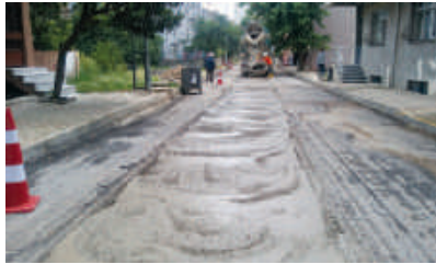
YAYLA MAHALLESİ ÖZTUNÇ SOKAK
