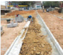
Bordür, şev taşı uygulaması
