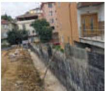
Duvar ( kalıp, beton ) çalışması
